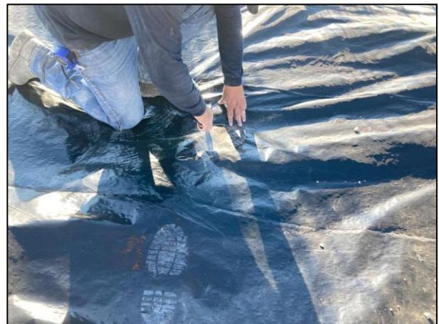
06. Con apoyo de un cutter se realizó el corte de la película de polietileno de alta densidad para la colocación de los tubos.
