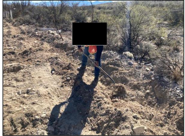
02. El sitio fue debidamente acondicionado para realizar la barrera de contención, a fin de evitar el desplazamiento horizontal del hidrocarburo.
