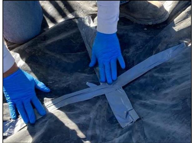
10. Efectuadas la toma de muestras dentro de la Zona afectada, las incisiones realizadas fueron debidamente selladas con apoyo de cinta industrial.
