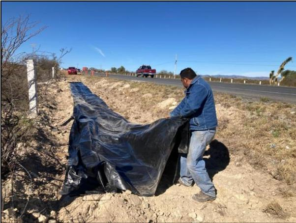
03. El área afectada fue cubierta con una película de polietileno de alta densidad para evitar la transferencia suelo – atmósfera del hidrocarburo derramado.
