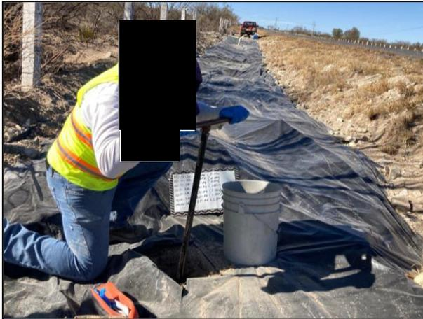
09. Se llevó a cabo la toma de muestras a diferentes profundidades con apoyo del Hand Auger dentro de la Zona afectada.
