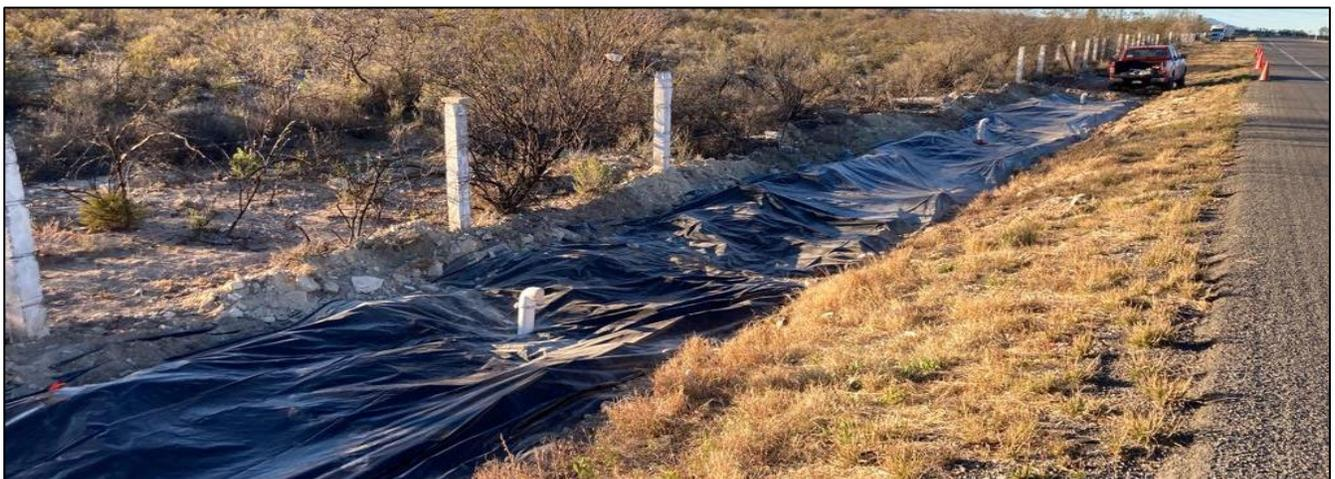
11. Vista del Área afectada cubierta con la película de polietileno de alta densidad y los filtros de carbón activado instalados.
