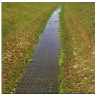
Figura II. 3. Obras de drenaje pluvial propuestas con tecnología Shoreblock
