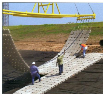
Figura II. 3. Obras de drenaje pluvial propuestas con tecnología Shoreblock
