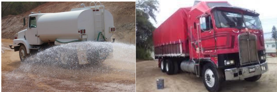
Figura VI.1 Ejemplo de A) Riego del suelo para evitar partículas suspendidas, b) vehículo protegido con lona para evitar la dispersión de partículas.
