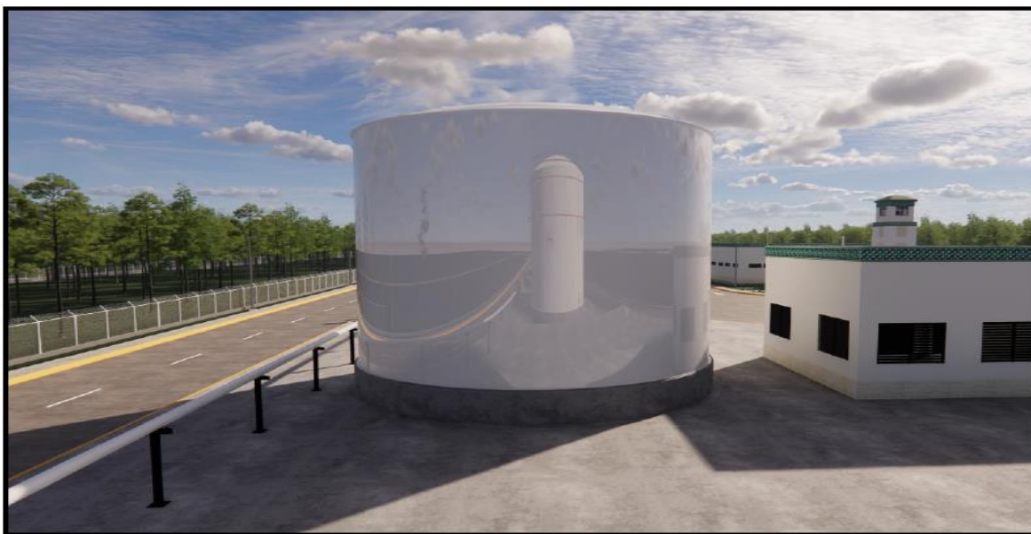
Figura II.25 Render tanque vertical atmosférico de agua
