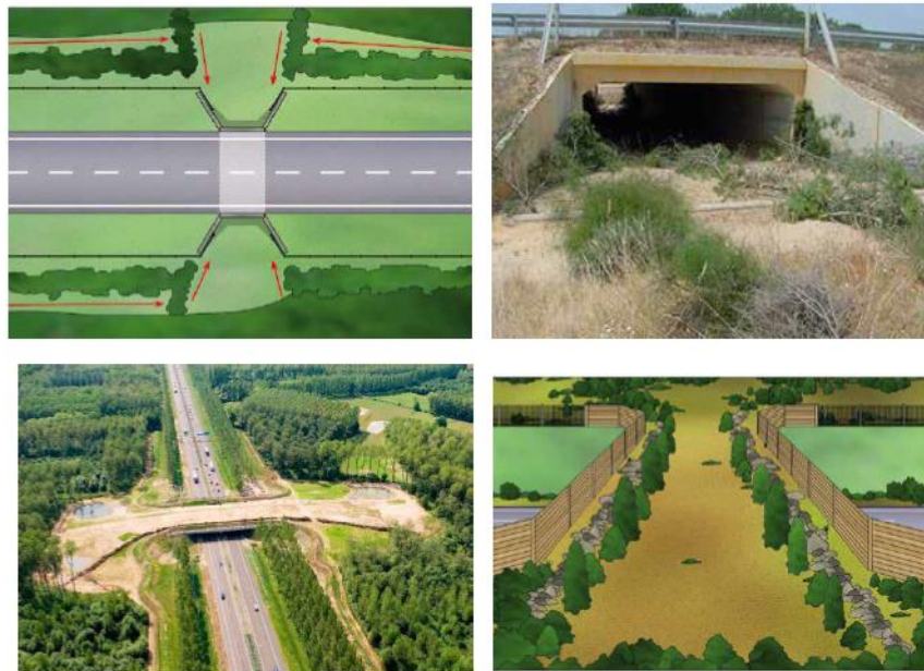
Figura VI.11 Ejemplo del acondicionamiento de los pasos de fauna.
