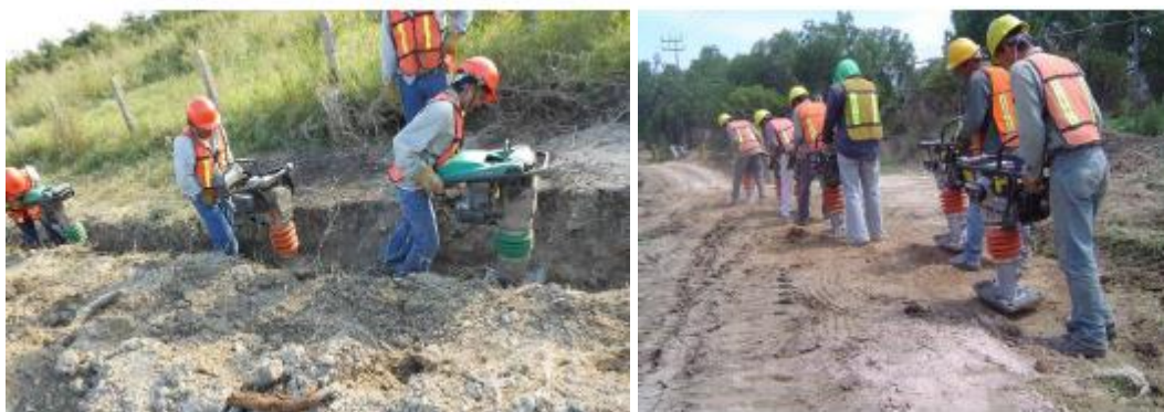
FIGURA 28. RELLENO Y COMPACTACIÓN
