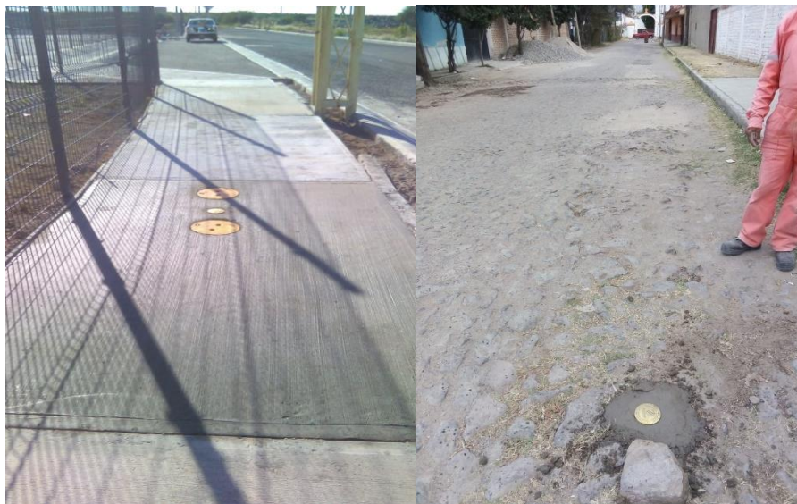
FIGURA 40. LIMPIEZA DEL SITIO
