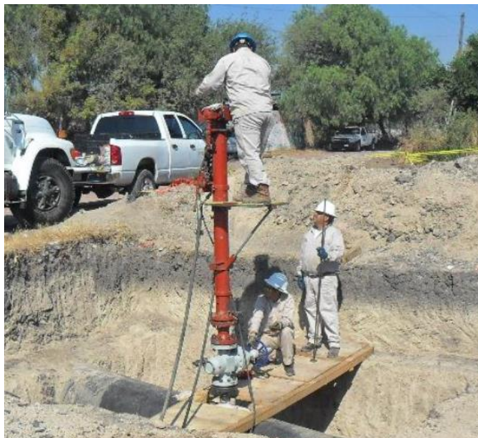
FIGURA 23. PUESTA EN MARCHA DE UN HOT TAPPING, EJEMPLO.
