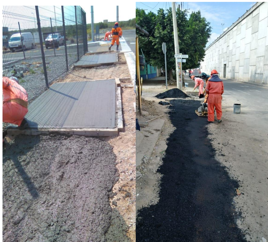
FIGURA 39. REPOSICIÓN DE PAVIMENTO O BANQUETAS
