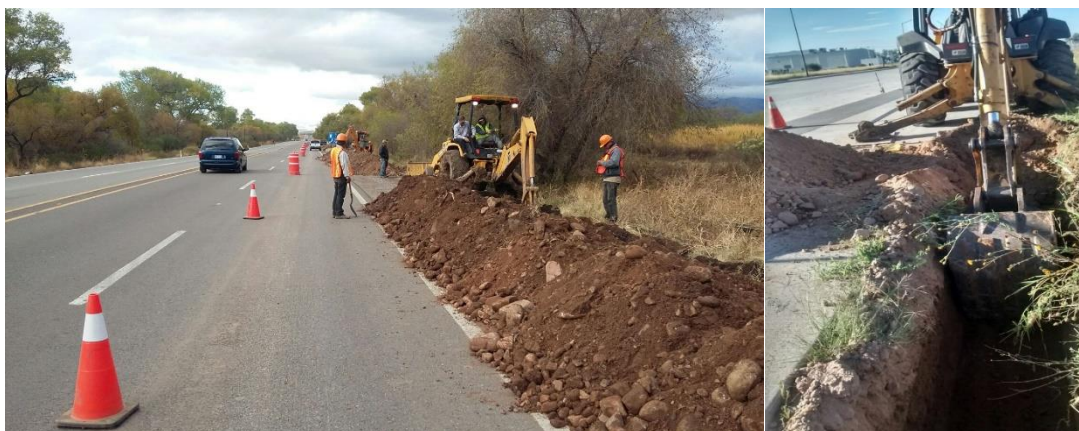
FIGURA 24. APERTURA DE ZANJA, EJEMPLO.
