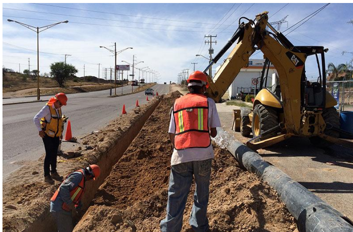
FIGURA 26. INSTALACIÓN DE TUBERÍA
