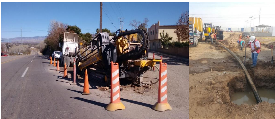
FIGURA 32. PERFORACIÓN DIRECCIONAL
