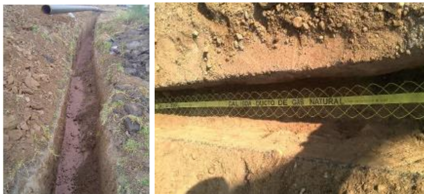
FIGURA 27. INSTALACIÓN DE TUBERÍA
