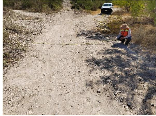
**Foto 3. Personal técnico haciendo trabajos de campo, demostrando que el ancho de los caminos existentes es suficiente para llevar a cabo las actividades de construcción del proyecto. En las fotografías, las mediciones que se indican demuestran los 3 m de ancho en el DDV que se requieren para llevar a cabo las actividades de preparación del sitio y construcción del proyecto, en donde, además, se respetará en todo momento la vegetación existente aledaña a los caminos de terracería.**
