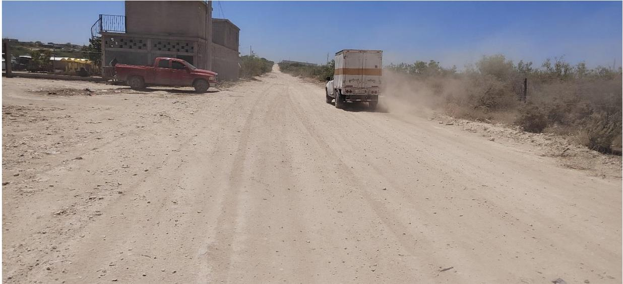
**Foto 6. Camino de terracería existente y que es empleado por las empresas que operan en el Parque Industrial La Paz al Poniente de la Ciudad de Acuña, Coah., apreciándose que se encuentra desprovisto de vegetación y cuenta con las dimensiones suficientes (7 m de ancho) para poder albergar las actividades de preparación del sitio y construcción del Proyecto, ya que para tal fin solo son necesarios 3 m de ancho sobre la trayectoria del STGN.**
