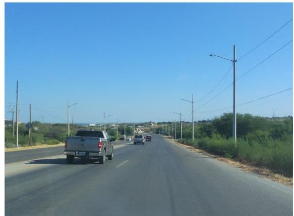
**Fotos 1 y 2. Vista de la carretera Estatal 29 Morelos – Ciudad Acuña, por donde se tiene proyectado la instalación del Sistema de Transporte de Gas Natural, apreciándose que esta carretera se encuentra pavimentada, y es precisamente sobre la carpeta asfáltica por donde quedará instalado el STGN con la finalidad de no causar afectaciones a la vegetación de MET existente a los costados del DDV de la carretera.**
