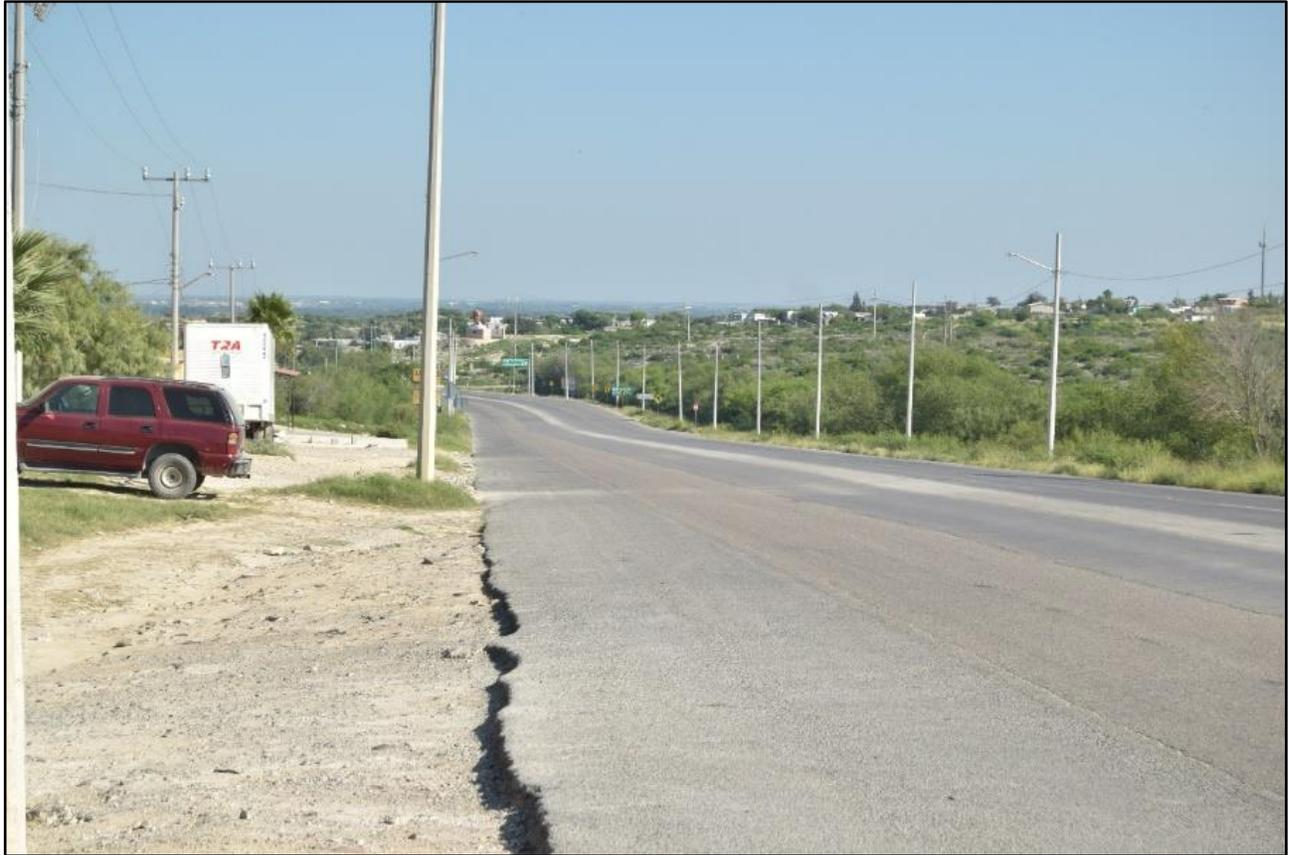
**Foto 3. Vista de la carretera Estatal 29 Morelos – Ciudad Acuña, por donde se tiene proyectado la instalación del Sistema de Transporte de Gas Natural, apreciándose que esta carretera se encuentra pavimentada, y es precisamente sobre la carpeta asfáltica por donde quedará instalado el STGN con la finalidad de no causar afectaciones a la vegetación de MET existente a los costados del DDV de la carretera.**
