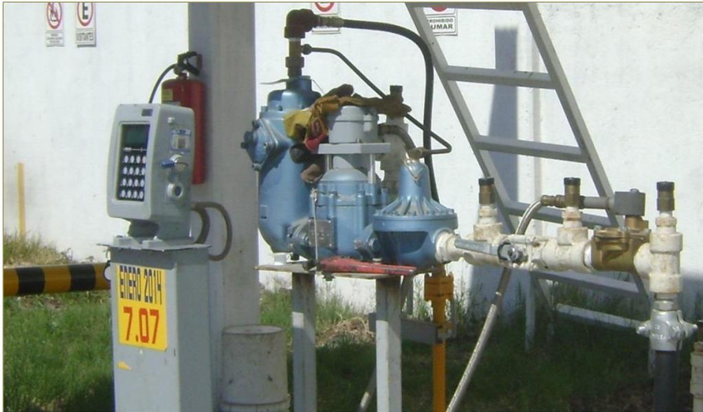
Figura III.1.c)-1. Dispensario doble para el Gas L.P.
