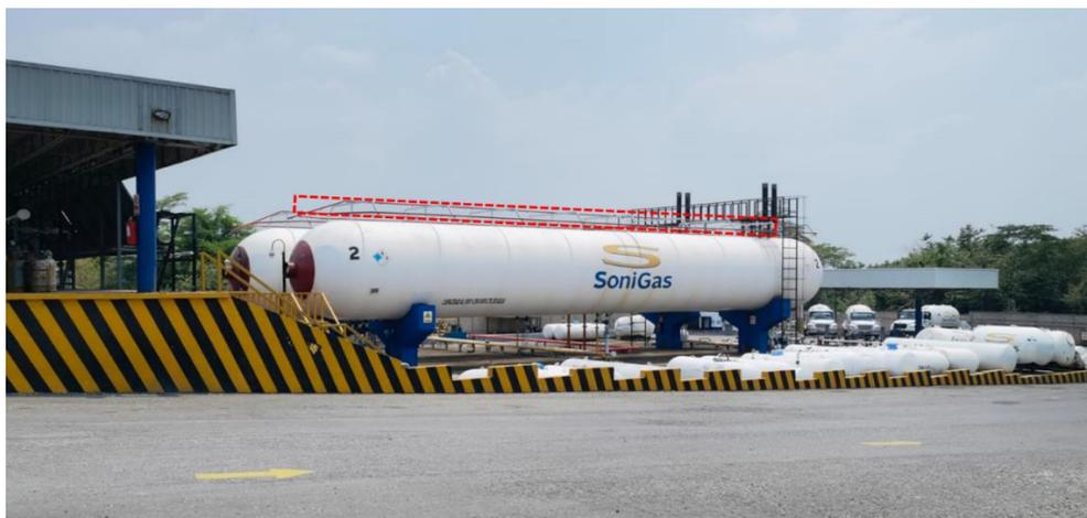
**Figura IV.2.** Sistema de aspersión del recipiente de almacenamiento
