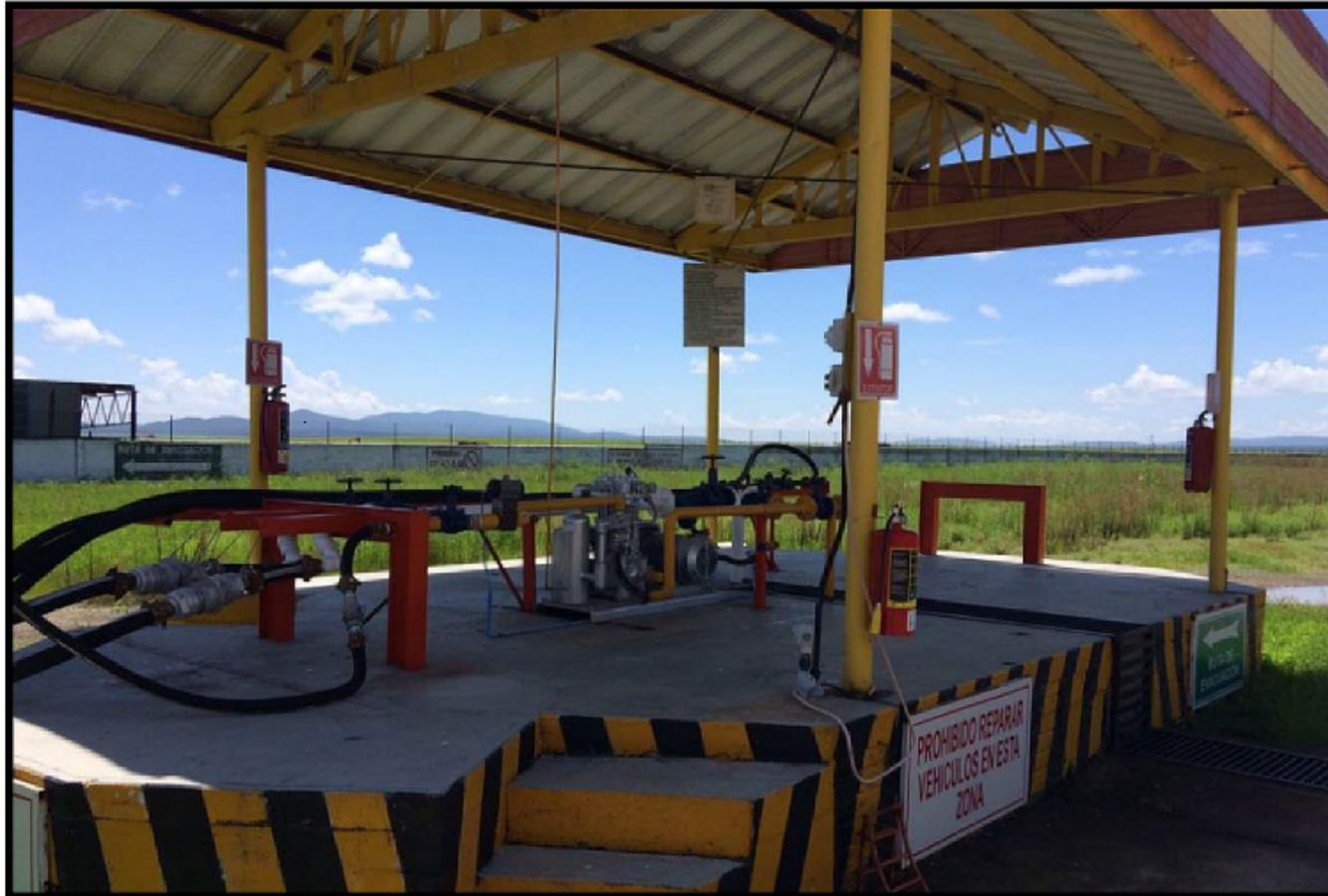
**Fotografía 4:** Toma de recepción de semirremolque
