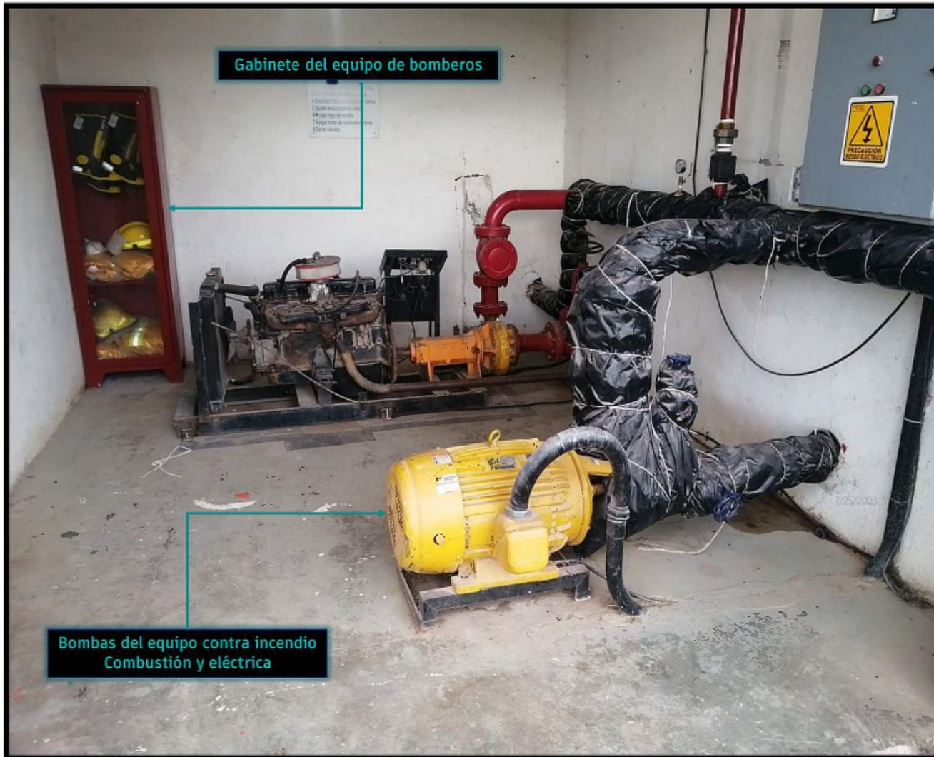
Fotografía 10: Bomba de combustión y eléctrica del sistema contra incendio
