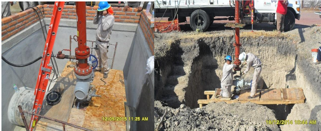
Figura 17. Perforación o Hot Tapping.
