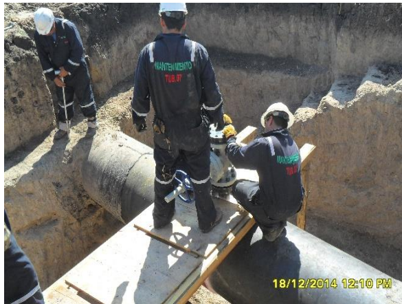
Figura 16. Colocación de válvula
