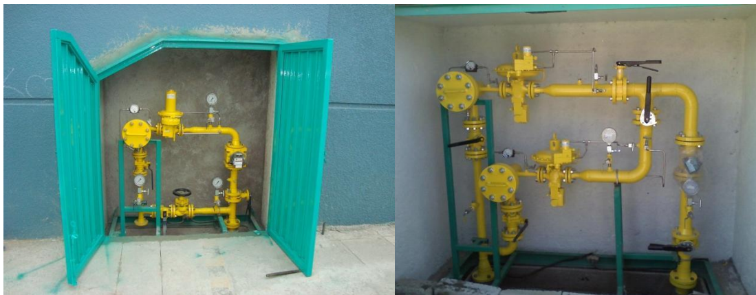
Figura 14. Gabinetes Tipo para Estaciones de Regulación y Medición a usuarios
