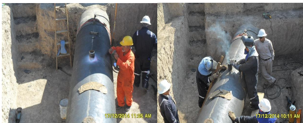
Figura 15. Colocación de niple y envolvente
