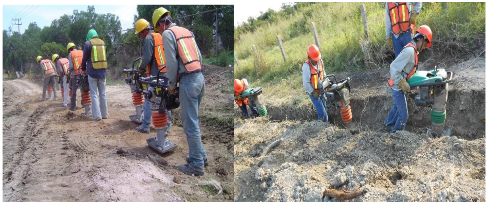
Figura 9. Relleno y Compactación
