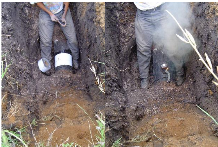
Figura 3. Tipo de soldadura Cadweld y reparación de recubrimiento de tubería
