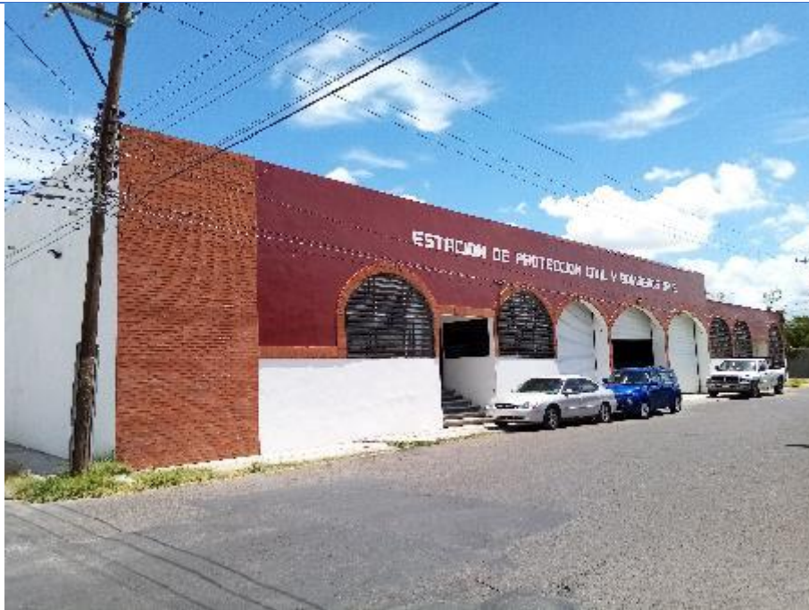
Fotografía No. I.3.- El agrupamiento de protección civil y bomberos representa un grupo de apoyo externo en caso de una emergencia en la red de distribución.
