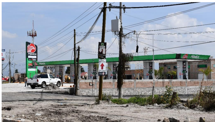
Figura 5.- Las gasolineras representan puntos de almacenamiento de combustibles que pudieran generar una interacción de riesgo, sin embargo, se observa en la mayoría de las gasolineras, que los tanques de almacenamiento de combustibles son subterráneos.
