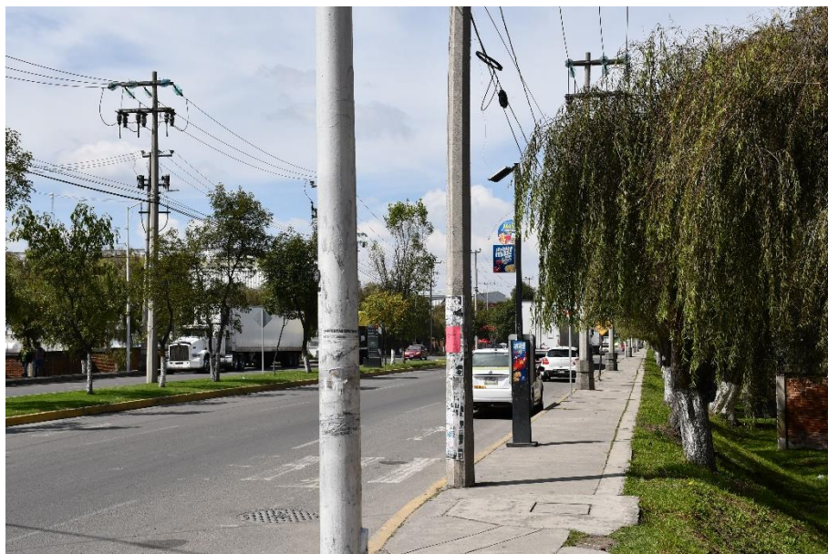
Figura 6.- equipamiento urbano. Se aprecia la existencia de tendido eléctricos y redes de drenaje.
