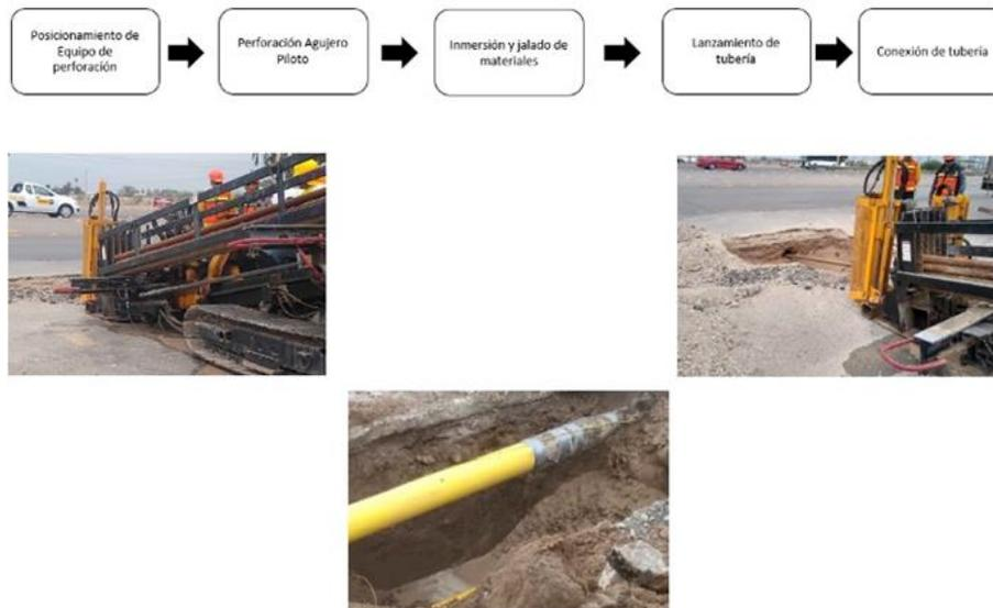
**Figura 33 Ejemplo del procedimiento de la perforación direccional.**
