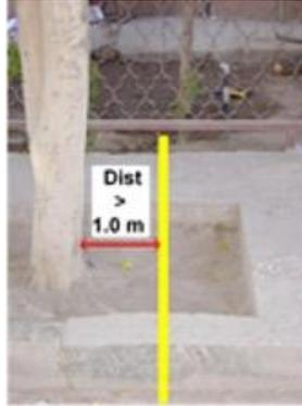
**Figura 16** Ejemplo de separación de troncos y/o raíces.
