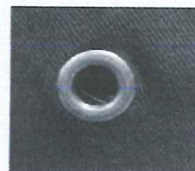
Ojillos de ventilación
