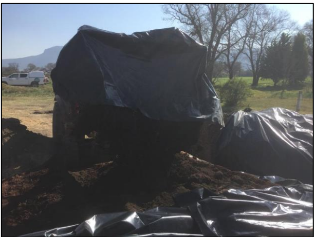
33.- Con el apoyo de retroexcavadora se colocó la segunda capa de material edáfico extraído en Celda Provisional, manteniendo cubierto el material edáfico en todo momento.
