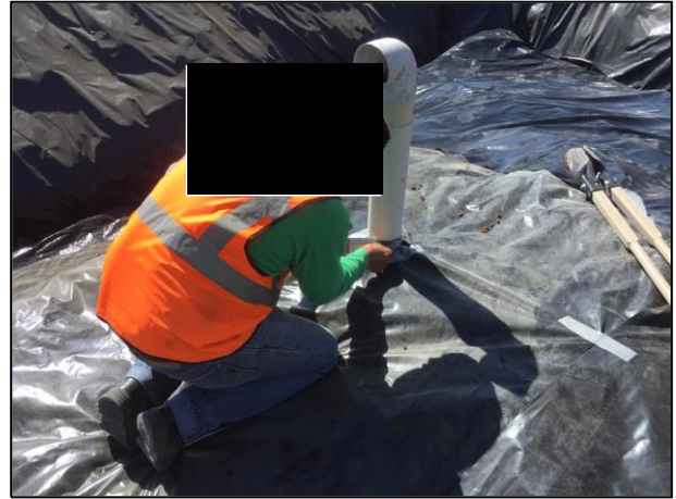
38.- Colocación de tubos PVC con filtros de carbón activado en la elevación superficial de la Celda Provisional, esto con el objetivo de impedir la transferencia de hidrocarburos volátiles al medio ambiente.
