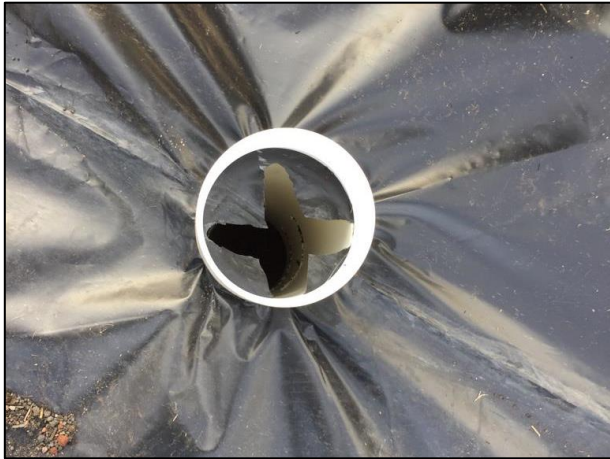
07.- Se realizó el corte de la cubierta de película de alta densidad para la colocación de filtros de carbón activado.
