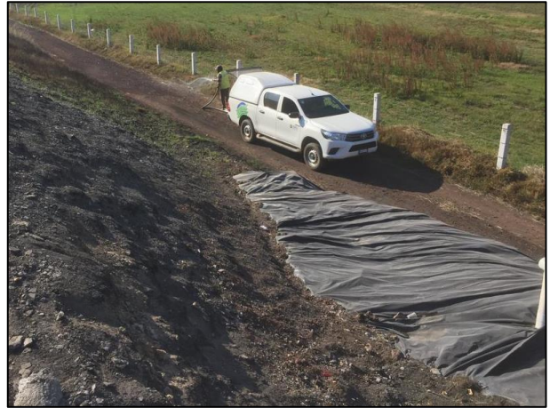
20.- Se realizó humectación en la Zona afectada C previo a la extracción del material edáfico.
