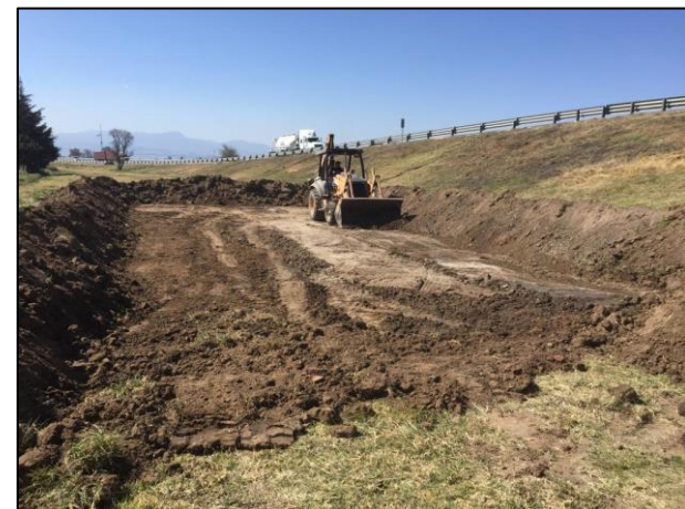
12.- Construcción de los bordos perimetrales de la Celda Provisional.
