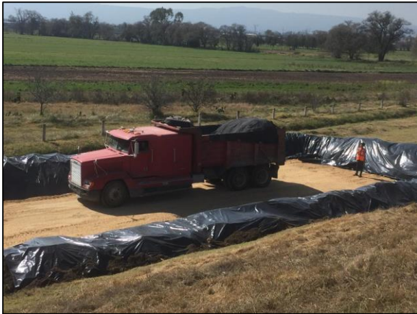
25.- El material extraído fue acarreado y colocado en la Celda Provisional.
