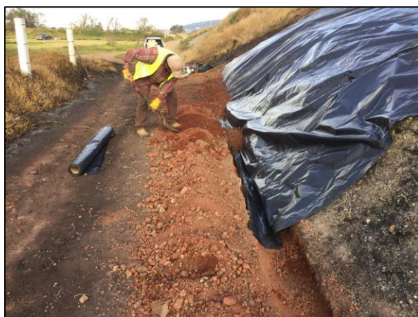
06.- Con apoyo de recurso humano se rellenó la zanja perimetral de la Zona afectada A previamente cubierta con película de polietileno de alta densidad.
