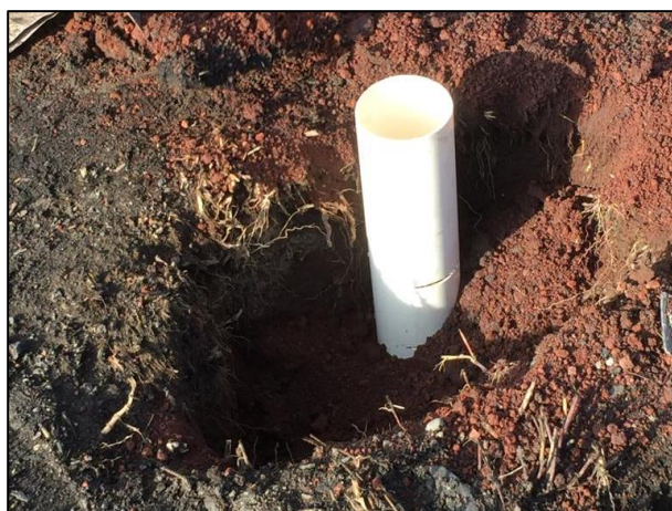
04.- se realizó la colocación de tubos PVC con filtros de carbón activado dentro de la Zona afectada A
