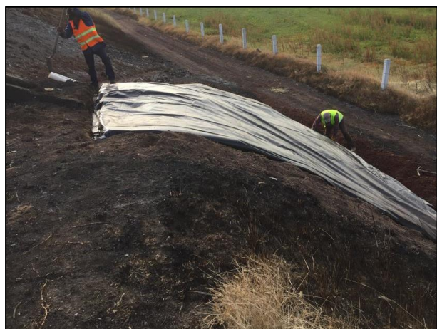
05.- Con apoyo de recurso humano se realizó la colocación de una película de polietileno de alta densidad sobre la Zona afectada A.
