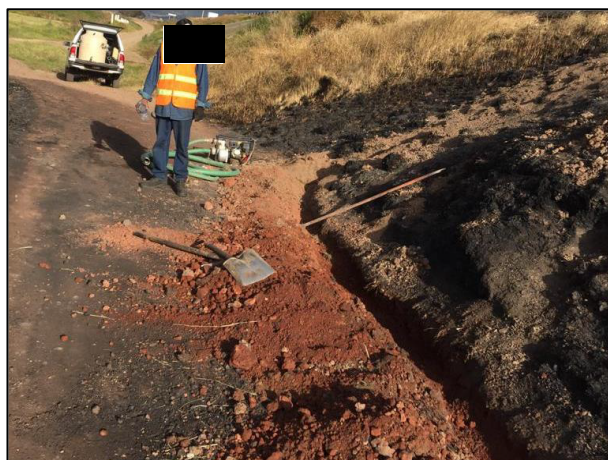
02.- Construcción de zanja perimetral alrededor de la Zona afectada A con el fin de delimitar el área de afectación de suelo natural.
