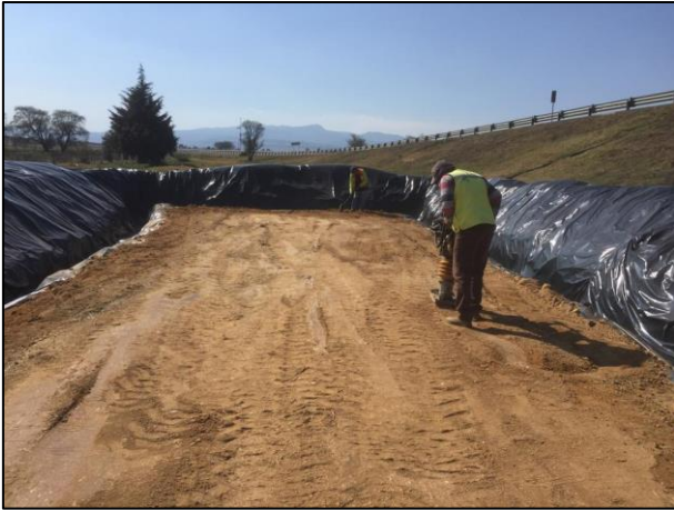
19.- Con apoyo de una compactadora manual se realizó la compactación de la segunda capa de arcilla.
