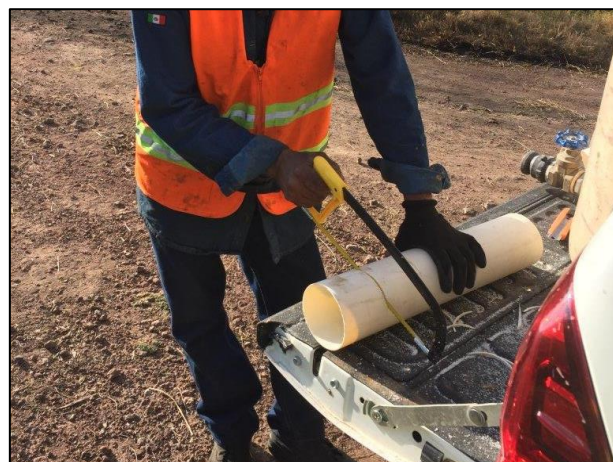
03.- Preparación de tubería PVC para la elaboración de filtros de carbón activado.
