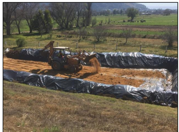
18.- Con apoyo de una retroexcavadora se colocó la segunda capa de arcilla.
