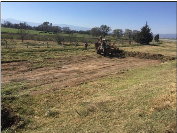
11.- Con ayuda de maquinaria pesada como lo es la retroexcavadora, se realizó el acondicionamiento y nivelación del terreno designado para la construcción de la Celda Provisional.
