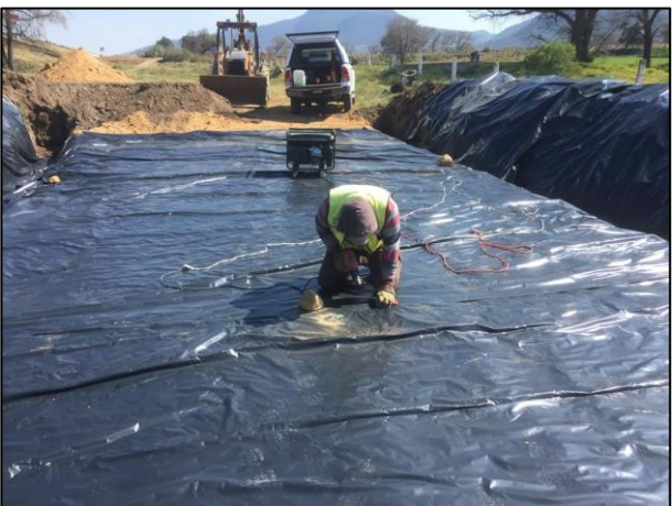
17.- Se realizó el termosellado de la película de polietileno colocada en la Celda Provisional.
