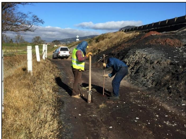
07.- Con apoyo de personal de campo, se realizaron sondeos en el camino de terracería del sitio en estudio.
