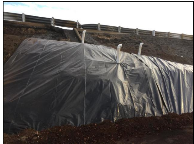
10.- Vista final de la Zona afectada A cubierta con la película de polietileno de alta densidad y los tubos PVC con filtros de carbón activado.
