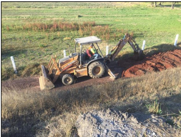
21.- Con apoyo de la retroexcavadora se realizó la extracción del material edáfico en la Zona afectada C previamente humedecido.
