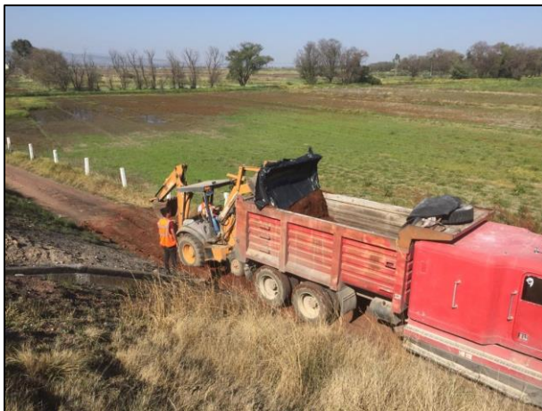
23.- El material extraído de la Zona afectada C fue colocado en camión de volteo para que este llevara a cabo el acarreo hacia la Celda Provisional.
