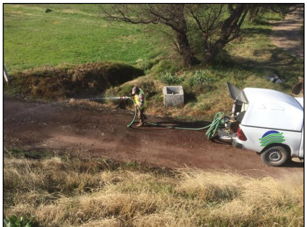
28.- Se realizó humectación en la Zona afectada B previo a la extracción del material edáfico.
