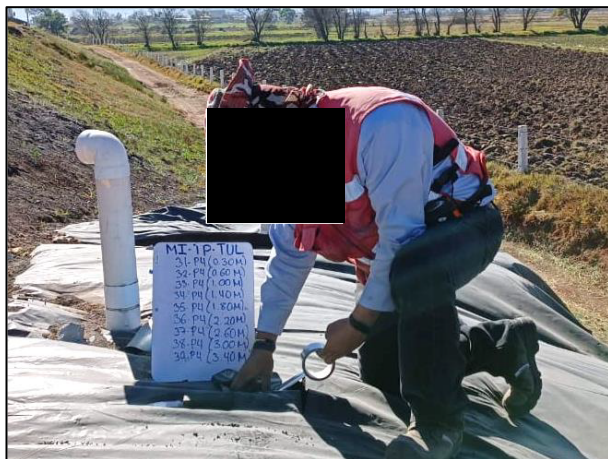
10.- Efectuadas la toma de muestras dentro de la Zona Afectada A, las incisiones realizadas fueron debidamente selladas con apoyo de cinta industrial.
