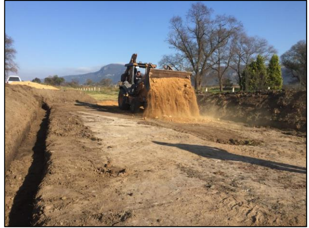
14.- Se colocó una capa de arcilla sobre la base de la Celda Provisional.
