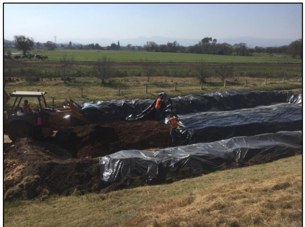
30.- Colocación de la 1er. capa de material edáfico extraído en Celda Provisional, cubriendo y destapando con película de polietileno de alta densidad la maquinaria utilizada.
