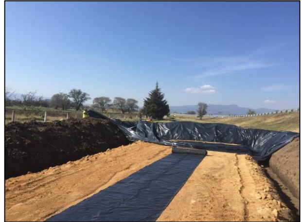
16.- Se colocó película de polietileno de alta densidad sobre la base y bordos de la Celda Provisional.
