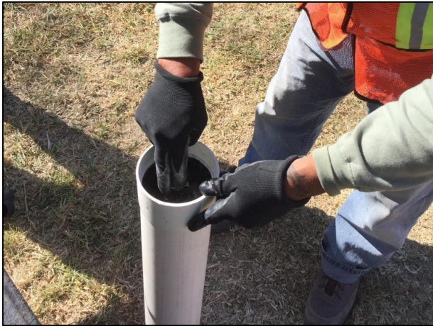
37.- Preparación y colocación de los filtros de carbón activado en la tubería PVC.
