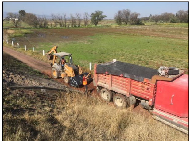
24.- Durante el acarreo del material edáfico extraído hacia la Celda, este permaneció cubierto con película de polietileno de alta densidad para así impedir la transferencia de hidrocarburos volátiles al medio ambiente
