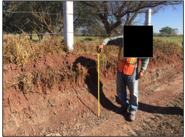
40.- Se verificó la profundidad de las Zonas de Extracción.
