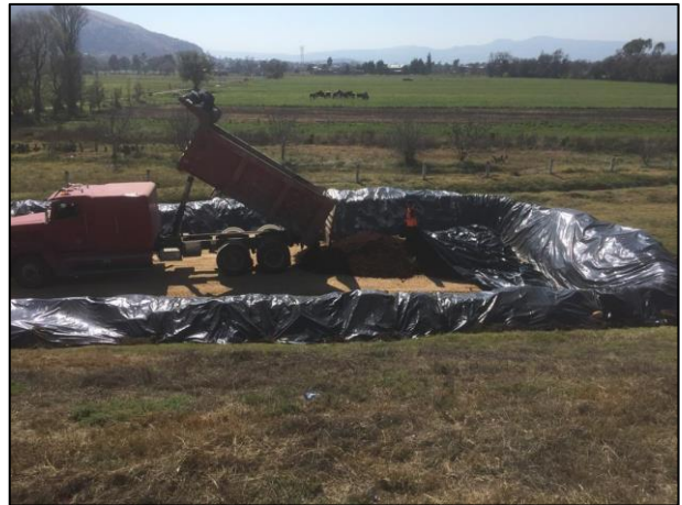
26.- La Celda Provisional estuvo cubierta con película de polietileno de alta densidad en todo momento durante la colocación del material en esta.
