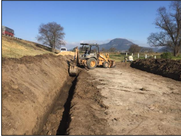
13.- Con apoyo de retroexcavadora se construyeron las canaletas perimetrales para la captación de lixiviados.
