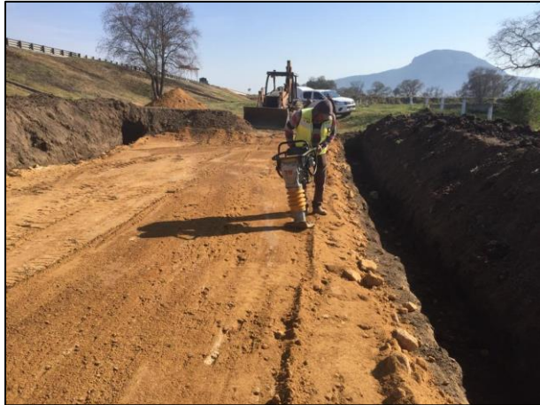
15.- Aplicación y compactación con compactadora manual de la primera capa de arcilla en Celda Provisional.
