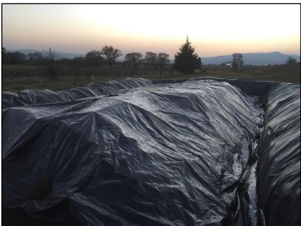
35.- El material edáfico colocado en la Celda Provisional fue cubierto en su totalidad con película de polietileno de alta densidad.
