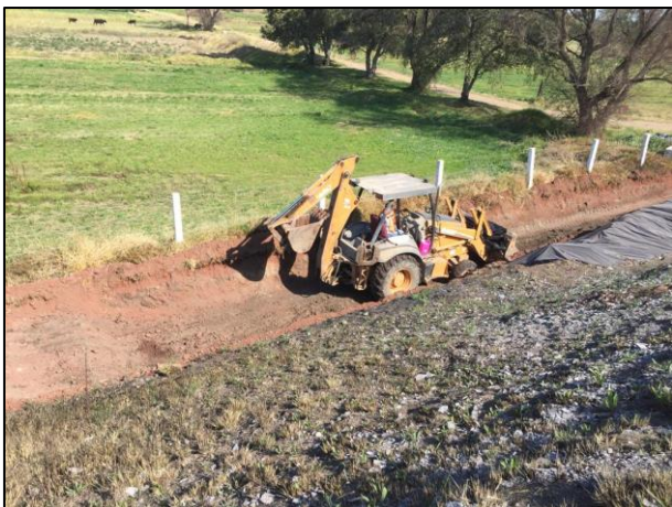
29.- Con ayuda de retroexcavadora se realizó la extracción del material edáfico afectado por el derrame de Gasolina de la Zona afectada B.
