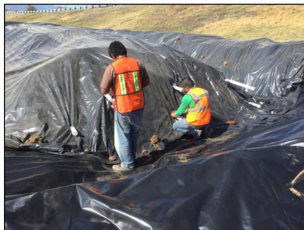
36.- Se realizó la colocación de tapón sello a los extremos de la tubería de PVC.
