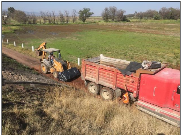
22.- El material edáfico contaminado de la Zona afectada C fue extraído por medio de retroexcavadora y permaneció cubierto con película de polietileno durante su traslado hacia la Celda Provisional.
