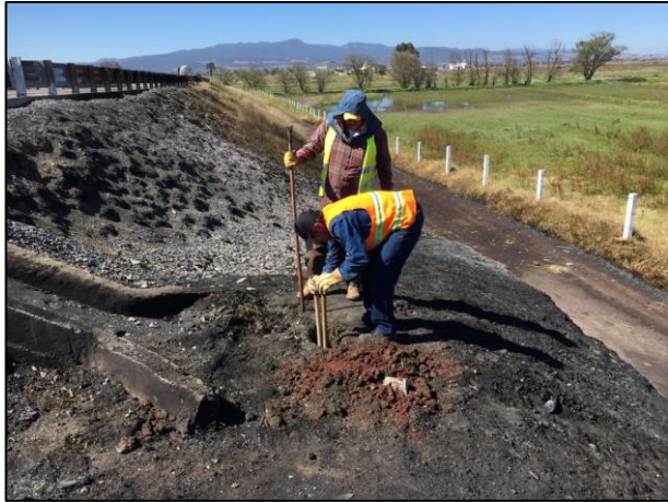
03.- Con apoyo de personal de campo, se realizaron sondeos en el talud del sitio en estudio.
