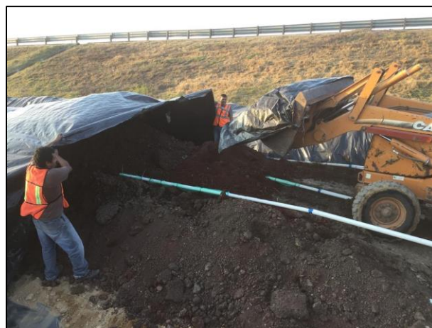
34.- Se instaló el 2do. nivel de tubería PVC en la Celda Provisional, y la colocación de material edáfico extraído de la Zona afectada B.
