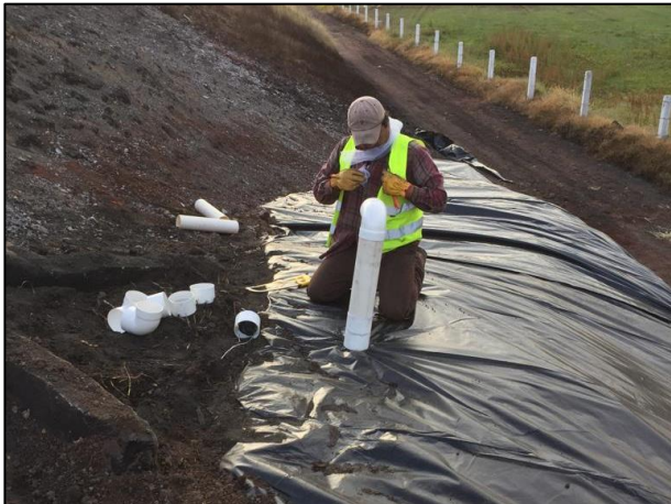
09.- Colocación de tubos PVC con filtros de carbón activado en la Zona afectada A, esto con el objetivo de impedir la transferencia de hidrocarburos volátiles al medio ambiente.
