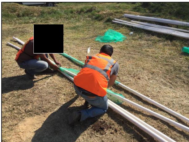
31.- Con apoyo de recurso humano se llevó a cabo la preparación de tubería ranurada de PVC, la cual conformará el sistema de aireación.
