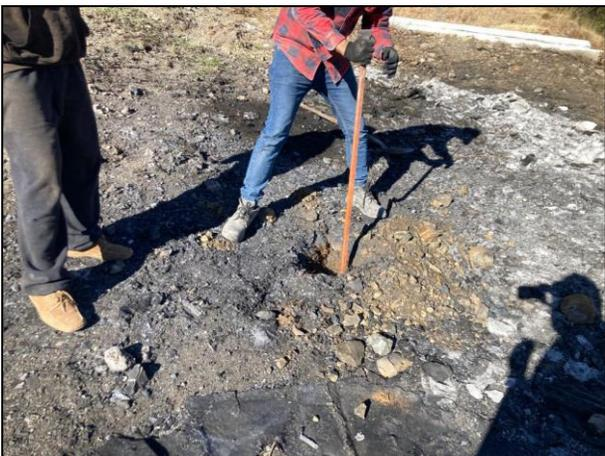
4. Debido a la presencia de rocas en el sitio, se utilizó una barra metálica para la realización de los sondeos.
