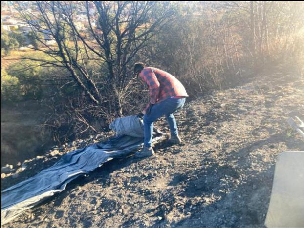
1. Con apoyo de recurso humano, se procedió a extender una membrana de polietileno de alta densidad sobre el Área Afectada.
