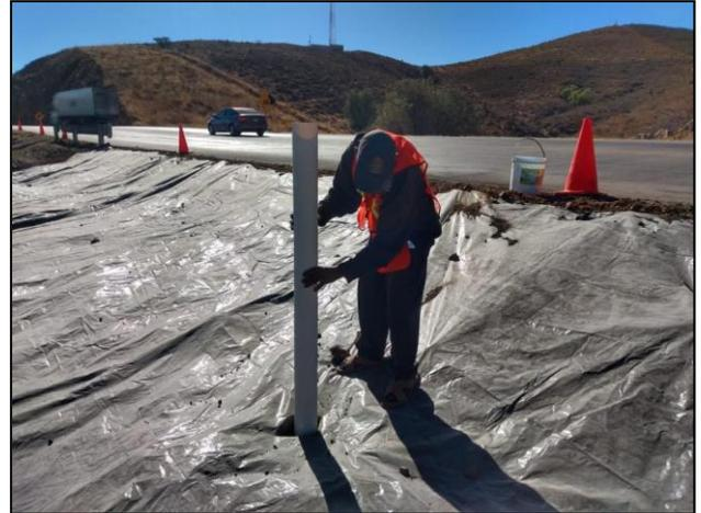
7. Colocación de filtros de carbón activado, en el Área Afectada por la Gasolina derramada.
