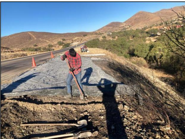
3. Toda el Área Afectada fue sometida a labores de contención, realizando una zanja perimetral con apoyo de herramienta manual.
