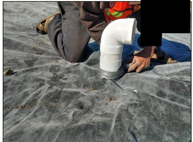
9. Sellado del liner donde se colocaron los filtros de carbón activado.
