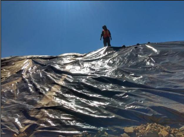
6. La membrana de polietileno de alta densidad fue colocada en toda el Área Afectada.
