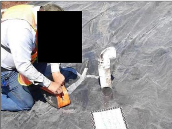
9. Las incisiones realizadas en la membrana de polietileno de alta densidad para la toma de muestras dentro del Área Afectada, fueron selladas.
