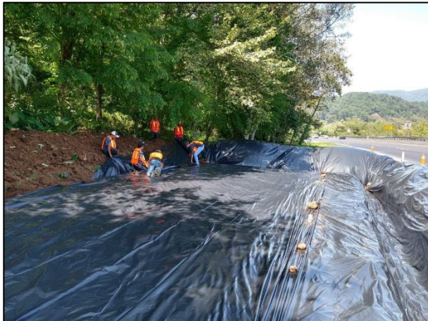
09. Con apoyo de recurso humano la celda provisional se cubrió con una película de polietileno de alta densidad.
