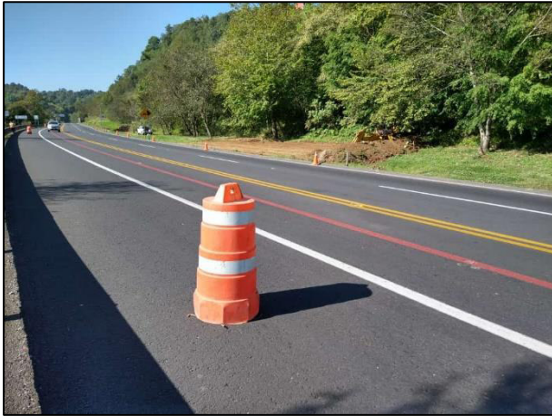
01. Se realizó la colocación de señalización preventiva en el sitio de trabajo.
