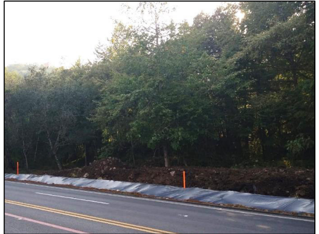
22. Vista general de la celda provisional.
