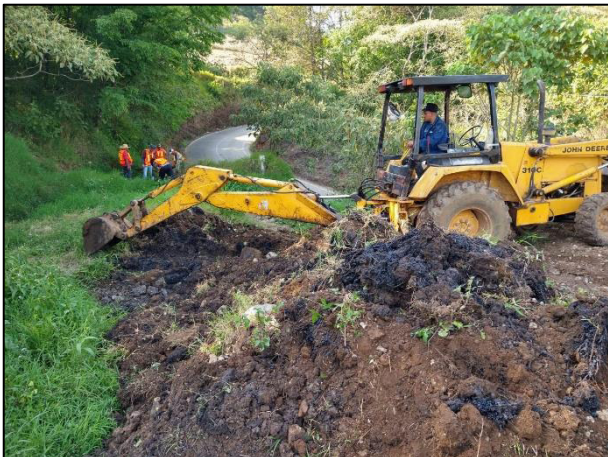
15. Con apoyo de retroexcavadora se realizó la extracción del suelo afectado por el derrame de Combustóleo Pesado.
