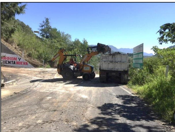
17. Actividades de depósito y acarreo del material afectado en camión de volteo.
