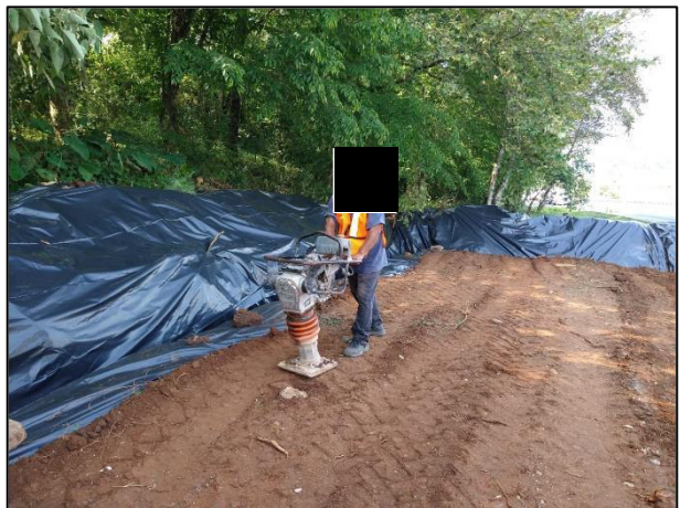
12. Con apoyo de vibro compactador manual se compactó la capa de arcilla.
