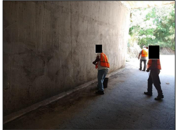
20. El material edáfico azolvado presente en la canaleta de concreto del paso subterráneo fue depositado en cubetas plásticas y depositado en celda provisional.
