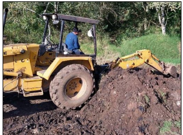
14. Actividades de extracción del material afectado en la Fosa de Excavación "B".
