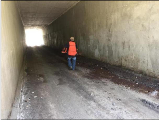
19. Con apoyo de recurso humano se realizó la limpieza de la canaleta perteneciente al paso subterráneo (vialidad de carpeta asfáltica).
