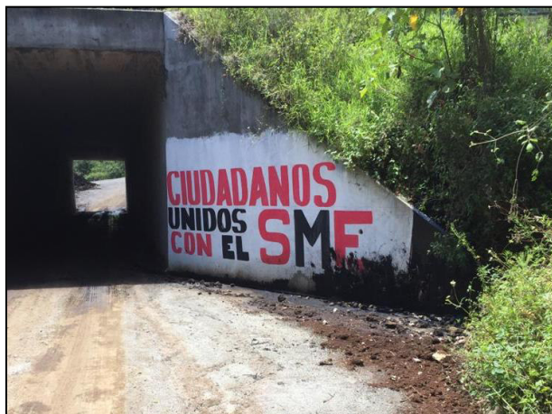
05. Posterior al desplazamiento del hidrocarburo sobre suelo natural, el Combustóleo Pesado llegó hasta un paso subterráneo (vialidad de concreto).
