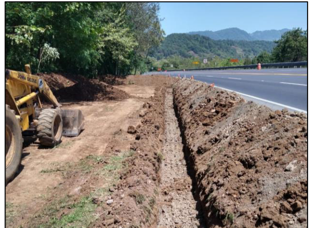
04. Construcción de canaletas de captación de lixiviados.
