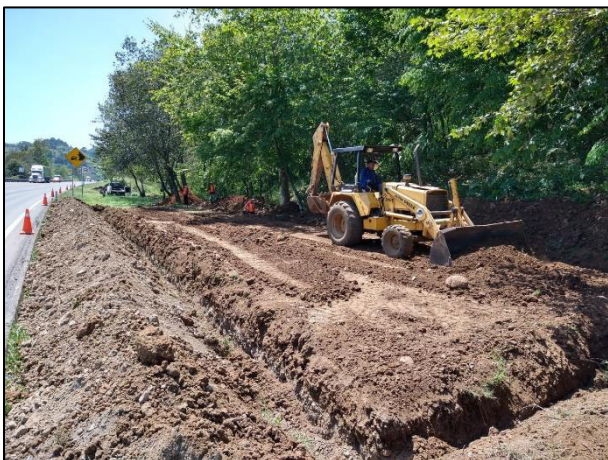
05. Con apoyo de retroexcavadora se colocó una capa de arcilla sobre la base de la celda provisional.
