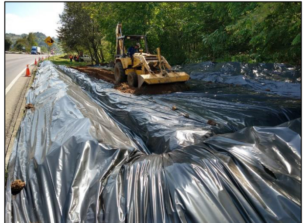
10. Se colocó una segunda capa de arcilla por encima de la película de polietileno de alta densidad.
