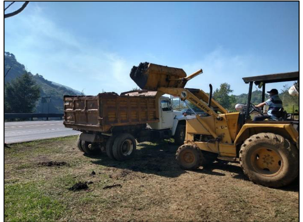
16. Depósito del material afectado en camión de volteo para su posterior acarreo,
