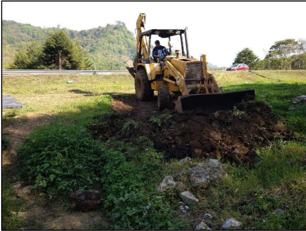
13. Se realizó la extracción del material afectado en la Fosa de Excavación "A".
