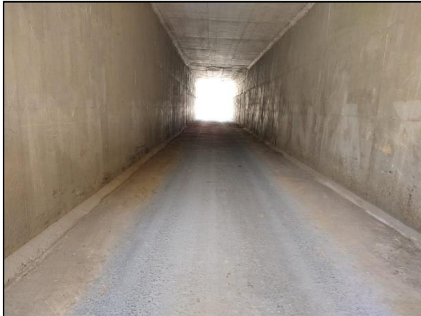
21. Vista del paso subterráneo una vez terminadas las actividades de limpieza.
