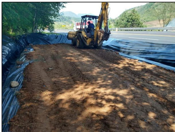
11. Con apoyo de retroexcavadora se distribuyó la capa de arcilla.
