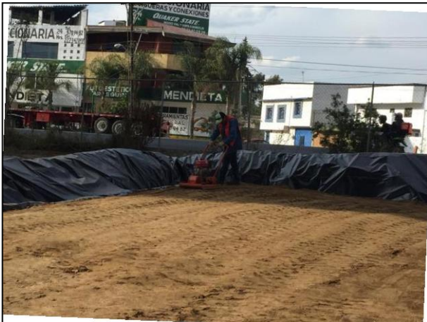
9. Con apoyo de recurso humano y de un vibro compactador manual, se realizó la compactación de la arcilla.
