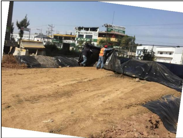
19. El material edáfico afectado colocado en la Celda Provisional, estuvo cubierto con una membrana de polietileno de alta densidad.
