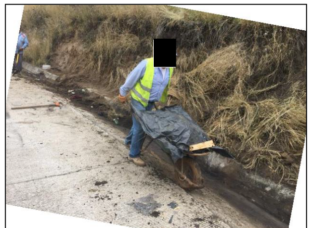
12. Acarreo del material edáfico afectado, cubriéndolo con una membrana de polietileno de alta densidad.
