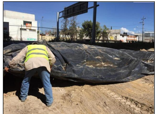
22. El material edáfico colocado en la Celda Provisional, estuvo cubierto durante su depósito.
