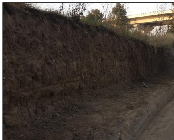
29. Área sometida a excavación, debido a la afectación causada por el derrame de Gasolina.
