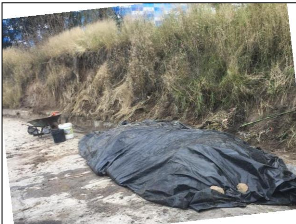
15. El material extraído de la canaleta de concreto, estuvo contenido temporalmente con apoyo de membrana de polietileno de alta densidad.
