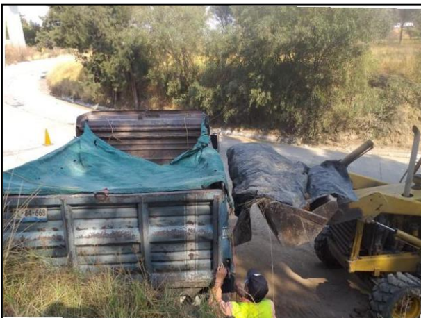
17. Embarque del material edáfico afectado en el camión volteo (material edáfico azolvado extraído de la canaleta de concreto), cuidando la transferencia suelo – atmósfera.
