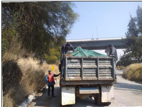
21. Acarreo del material edáfico afectado a la Celda Provisional, todo esto, evitando lo mayor posible la transferencia de COV's a la atmósfera.
