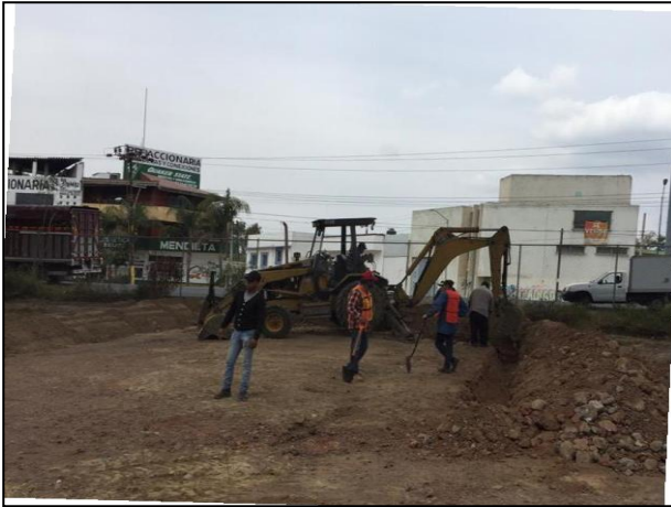
1. Acondicionamiento del terreno para la construcción de la Celda Provisional.
