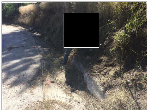
5. Realización de pozos de sondeo para conocer la infiltración de la Gasolina derramada.
