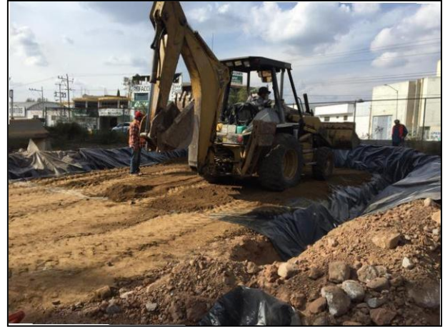
8. Para reforzar la impermeabilidad de la base de la Celda, se colocó una segunda capa de arcilla sobre la membrana de polietileno.
