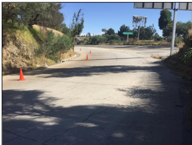
1. El sitio de derrame se encuentra ubicado en la Carretera Federal No. 150 Puebla – Tehuacán, municipio de Puebla, estado de Puebla.
