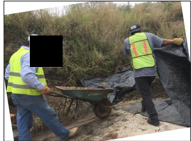
14. Temporalmente, el material edáfico azolvado extraído de la canaleta de concreto fue colocado sobre una membrana de polietileno de alta densidad.
