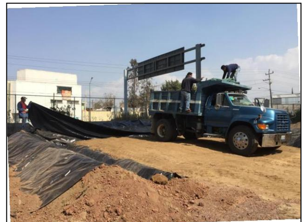
18. Depósito del material edáfico afectado en la Celda Provisional, con apoyo de camión volteo.
