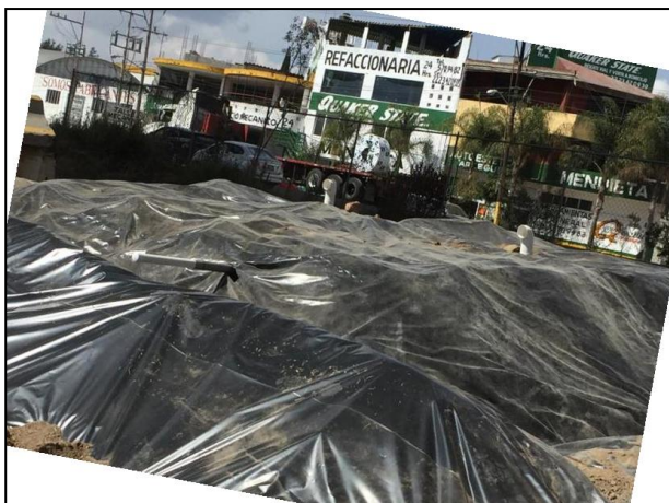
27. Colocación de filtros de carbón activado en la Celda Provisional.
