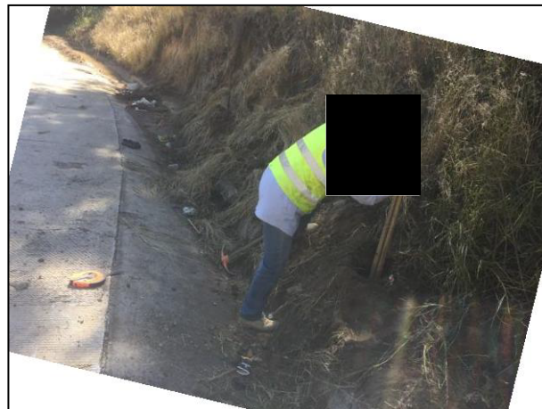
4. El derrame de Gasolina afectó suelo natural perteneciente al talud de la carretera, por lo que se procedió a la realización de pozos de sondeo.
