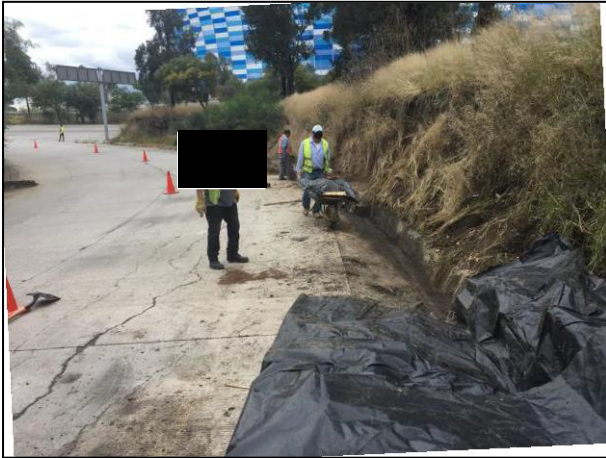
13. Acarreo del material edáfico afectado hacia la membrana de polietileno de alta densidad.
