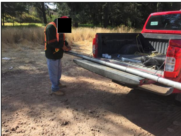
23. Se realizó el corte transversal de la tubería a utilizar.
