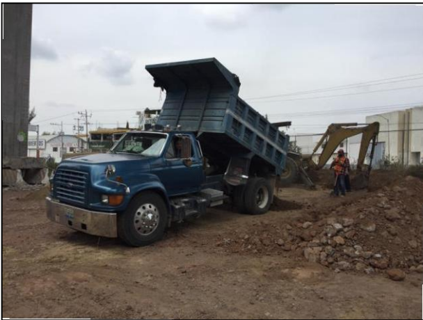
3. Sobre la base de la Celda, se depositó material de arcilla con apoyo de camión volteo.
