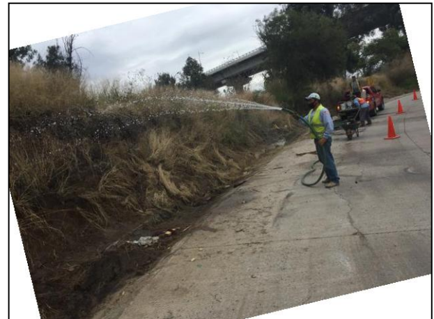
10. Se procedió a la humectación del suelo a extraer, con la finalidad de evitar la volatilización del contaminante.
