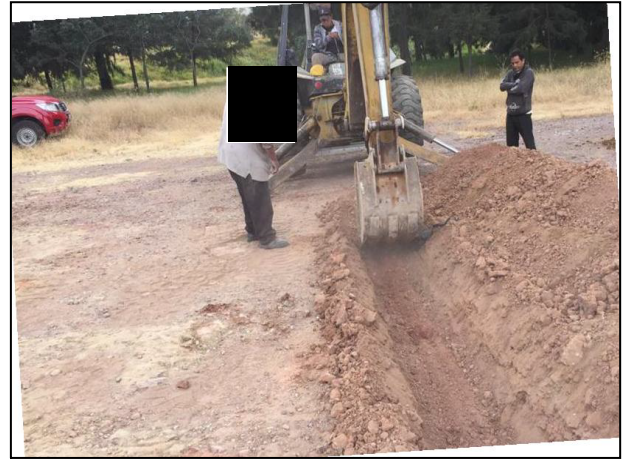
2. Se construyeron los bordos y canaletas de la Celda Provisional con material libre de contaminantes.
