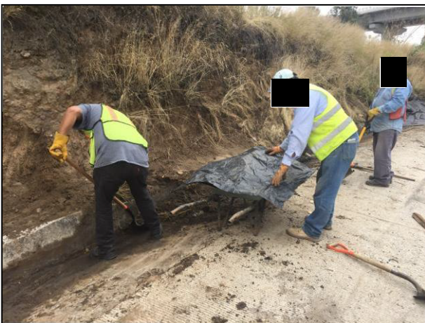
11. Con apoyo de recurso humano, equipado con palas, picos y carretillas, se procedió a extraer el material edáfico azolvado encontrado en la canaleta de concreto.
