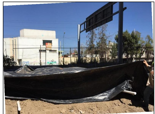
24. Se instaló la tubería entre cada capa de material edáfico colocado en la Celda.
