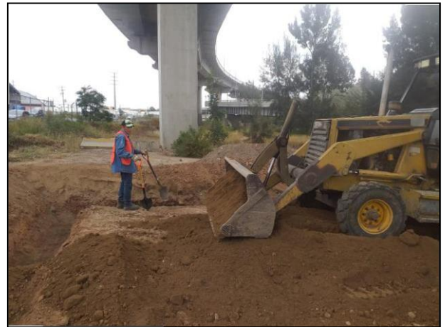
4. Utilizando una retroexcavadora, la arcilla fue distribuida en la base de la Celda Provisional.
