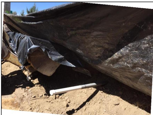
25. Depósito del material edáfico en la Celda Provisional.
