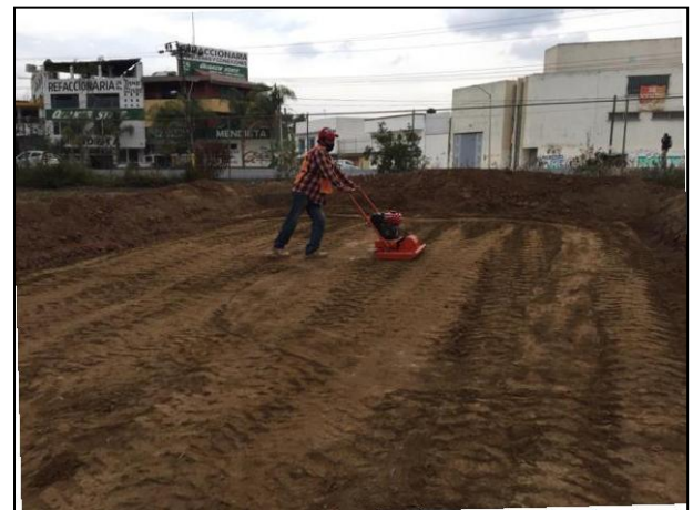
6. Compactación de capa de arcilla.
