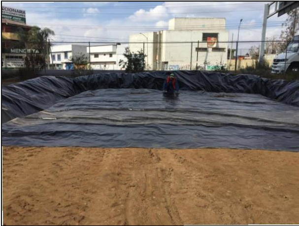
7. La Celda Provisional se cubrió con una membrana de polietileno de alta densidad.
