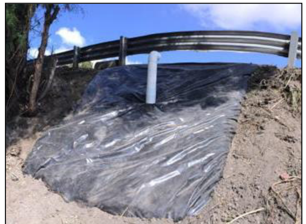
10. Área Afectada con filtros de carbón activado para la captación de gases.
