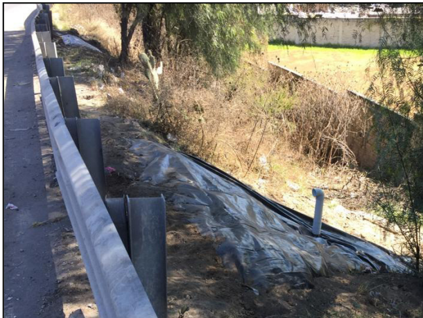
09. Las Áreas Afectadas fueron cubiertas con película de polietileno de alta densidad y se les colocaron filtros de carbón activado.
