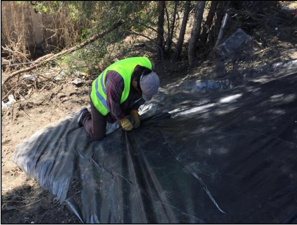
07. Con apoyo de una navaja se realizó un corte en la película de polietileno de alta densidad a fin continuar con la instalación superior de los filtros de carbón activado.
