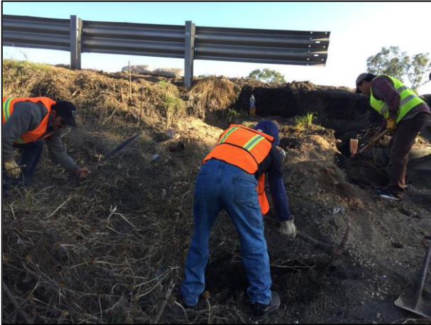
01. En el sitio se realizó el acondicionamiento, así como la construcción de una barrera de contención (zanja) alrededor de cada Área Afectada a fin de mitigar el desplazamiento del hidrocarburo.
