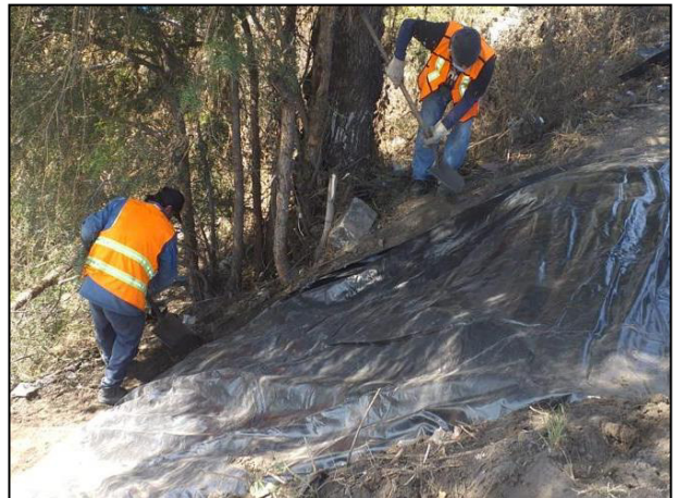
06. Las Áreas Afectadas fueron cubiertas con película de polietileno de alta densidad. Dichas películas fueron enterradas en las barreras de contención (zanjas) alrededor de cada Área Afectada.
