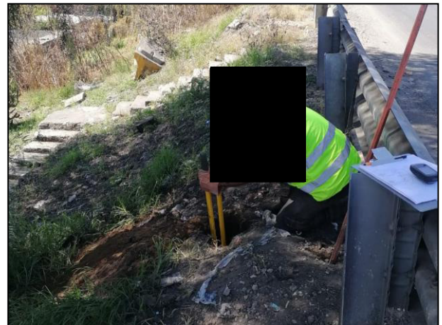
04. Se realizaron sondeos dentro de las Áreas Afectadas con el apoyo de pocera.
