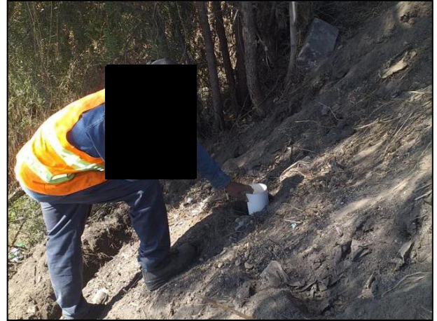
02. De manera manual se instalaron filtros de carbón activado en las Áreas Afectadas.
