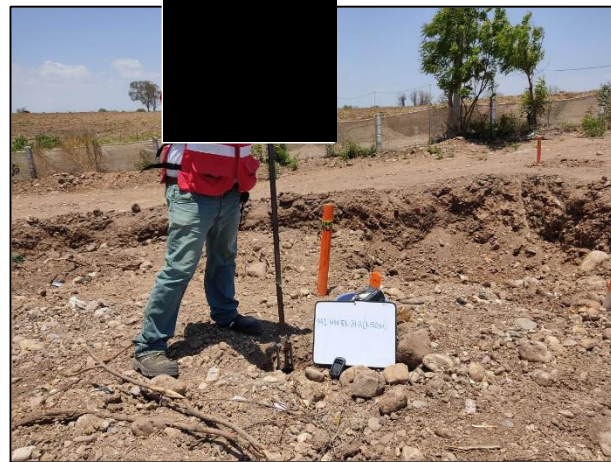
12. Se realizó la toma de muestra en el material usado para relleno de la Zona de Excavación (Zona A).
