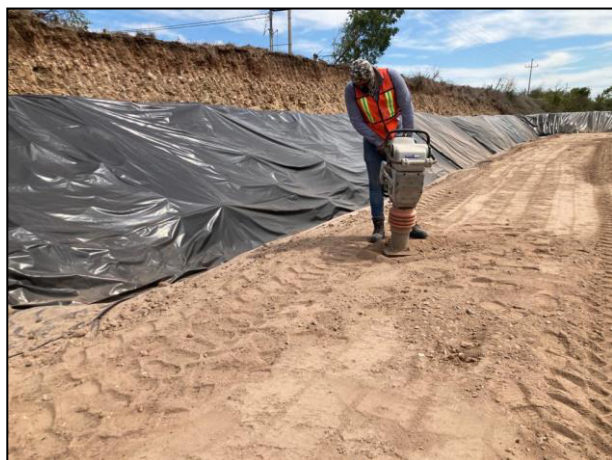
9. Se realizó la compactación de la segunda capa de arcilla.
