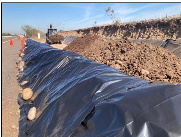
11. Depósito del material edáfico extraído en la Celda Provisional.
