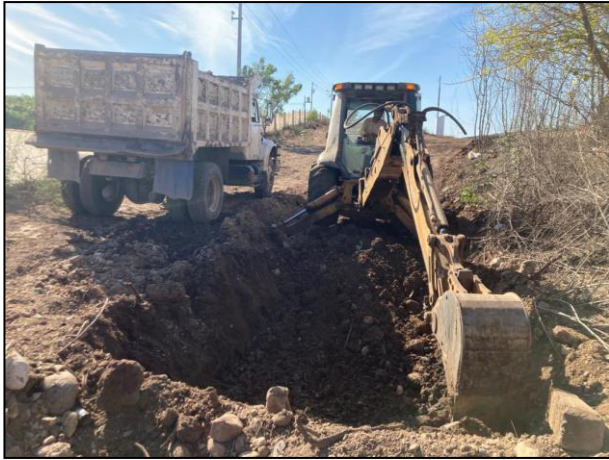
13. Extracción del material edáfico afectado.
