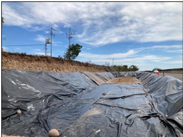
7. Celda Provisional cubierta con película de polietileno de alta densidad.
