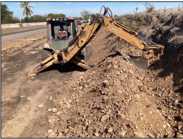
3. Construcción y compactación de los bordos de la Celda Provisional, con ayuda de retroexcavadora.
