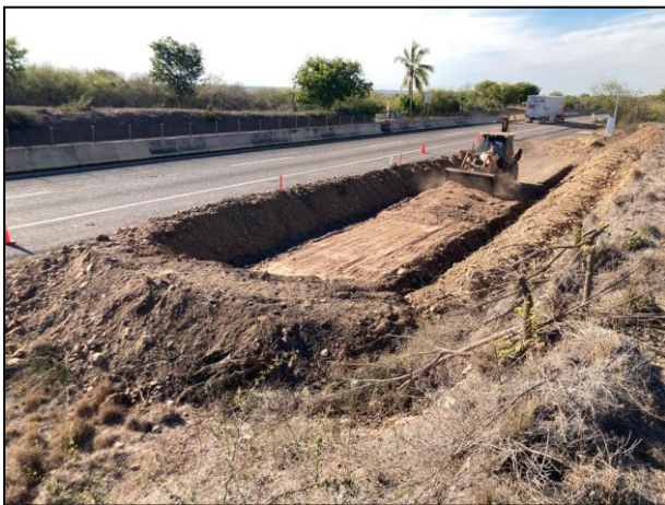
5. Se colocó una capa de arcilla en la base de la Celda Provisional.
