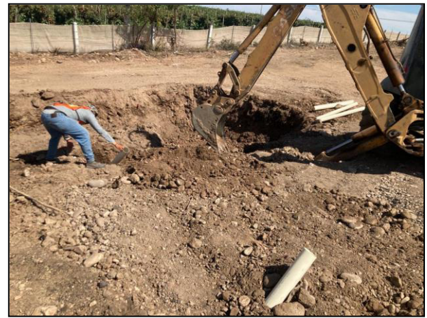
16. Colocación de los tubos de monitoreo en la Zona de Excavación (Zona A), ubicada a un lado de la carretera.
