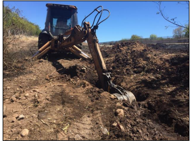
8. Se realizaron los sondeos en el sitio, utilizando retroexcavadora.
