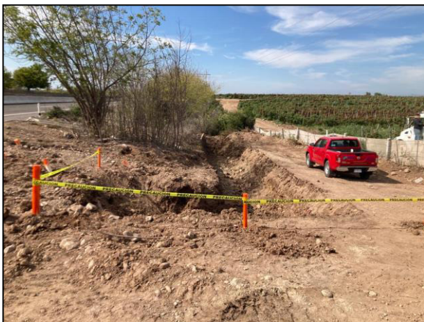
17. Zona de Excavación sometida a labores.
