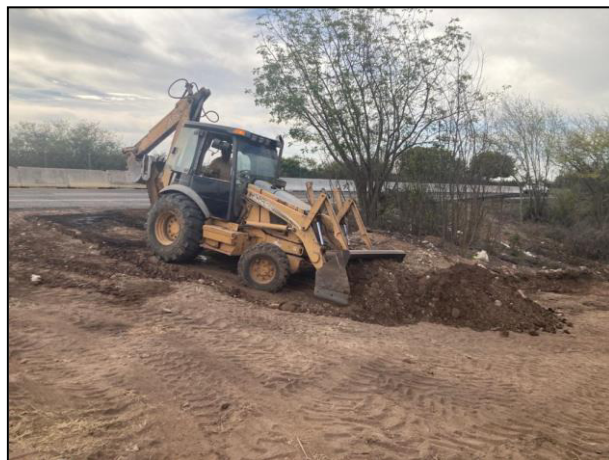
10. Con apoyo de retroexcavadora se procedió a extraer el material edáfico afectado con el Diésel derramado.
