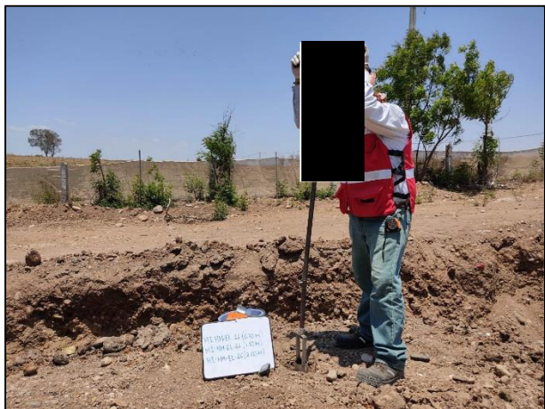
7. Se realizó la toma de muestra en la periferia de la Zona de Excavación.
