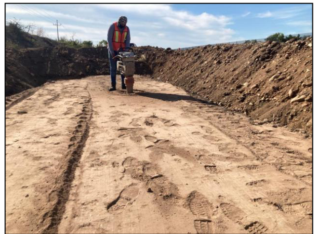
6. Compactación de la capa de arcilla, utilizando un vibro compactador manual.
