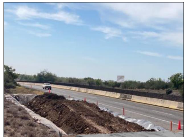
18. Material edáfico extraído, colocado en la Celda Provisional construida.
