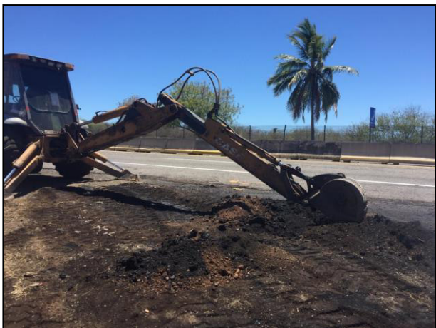
3. Con apoyo de maquinaria pesada se procedió a realizar los sondeos en el sitio afectado.
