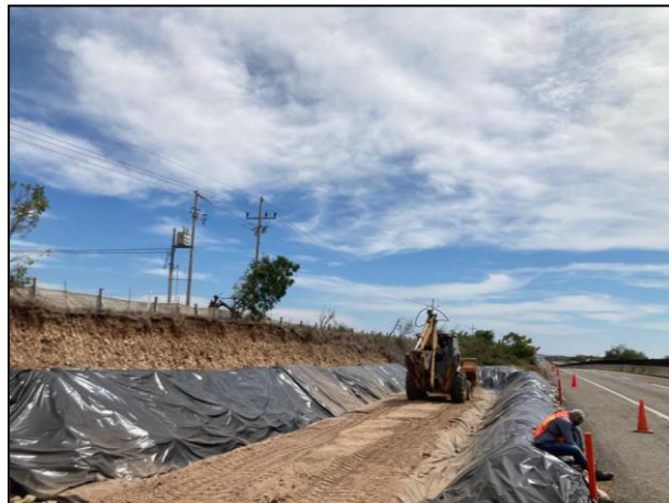
8. Colocación de segunda capa de arcilla con apoyo de retroexcavadora.
