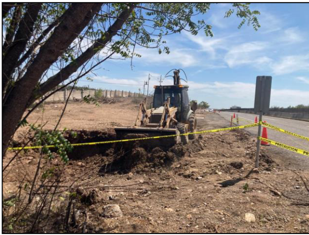
15. Relleno de la Zona de Excavación (Zona A).
