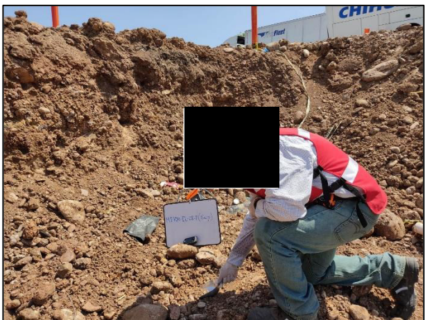
9. Con apoyo del cucharón de acero inoxidable se realizó la toma de muestra en fondo, en la Zona de Excavación (Zona B).
