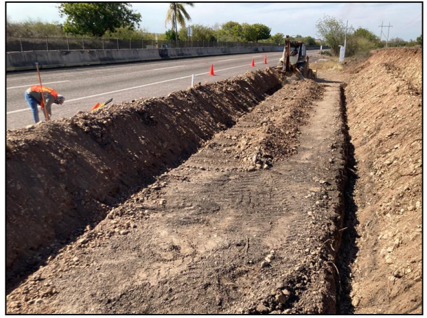
4. Construcción de las canaletas para la captación de lixiviados.
