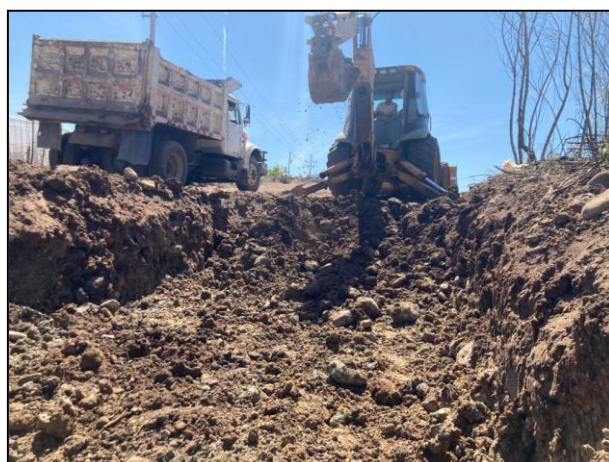
12. Con apoyo de retroexcavadora, se extrajo el material edáfico afectado depositándolo en camión volteo.
