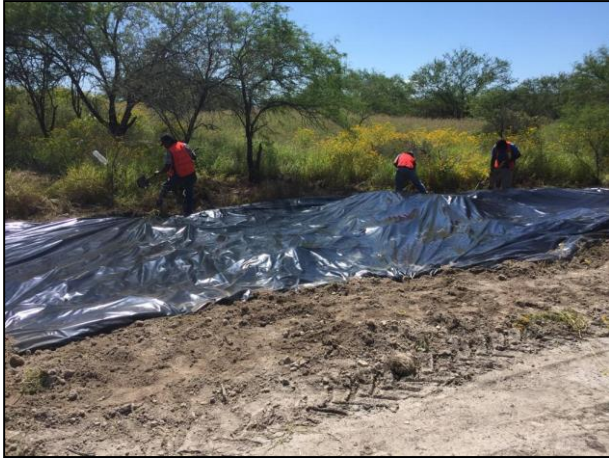
07. Con apoyo de recurso humano se tendió una película de polietileno de alta densidad sobre las Zonas Afectadas.
