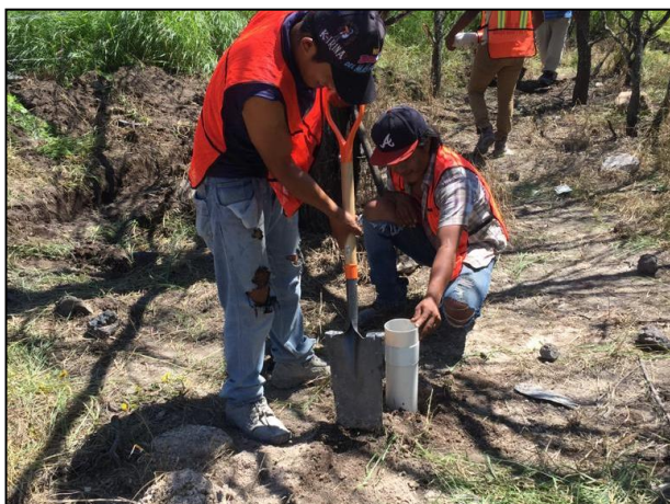
05. Seguidamente se procedió a ubicar la colocación de los filtros de carbón activado.
