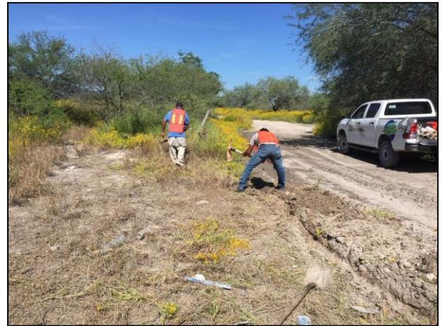
02. Utilizando herramientas manuales como palas, se procedió a la construcción de una zanja.
