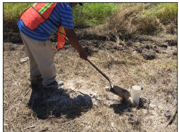
06. Colocación de los filtros de carbón activado en las Zonas Afectadas, para captación de vapores.
