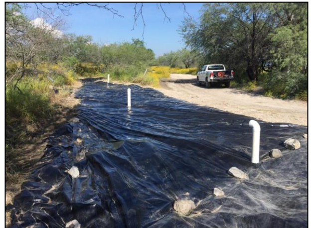
10. Zonas Afectadas cubiertas con película de polietileno de alta densidad y filtros de carbón activado.
