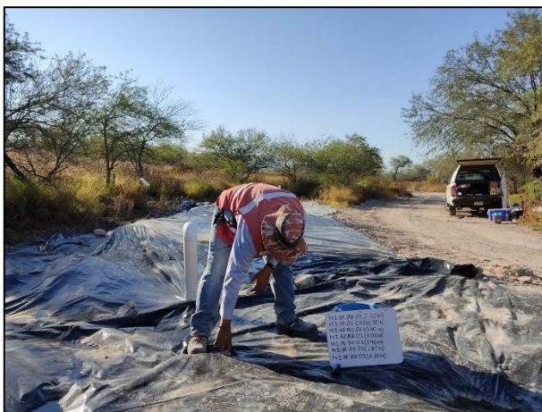
04. Se realizaron cortes en la película de polietileno de alta densidad para la toma de muestras dentro de las Zonas Afectadas.
