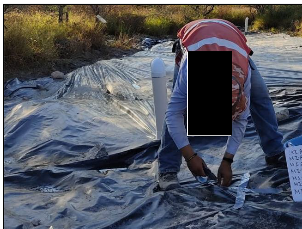
08. Efectuadas la toma de muestras dentro de las Zonas Afectadas, las incisiones realizadas fueron debidamente selladas con apoyo de cinta.
