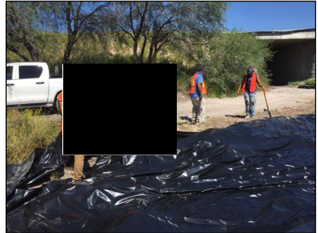
08. Colocación de la película de polietileno de alta densidad sobre las Zonas Afectadas.
