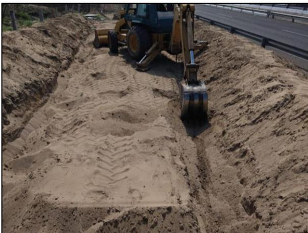
5. Se construyeron las canaletas y bordos de la celda provisional.
