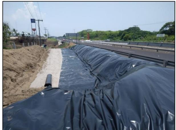
10. La celda provisional se cubrió con una membrana de polietileno de alta densidad.
