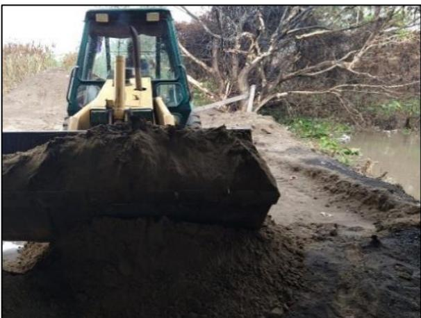
15. Con apoyo de la retroexcavadora se realizó la extracción del material edáfico afectado con Gasolina.
