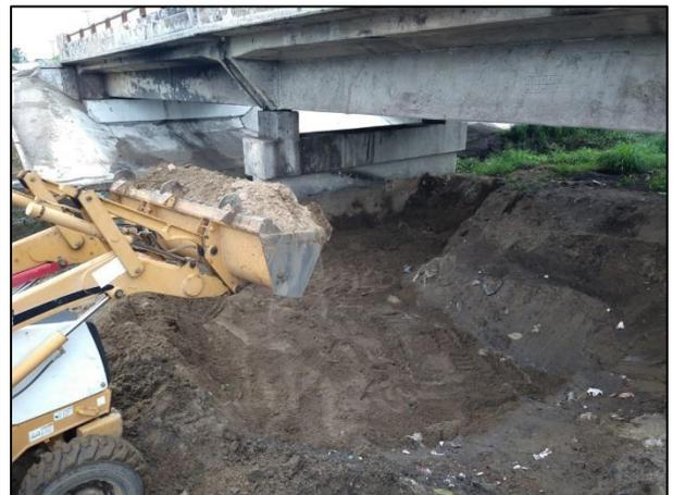
41. Se procedió al relleno de la Fosa de Excavación con material edáfico libre de contaminantes.
