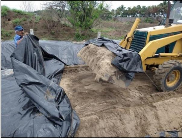
19. El material edáfico colocado en la celda provisional, estuvo cubierto durante su depósito.
