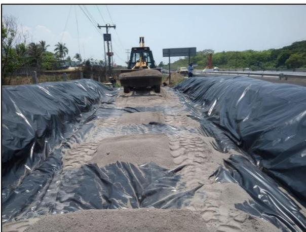
11. Para reforzar la impermeabilidad de la base de la celda provisional, se colocó una segunda capa de arcilla sobre la membrana de polietileno.
