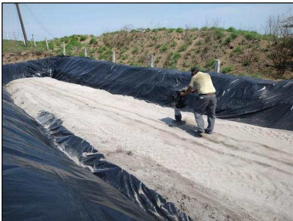
13. Con apoyo de recurso humano y de un vibro compactador manual, se realizó la compactación de la capa de arcilla.
