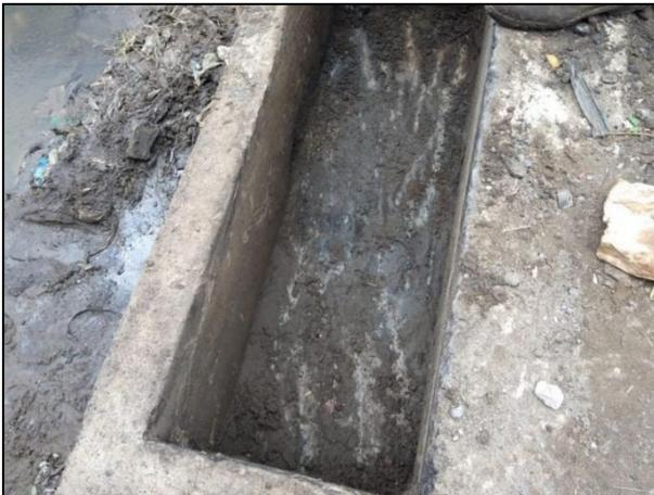
38. El receptor de concreto donde se encontraba el material azolvado, tiene base de concreto.
