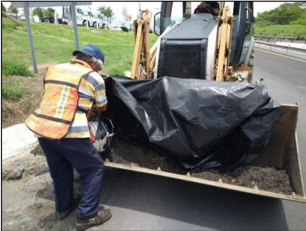
27. El material edáfico azolvado, extraído de manera manual, fue colocado en la retroexcavadora para posteriormente acarrearlo y depositarlo en la celda provisional.
