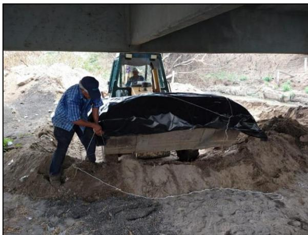
16. Se cubrió con la membrana de polietileno el material extraído para evitar la emisión de gases volátiles.
