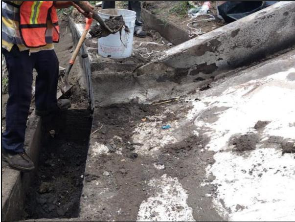
25. Con apoyo de recurso humano se realizó la extracción manual del material edáfico azolvado encontrado en el receptor de concreto.
