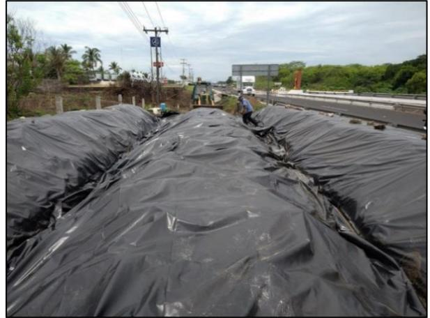
20. La celda provisional fue cubierta con una membrana de polietileno de alta densidad.
