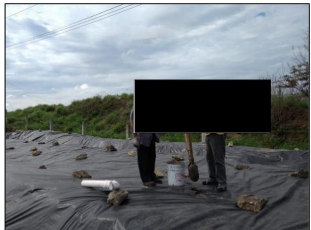
35. Con apoyo de personal de campo, se colocaron los filtros de carbón activado en la celda provisional.
