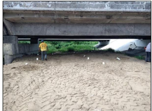
45. Tubos de monitoreo colocados en la Fosa de Excavación para la posterior toma de muestras.
