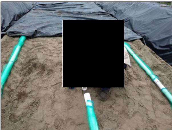
23. Se instaló la tubería entre cada capa de material edáfico colocado en la celda.
