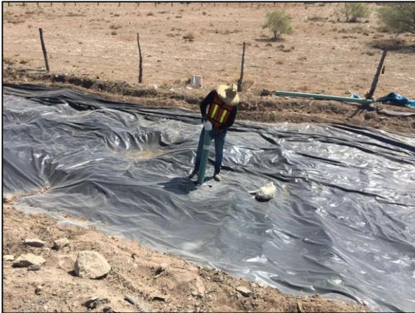
07- Se realizó la colocación de tubos PVC con filtros de carbón activado dentro de dicha Zona, esto con el objetivo de impedir la transferencia de hidrocarburos volátiles al medio ambiente.
