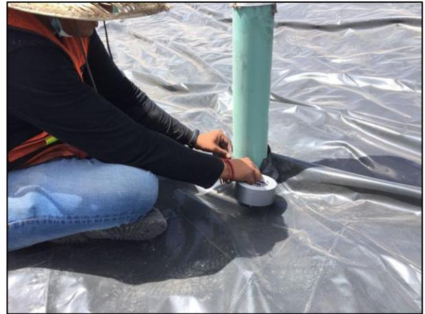
10 - Sellado de la película de polietileno de alta densidad y del tubo PVC con el uso de cinta industrial – metálica.
