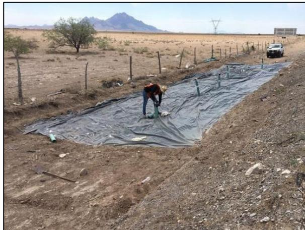
09 - Con el objetivo de impedir la transferencia de hidrocarburos volátiles al medio ambiente, se realizó la colocación de tubos PVC con filtros de carbón activado dentro de la Zona afectada.
