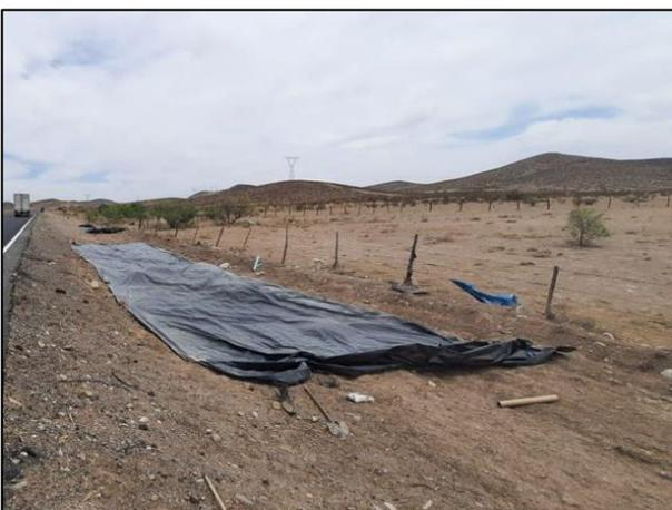
05 - Colocación de película de polietileno de alta densidad sobre la Zona afectada por el derrame de Gasolina.
