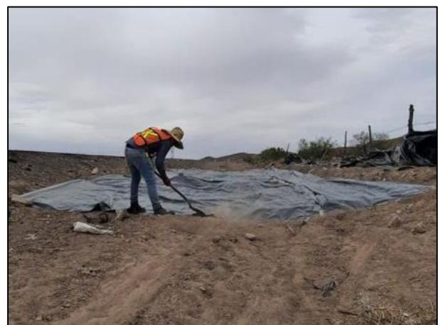
06 - Con el fin de delimitar el área de afectación de suelo natural causado por el derrame de Gasolina, se colocó una película de polietileno de alta densidad sobre la Zona afectada en estudio.
