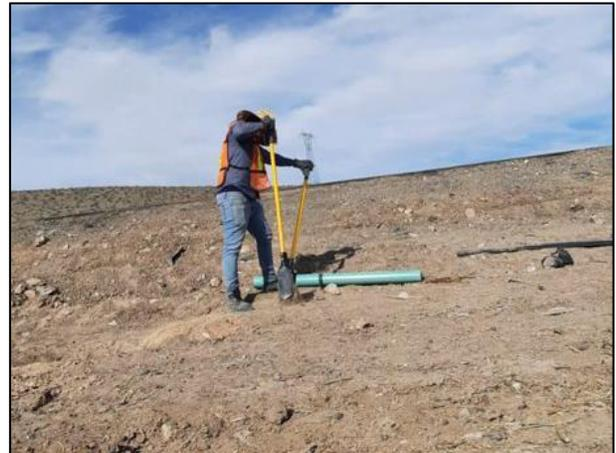
02 - Con ayuda de recurso humano se llevó a cabo la elaboración de pozos en la Zona afectada para posterior colocación de tubos PVC con filtros de carbón activado.
