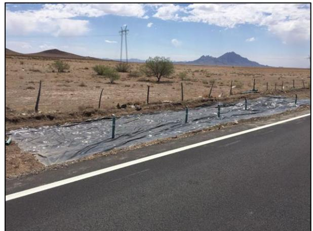
12 - Zona afectada en estudio cubierta con película de polietileno de alta densidad y la colocación de los tubos PVC con filtros de carbón activado.
