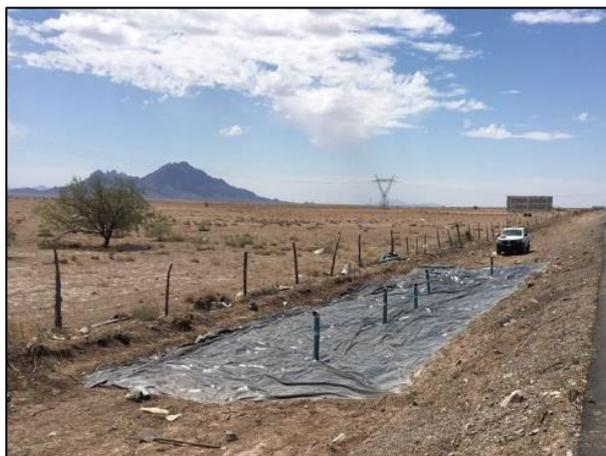
11 - Vista final de la Zona afectada cubierta con la película de polietileno de alta densidad y la colocación de los tubos PVC con filtros de carbón activado.
