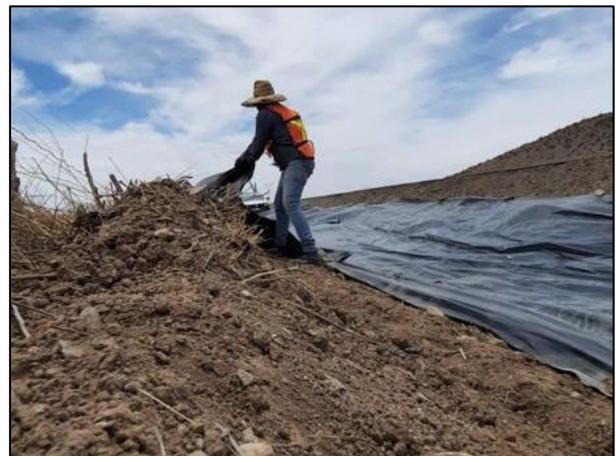
04 - Con apoyo de recurso humano se realizó la colocación de una película de polietileno de alta densidad sobre la Zona afectada.
