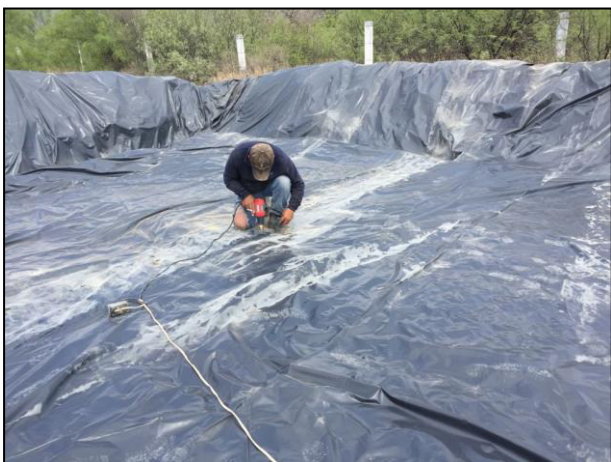
06. Se cubrió la Celda Provisional con película de polietileno de alta densidad.
