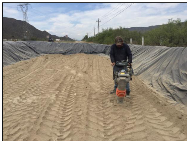
08. Compactación de la segunda capa de arcilla.
