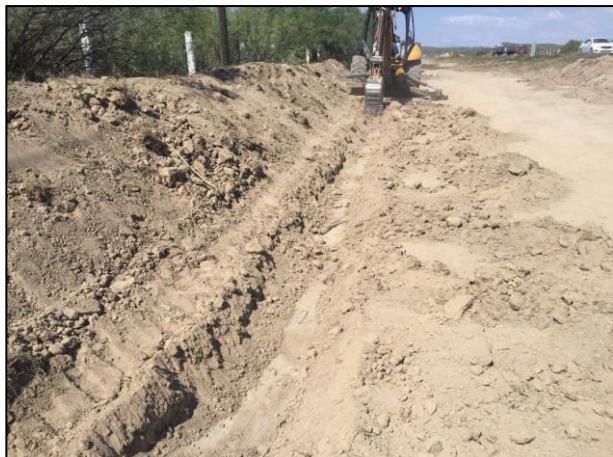
03. Construcción de canaleta para Celda Provisional.
