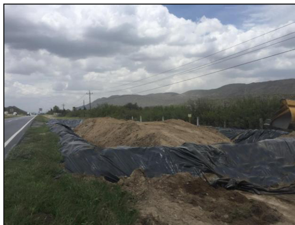
16. Vista de la Celda Provisional una vez concluidas las Labores de Extracción.
