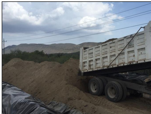
14. Depósito de material edáfico afectado en Celda Provisional.
