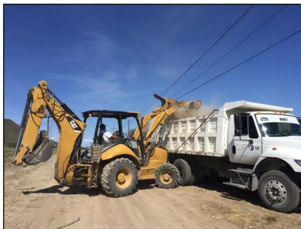
12. El material edáfico afectado fue colocado en un camión de volteo para ser acarreado a la Celda Provisional.
