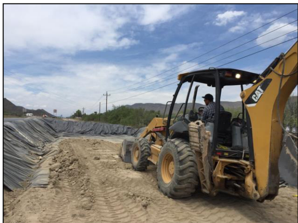
07. Depósito y esparcimiento de segunda capa de arcilla sobre película de polietileno de alta densidad
