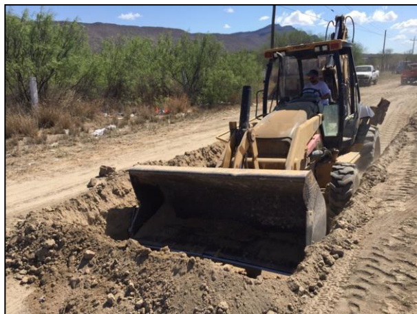
10. Con apoyo de la retroexcavadora se realizaron las actividades de extracción del material edáfico afectado.
