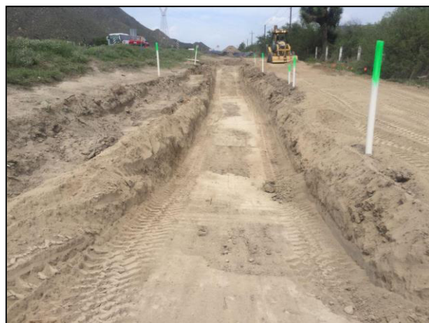
15. Vista final de las áreas sometidas a extracción, dando como resultado la Fosa de Excavación.
