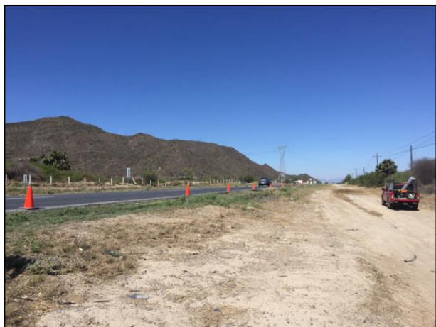
01. Se instaló la correcta señalización preventiva del área afectada y del área de trabajo.
