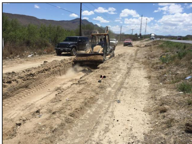
09. Extracción del material edáfico afectado con Diésel para su posterior acarreo y deposito en Celda Provisional.
