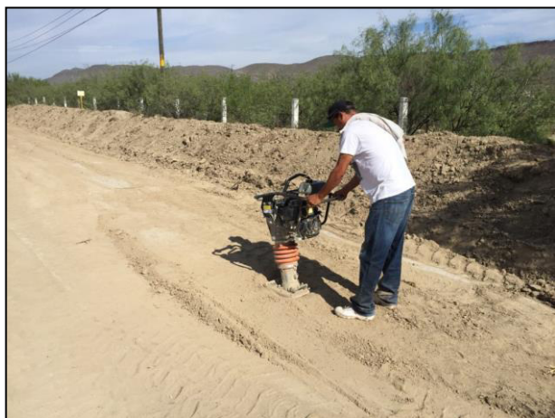
05. Compactación de la capa de arcilla.
