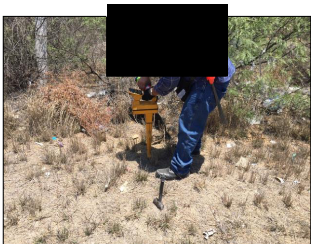
09. Antes de la extracción, personal de Telmex estuvo presente para localizar la Fibra Óptica.
