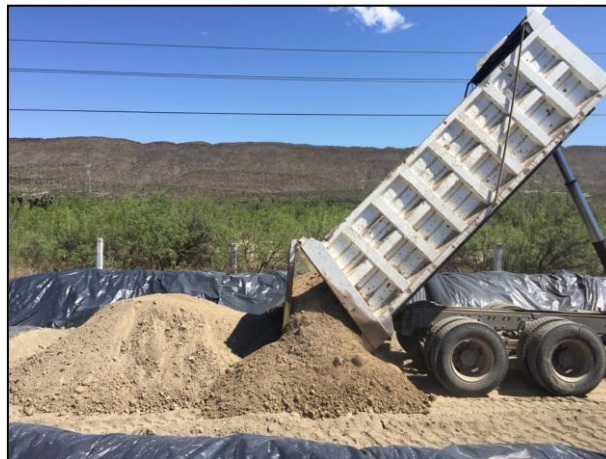
13. El material edáfico afectado se depositó en la Celda Provisional.
