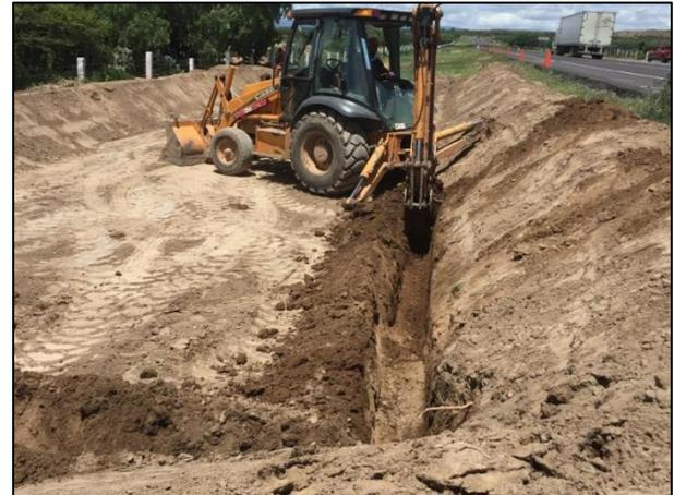
4. Construcción de canaletas perimetrales para captación de lixiviados.
