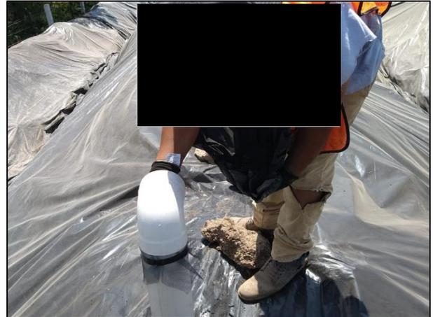
20. Colocación de filtros de carbón activado en la celda provisional.
