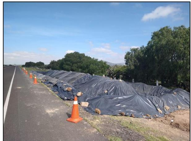
18. Material edáfico extraído y depositado en la celda, cubierto con una membrana de polietileno de alta densidad.
