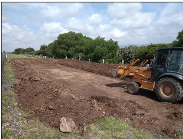
5. Se procedió al depósito de la primera capa de arcilla en la base de la celda, esto con ayuda de retroexcavadora.
