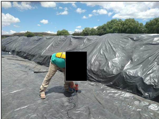
9. Con apoyo de recurso humano se realizó el termosellado de la membrana de polietileno de alta densidad.
