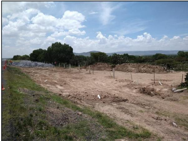
27. Vista final de la Zona de Excavación rellena, con los tubos de monitoreo colocados.
