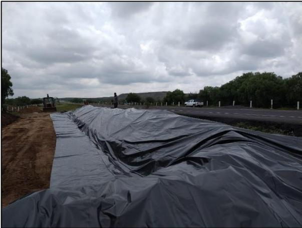
7. Los bordos de la celda provisional se cubrieron con una membrana de polietileno de alta densidad.
