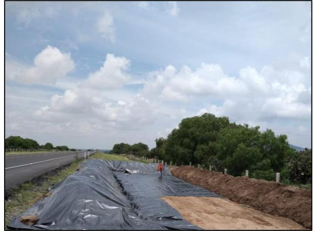
8. Con apoyo de recurso humano se cubrió la base de la celda provisional con una membrana de polietileno de alta densidad.
