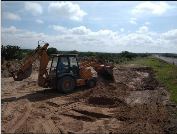
25. Con apoyo de una retroexcavadora se niveló el material edáfico utilizado como relleno.
