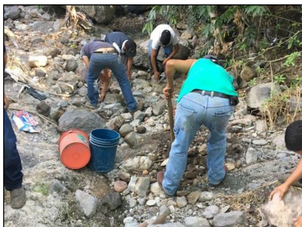
23. Con apoyo de recurso humano se realizó la extracción manual del material edáfico afectado en el Cauce del arroyo intermitente (Área II).
