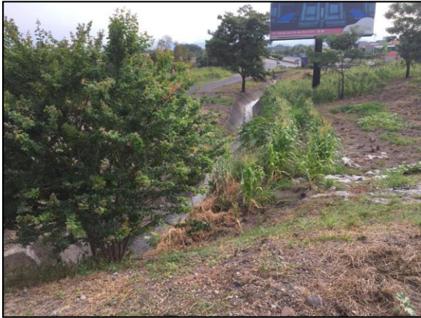
07. Canal de concreto de captación pluvial mediante la cual se desplazó el hidrocarburo.
