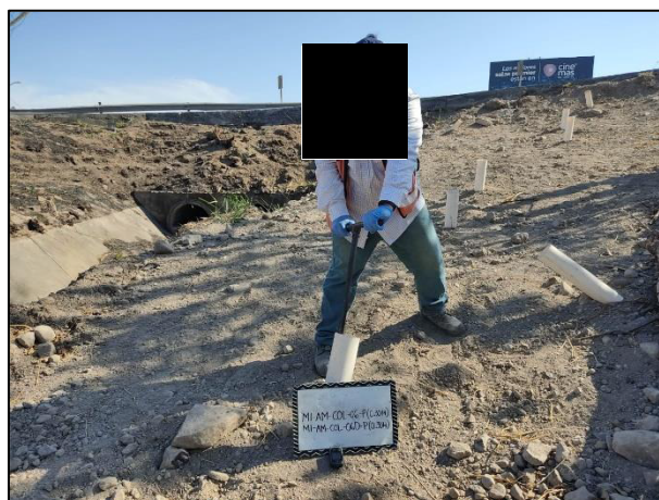
04. Se realizó la toma de muestras dentro de la Fosa de Excavación (Área I) (Pared). Además, para el aseguramiento de la calidad de las muestras se tomaron muestras duplicadas.
