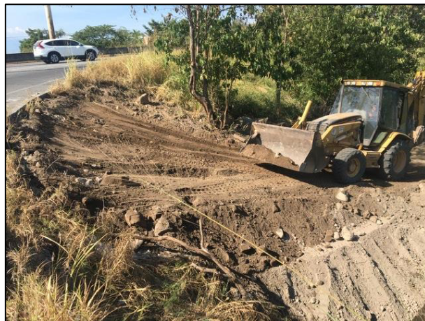
14. Con apoyo de retroexcavadora se realizó el esparcimiento del material edáfico utilizado como relleno. La Fosa de Excavación (Área I) se relleno en su totalidad.
