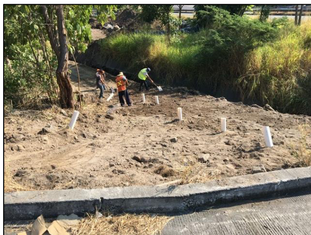
16. Actividades de colocación de tubos de muestreo en la Fosa de Excavación (Área I).
