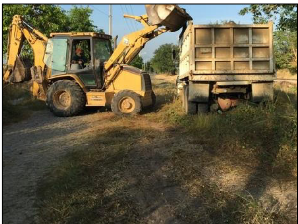
29. Colocación de material edáfico afectado por el hidrocarburo en camión de volteo.
