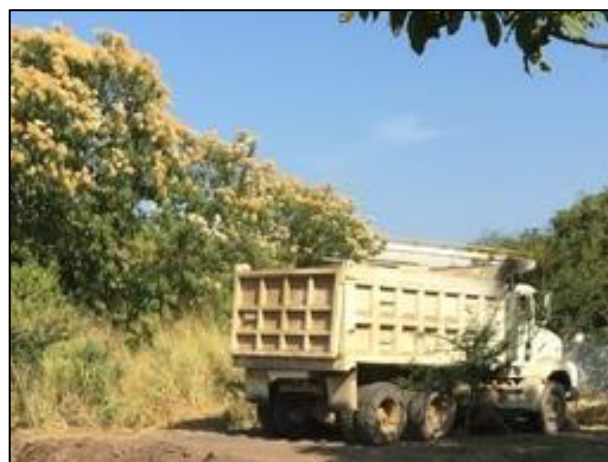
30. El material afectado de la celda provisional "B", fue acarreado y depositado en la celda provisional "A".
