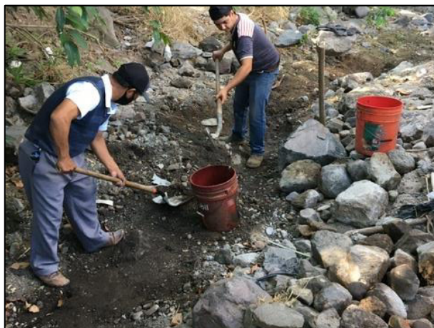
24. Actividades de extracción en el Cauce del arroyo intermitente (Área II).
