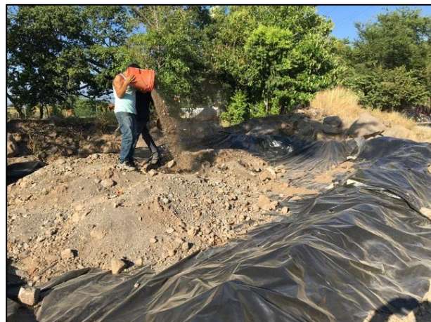
27. Celda provisional "B" con material afectado extraído del cauce de arroyo intermitente,
