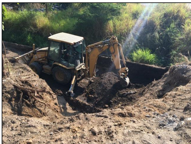
07. Con apoyo de retroexcavadora se realizó la extracción del material edáfico afectado.
