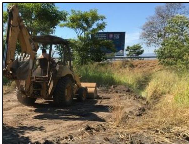
02. Con apoyo de retroexcavadora se realizó el acondicionamiento del sitio para la construcción de la calda provisional "A".
