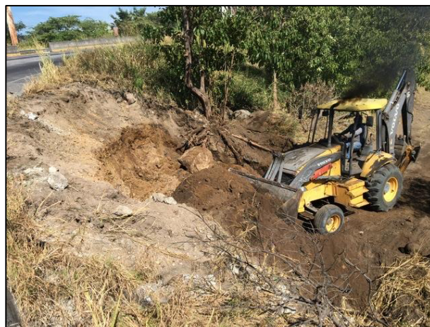
08. Extracción y acarreo de material edáfico afectado hacia la celda provisional "A".
