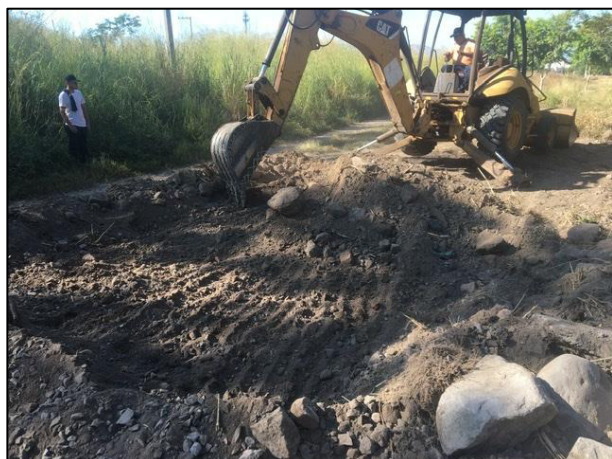
21. Construcción de canaletas para la captación de lixiviados.
