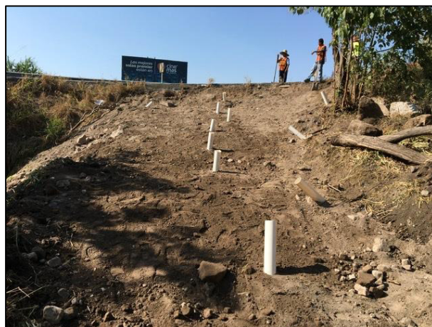
18. Fosa de Excavación (Área I) posterior a las Labores de Extracción realizadas.
