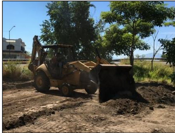
04. Se realizó la construcción de los bordos perimetrales de la celda provisional "A" con ayuda de retroexcavadora.
