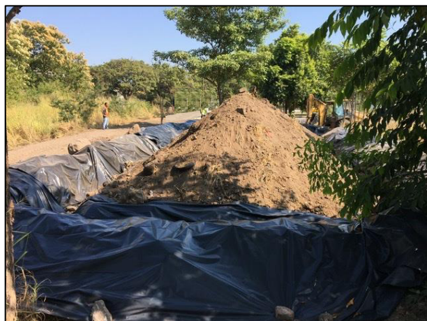
11. Material edáfico colocado en celda provisional "A".
