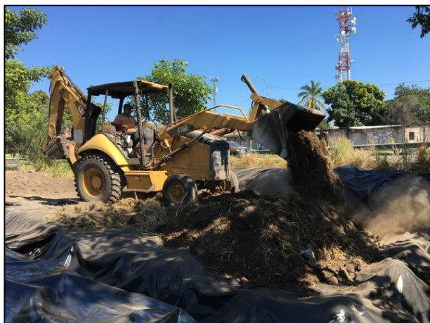
09. El material edáfico afectado fue depositado dentro de la celda provisional "A" con apoyo de retroexcavadora.
