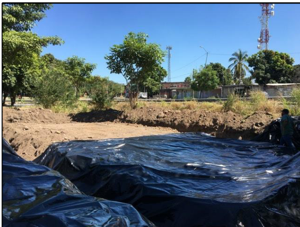
06. Con apoyo de recurso humano fue cubierta la base de la celda provisional "A" con una película de polietileno de alta densidad.
