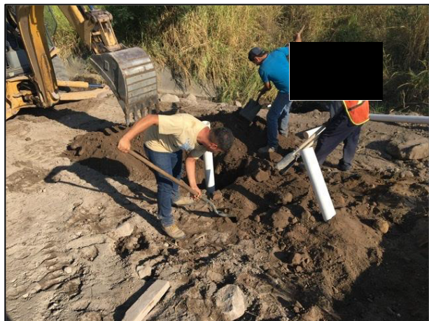
15. Posteriormente, con apoyo de maquinaria pesada y de recurso humano se realizó la colocación de tubos de muestreo.
