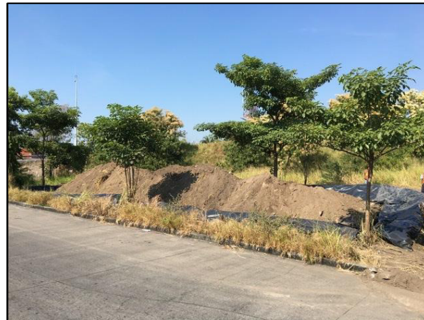
34. Toma panorámica de la celda provisional existente.
