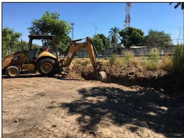
05. Construcción de canaletas para la captación de lixiviados.
