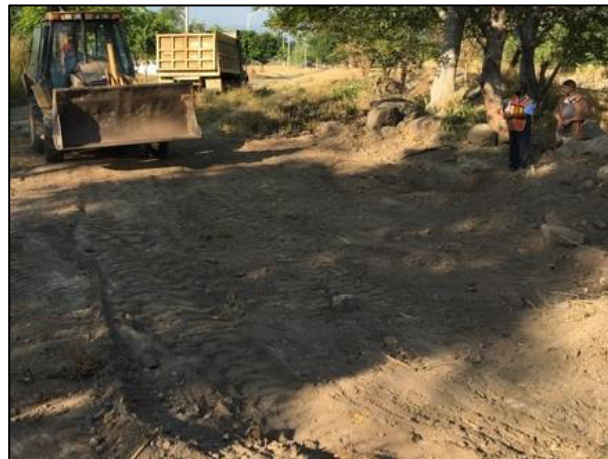
32. Sitio en donde se ubicaba la celda provisional "B". Se realizó la nivelación del sitio con apoyo de maquinaria pesada.
