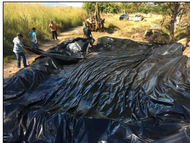
22. Se cubrió la base de la celda temporal "B" con una película de polietileno de alta densidad.
