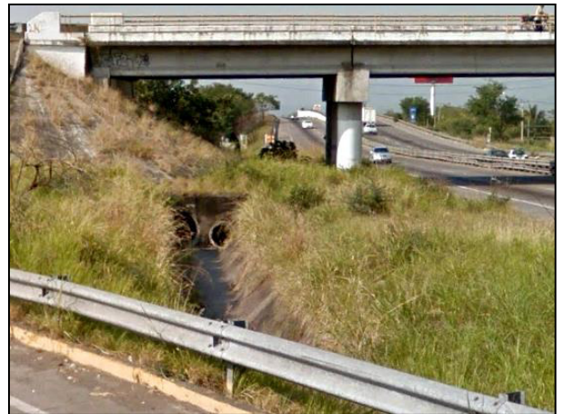
08. Canal de concreto de captación pluvial.
