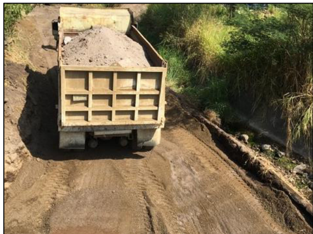
13. Relleno de Fosa de Excavación.
