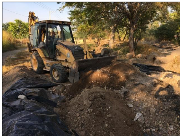
28. El material edáfico afectado en la celda provisional "B", fue colocado en camión de volteo para su posterior acarreo hacia celda provisional "A".
