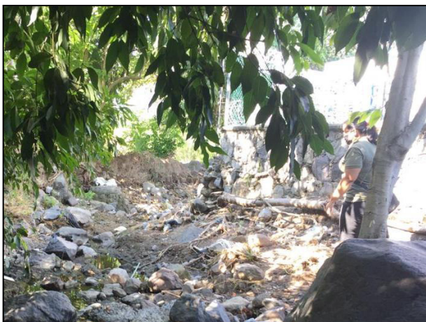
11. Presencia de rocas en el Cauce del arroyo intermitente.
