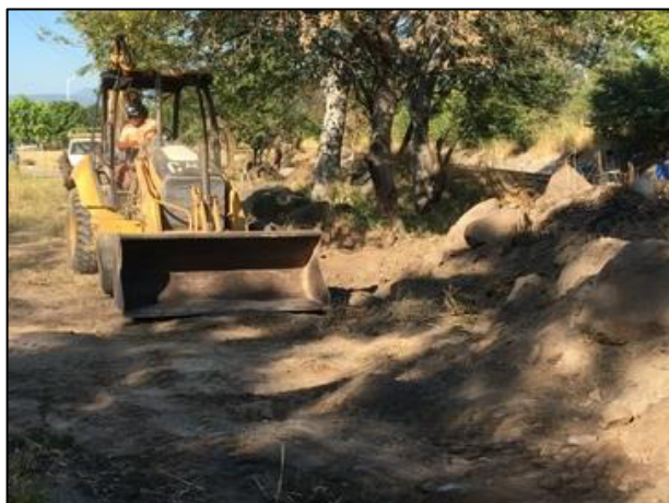
19. Con apoyo de retroexcavadora se realizó el acondicionamiento del sitio para la construcción de la calda provisional "B".
