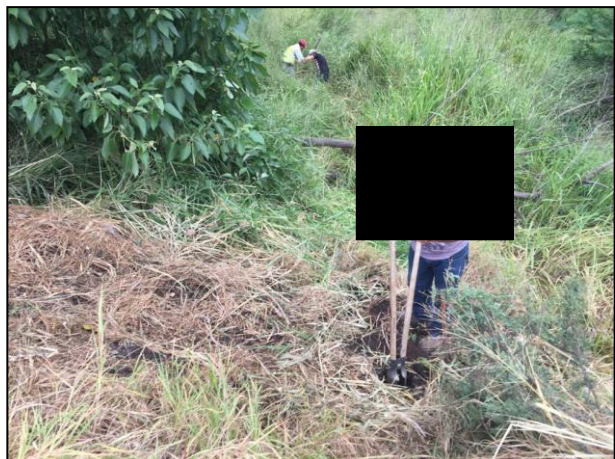
04. Se realizaron sondeos en el sitio afectado con apoyo de pocera.
