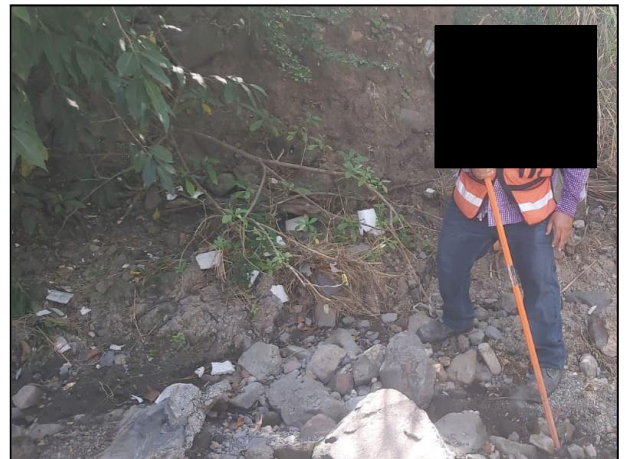
10. Presencia de roca madre en el Cauce del arroyo intermitente.
