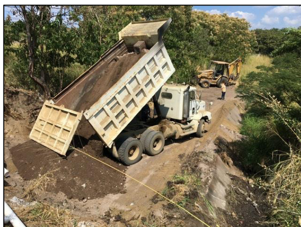
12. Se realizó el relleno de la Fosa de Excavación (Área I) con suelo libre de contaminantes.
