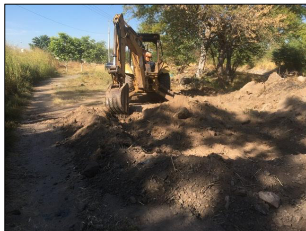
20. Se realizó la construcción de los bordos perimetrales de la celda provisional "B" con ayuda de retroexcavadora.
