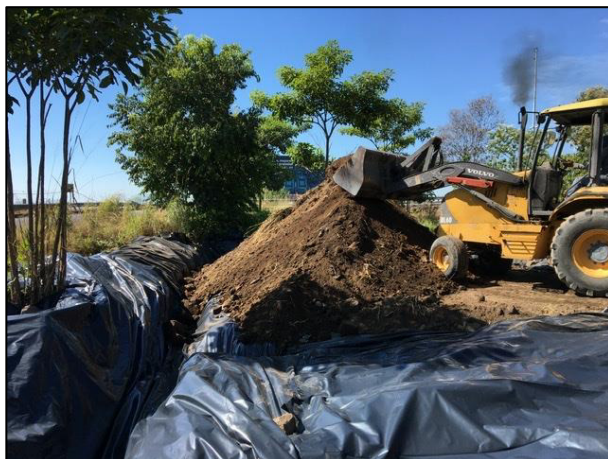
10. Colocación del material edáfico afectado dentro de la celda provisional "A".
