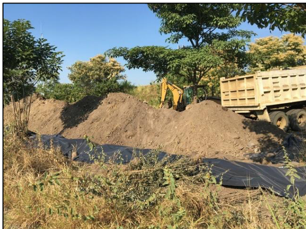
31. Actividades de depósito del material afectado en celda provisional "A".
