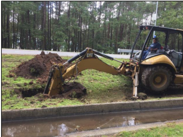
03 - Para la realización de los sondeos en la Zona afectada A se utilizó la ayuda de maquinaria pesada como lo es la retroexcavadora.
