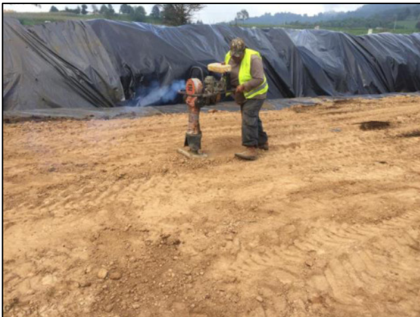
09 - Con apoyo de una compactadora manual, se realizó la compactación de la segunda capa de arcilla.
