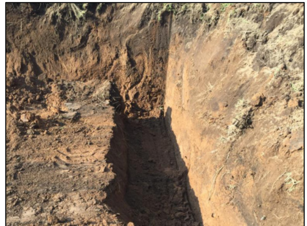
04 - Construcción de canaletas para la captación de lixiviados.
