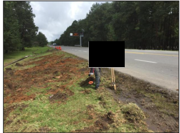
02 - Con el objetivo de delimitar la infiltración de la sustancia en el suelo natural de las Zonas afectadas, se realizaron sondeos en el sitio.
