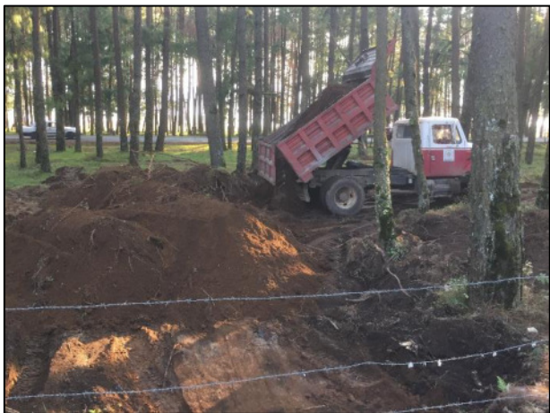
21 - La Fosa de Excavación B resultada de la extracción, fue rellenada con material edáfico libre de contaminantes, esto con la ayuda de camión de volteo.
