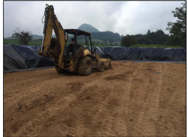
08 - Se realizó la colocación de una segunda capa de arcilla sobre la base de la Celda Provisional, y se extendió dicha capa de arcilla con ayuda de retroexcavadora.
