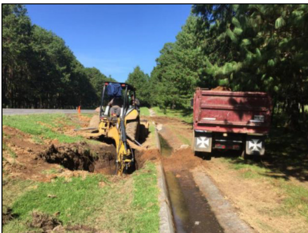
11 - Labor de extracción del material edáfico afectado por el derrame de Turbosina. Extracción de material de la Zona afectada A.
