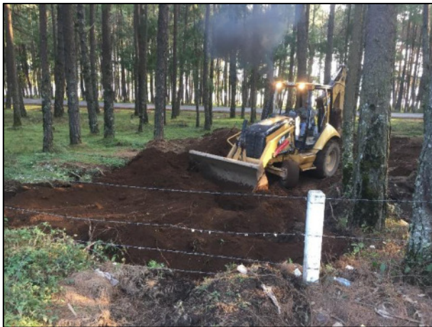
15 - Extracción del material edáfico afectado de la Zona afectada B.
