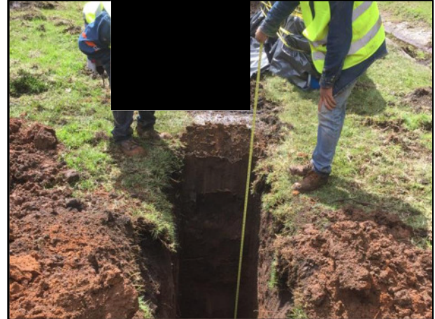
04 - Con apoyo de flexómetro se verificó la profundidad de los puntos de sondeo de las Zonas afectadas.
