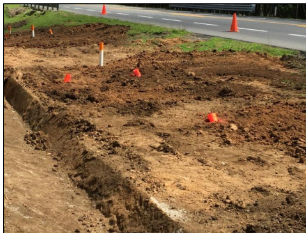
20 - Instalación completa de la tubería PVC dentro de la Fosa de Excavación A, tubería que será usada durante el Muestreo Inicial.
