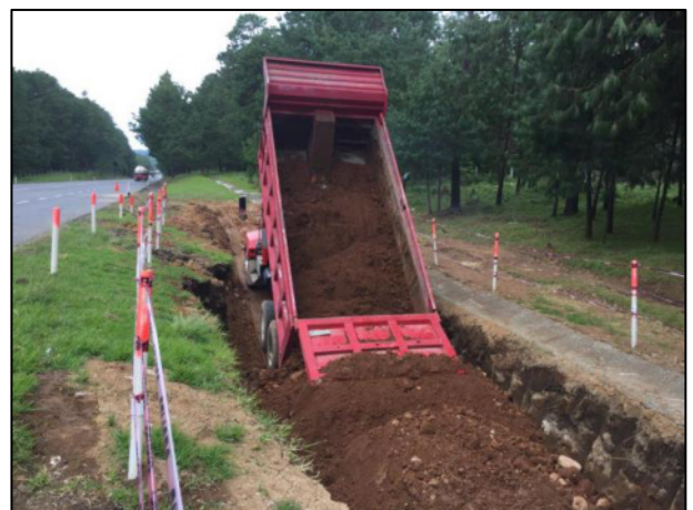
18 - La Fosa de Excavación A resultada de la extracción, fue rellenada con material edáfico libre de contaminantes, esto con la ayuda de camión de volteo.
