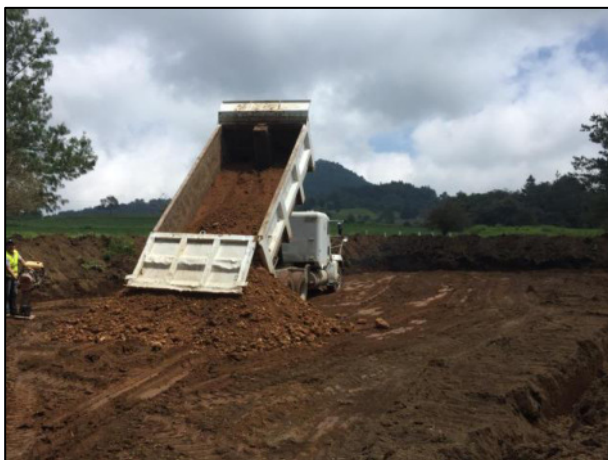
05 - Con apoyo de camiones de volteo se colocó una capa de arcilla en la base de la Celda Provisional.
