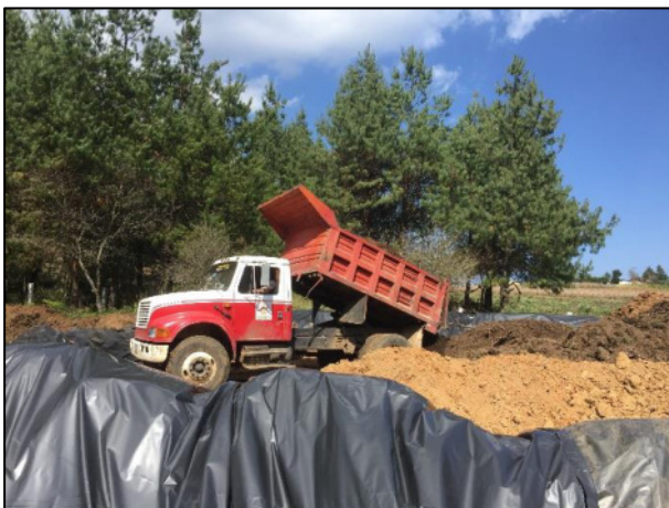
17 - Depósito del material edáfico afectado en Celda Provisional.
