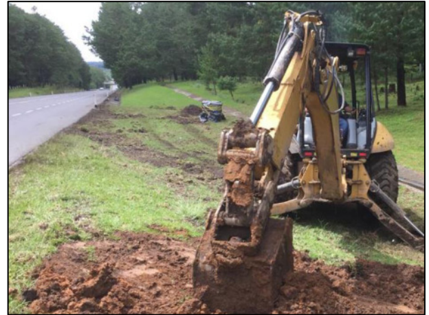
10 - Posteriormente, con ayuda de retroexcavadora se realizó la extracción del material edáfico afectado en el sitio de derrame. Extracción de material de las Zonas afectadas C y D.
