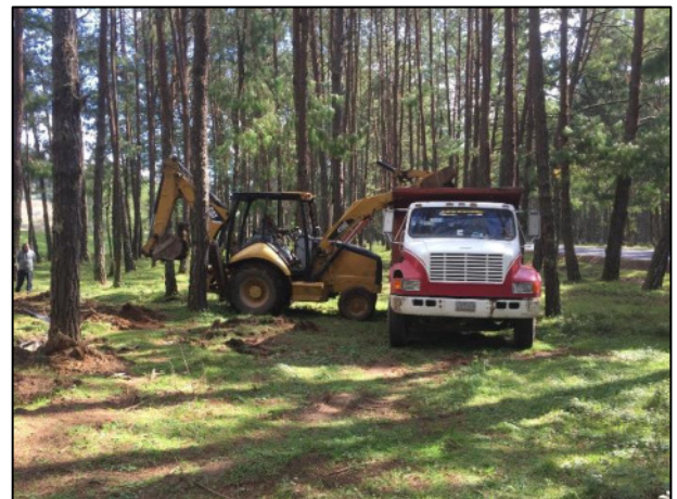
16 - Colocación del material edáfico afectado en camión de volteo para su acarreo hacia la Celda Provisional.
