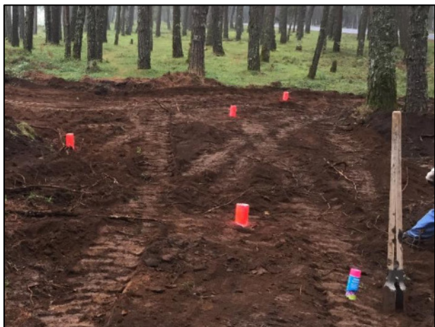
23 - Instalación completa de la tubería PVC dentro de la Fosa de Excavación B, tubería que será usada durante el Muestreo Inicial.
