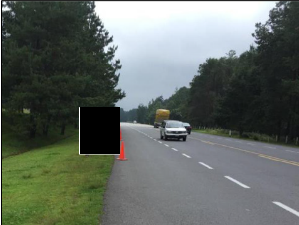
01 - Por seguridad, se colocó señalización preventiva en el área de trabajo, así como abanderamiento de este.
