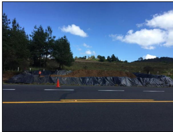
24 - Celda Provisional construida y en la cual se colocó el material edáfico afectado con Turbosina.
