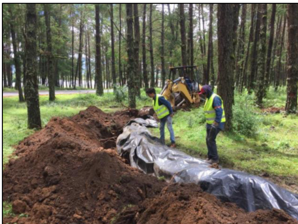
05 - Se realizó la construcción de una zanja perimetral alrededor de la Zona afectada B, con el objetivo de contener el derrame de Turbosina y la afectación al sitio.
