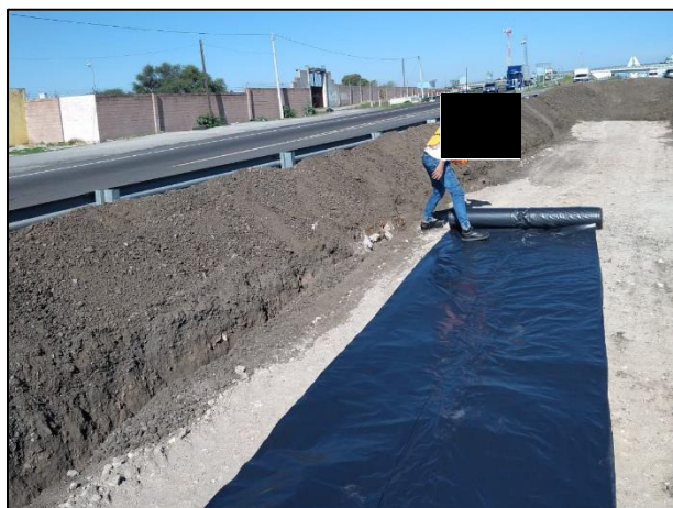
7. Con apoyo de recurso humano se cubrió la base de la celda provisional con una membrana de polietileno de alta densidad.
