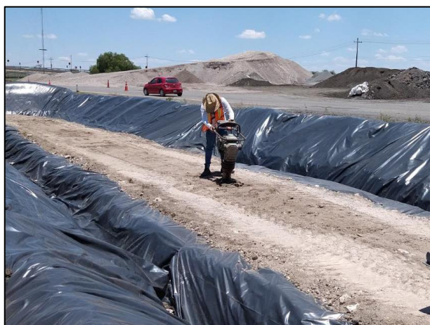
11. Con apoyo de recurso humano y de un vibro compactador manual, se realizó la compactación de la arcilla.
