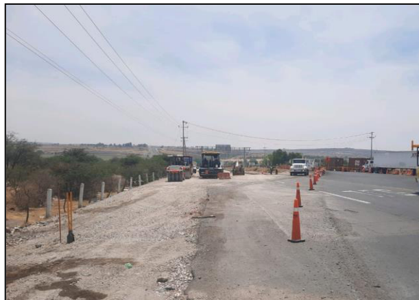
4. Se observó que cerca del sitio de afectación, se encontraba en construcción el tramo carretero.
