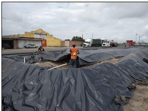
19. Material edáfico extraído y depositado en la celda, cubierto con una membrana de polietileno de alta densidad.
