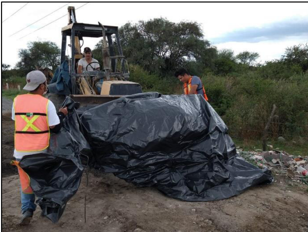
15. Acarreo del material edáfico afectado a la celda provisional, todo esto, evitando lo mayor posible la transferencia de COV's a la atmósfera.
