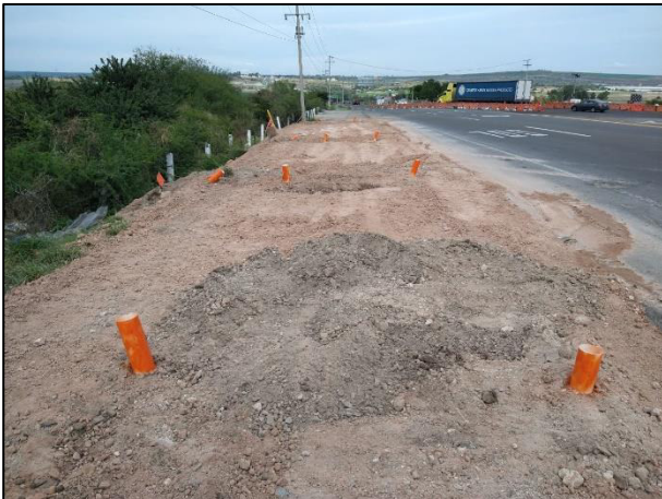
27. Vista final de la Fosa de Excavación rellena, con los tubos de monitoreo colocados.
