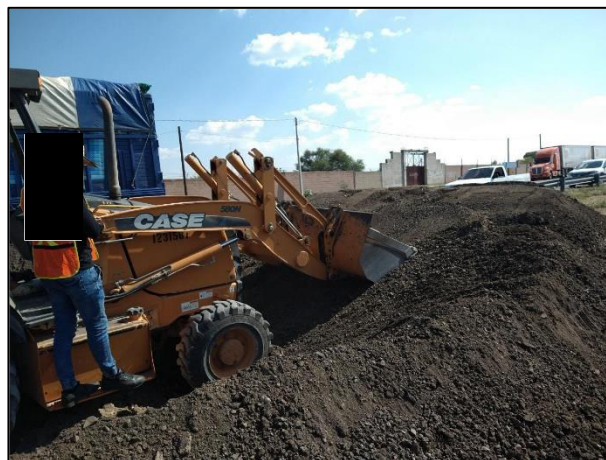
2. Se construyeron los bordos de la celda de provisional con material edáfico libre de contaminantes.
