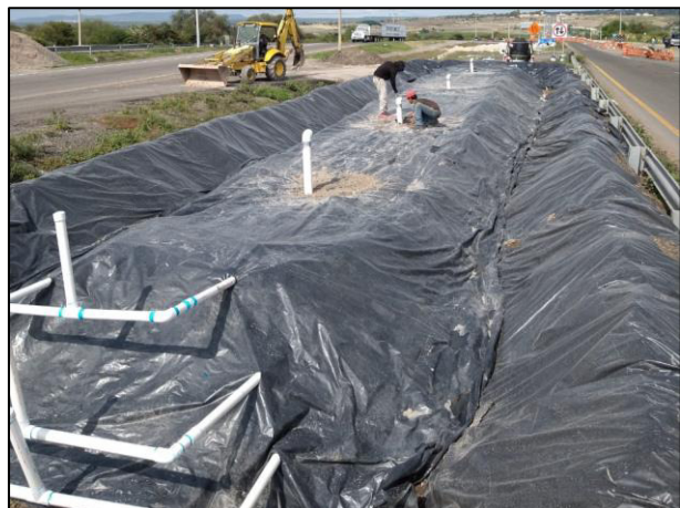
21. Vista de la celda provisional con la red de tubería instalada, así como con los filtros de carbón activado.
