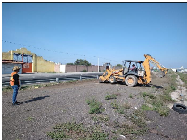
1. Acondicionamiento del terreno para la construcción de la celda provisional, con apoyo de maquinaria pesada.
