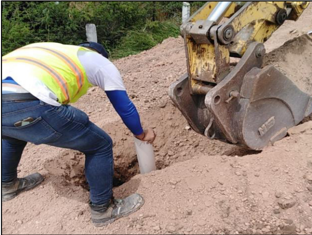
25. Con apoyo de una retroexcavadora se colocaron los tubos de monitoreo.
