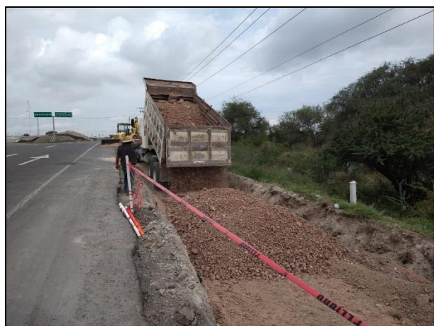
23. Se procedió a rellenar la Fosa de Excavación con material libre de contaminantes, a fin de preservar la integridad estructural de la carpeta asfáltica y la fibra óptica.
