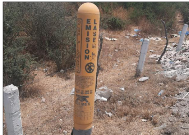
10. Es importante mencionar que en el sitio se observó postería de TELMEX que indica la presencia de fibra óptica,
