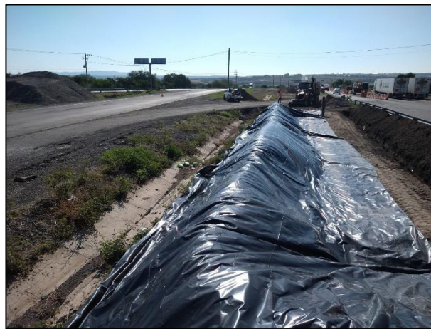
8. Los bordos de la celda provisional se cubrieron con una membrana de polietileno de alta densidad.
