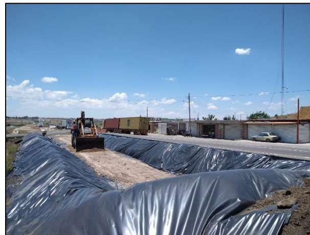
10. Para reforzar la impermeabilidad de la base de la celda, se colocó una segunda capa de arcilla sobre la membrana de polietileno.
