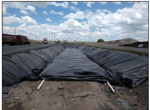
18. Se instaló la tubería entre cada capa de material edáfico colocado en la celda provisional.
