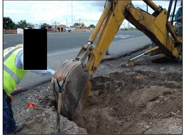
14. Extracción del material edáfico afectado con Gasolina y Diésel.
