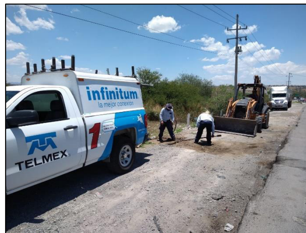
12. Antes de realizar la extracción del material edáfico afectado, personal de TELMEX procedió a la señalización de la fibra óptica.
