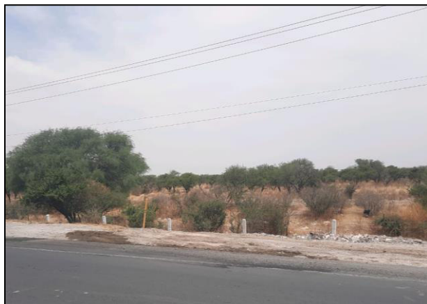
11. Vista del sitio afectado, cerca de la superficie de rodamiento.
