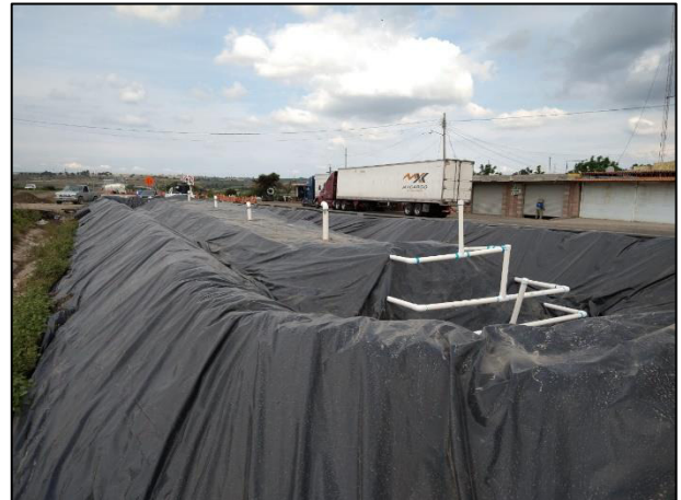
28. Vista final de la celda provisional.
