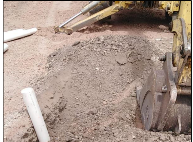
26. Tubos de monitoreos en instalación.
