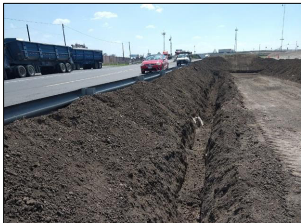
3. Construcción de canaletas perimetrales para captación de lixiviados.
