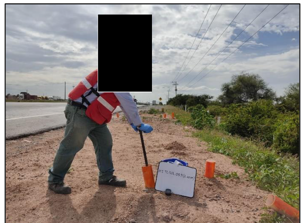
6. Se realizó la toma de muestras en la pared entre Zona A y B de la Fosa de Excavación.
