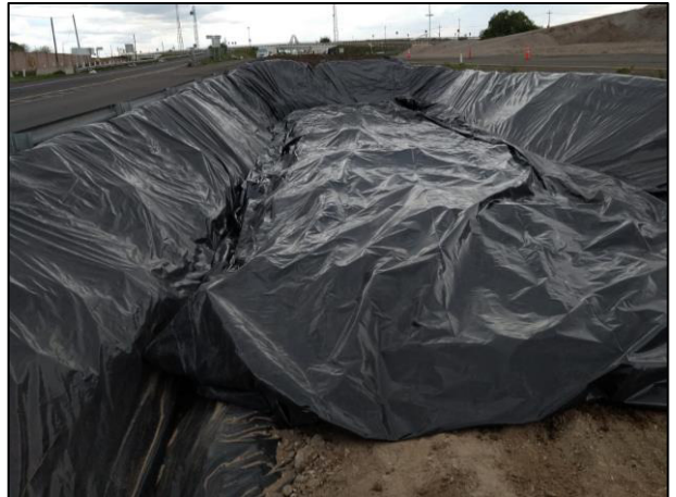
16. El material edáfico colocado en la Celda Provisional, estuvo cubierto durante su depósito.
