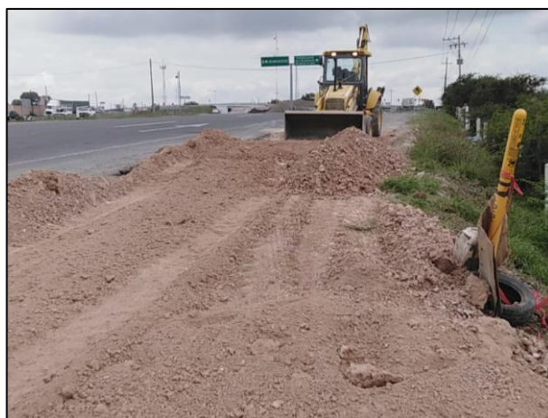
24. Con apoyo de una retroexcavadora se niveló el material edáfico utilizado como relleno.
