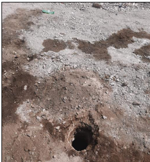
5. Se realizaron sondeos en el suelo afectado.
