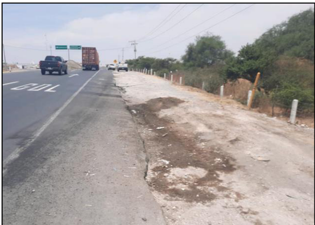
3. El suelo afectado pertenece al derecho de vía de la carretera.
