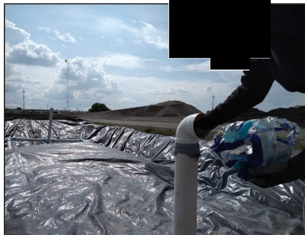
20. Colocación de filtros de carbón activado en la celda provisional.
