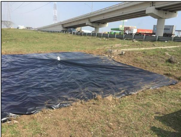
09. Área Afectada cubierta con película de polietileno de alta densidad y filtros de carbón activado.
