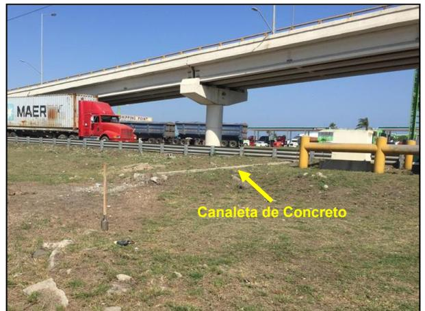
02. Área Afectada por el derrame de Gasolina. El hidrocarburo se desplazó por canaleta de concreto hasta desembocar en suelo natural.
