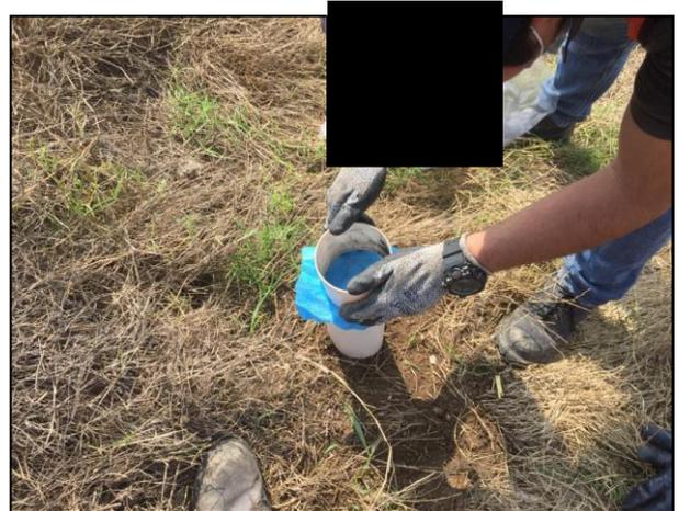
02. De manera manual se instalaron filtros de carbón activado en el Área Afectada.
