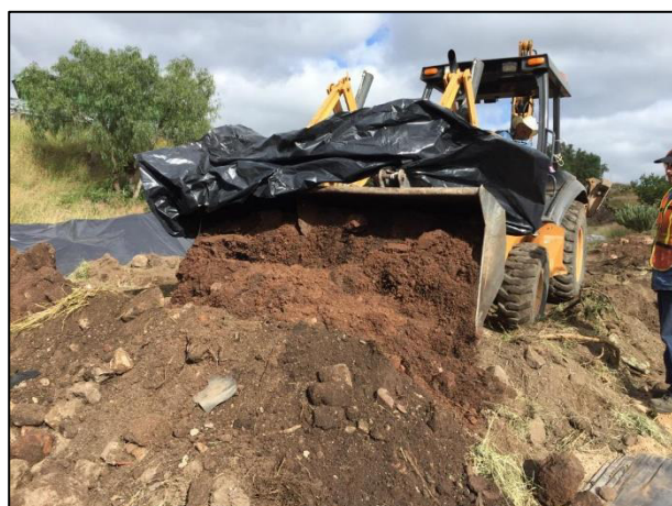
22. Depósito del material edáfico en la Celda Provisional.
