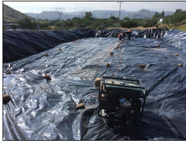
10. Termosellado de la película de polietileno.
