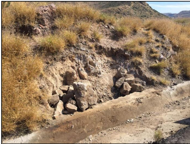
27. Talud de la carretera, sometida a labores de extracción, misma que pertenece a un cerro, motivo por el cual se observa la presencia de rocas.
