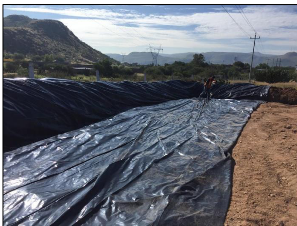
9. Seguidamente con la finalidad de aumentar la impermeabilidad de la base de la Celda, se procedió a colocar una película de polietileno de alta densidad.
