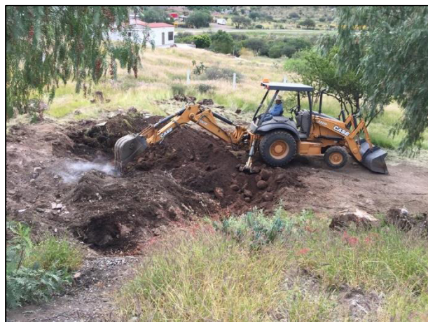
24. Durante la extracción, se observó la presencia de base de roca madre a distintas profundidades.
