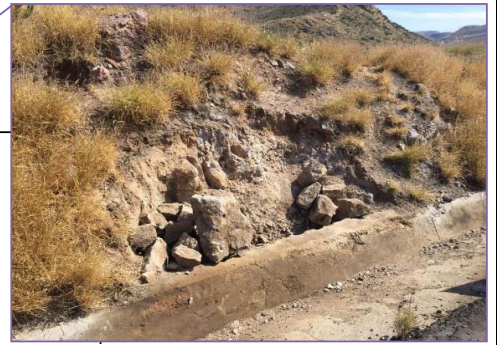
Ilustración 2. Vista de la Zona de Extracción encontrada en el talud de la carretera (cerro).
