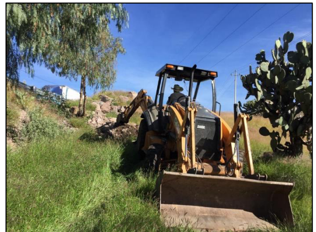
18. De igual manera se procedió a la extracción del material edáfico afectado perteneciente al derecho de vía.
