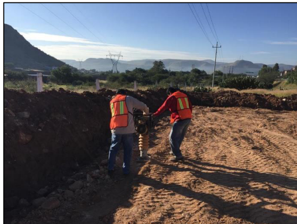
8. Con apoyo de recurso humano y de un vibro compactador manual, se realizó la compactación de la primera capa de arcilla.
