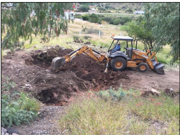
23. Extracción de material edáfico afectado en el derecho de vía.
