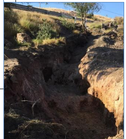
Ilustración 4. Vista de la Zona A, B, C, D y E, pertenecientes a la Fosa de Excavación, así como de los "escalones" de roca madre, resultantes de la extracción.
