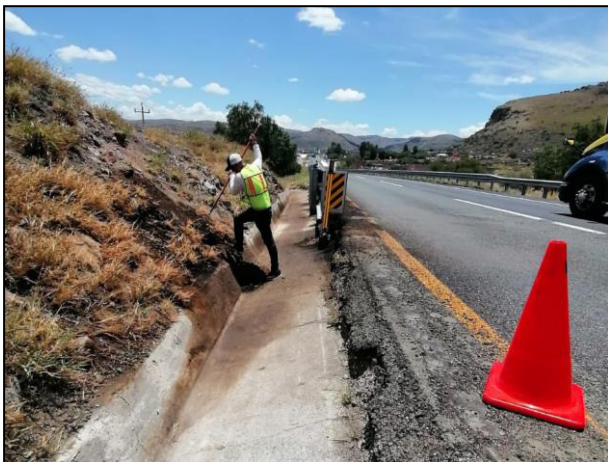
11. Durante la realización de sondeos y levantamiento de datos, el sitio fue señalado por seguridad.
