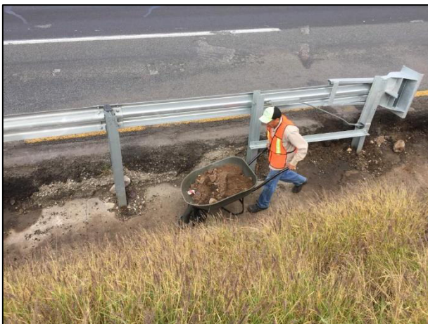
17. Acarreo del material edáfico extraído, esto con apoyo de carretillas.
