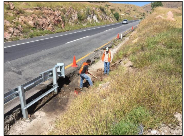
16. Extracción de material edáfico afectado en el talud de la carretera.
