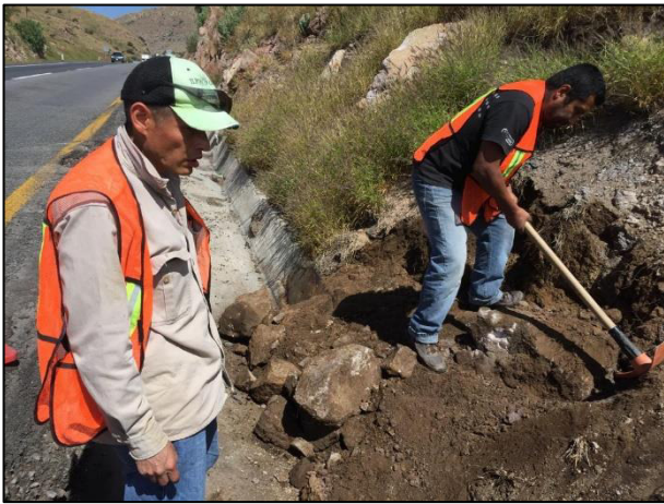
15. En el talud de la carretera se observa la presencia de rocas ya que este pertenece a un cerro.
