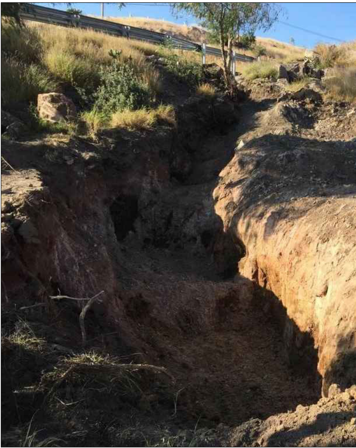
FOSA DE EXCAVACION (DERECHO DE VIA)
