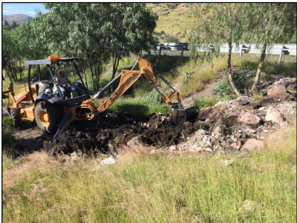
19. Extracción del material edáfico afectado por el derrame de Diésel, esto con apoyo de retroexcavadora.
