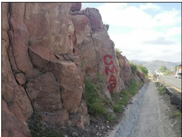
3. Es importante mencionar que seguidamente, el Diésel se desplazó en dirección Sur a través de una canaleta de concreto encontrada a un lado de la carretera.
