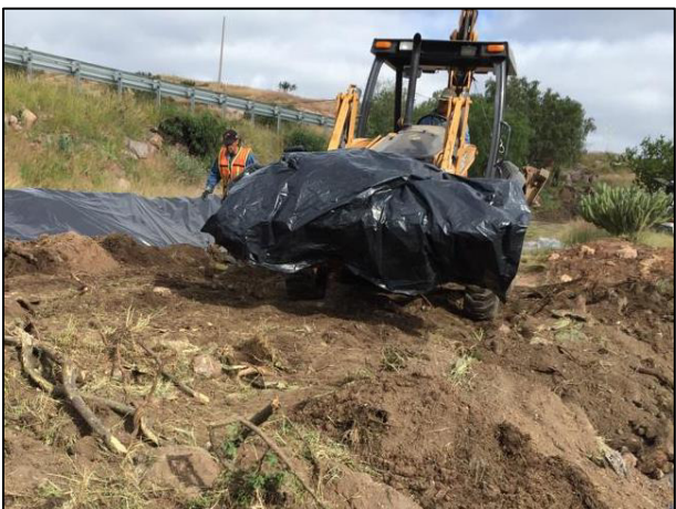
21. Material edáfico afectado colocado en la Celda Provisional.
