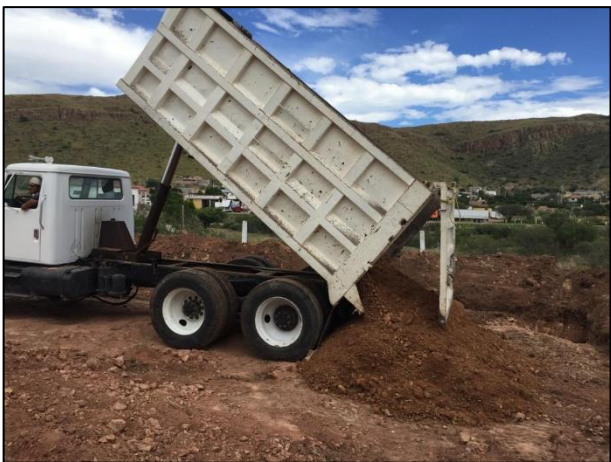
5. Colocación de primera capa de arcilla con apoyo de maquinaria pesada.
