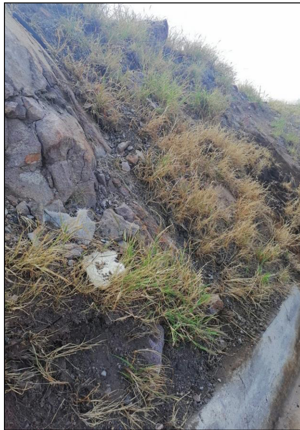
2. El Diésel afectó el poco material edáfico presente en el área del talud afectado, dicho talud es parte de un cerro, motivo por el cual presenta roca madre.
