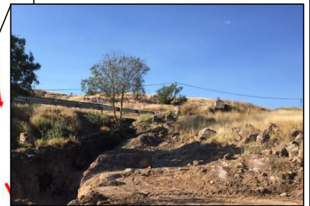
Ilustración 3. En la parte derecha se observa la Zona F de la Fosa de Excavación, en la cual no se generaron paredes, quedando como un "socavón".
