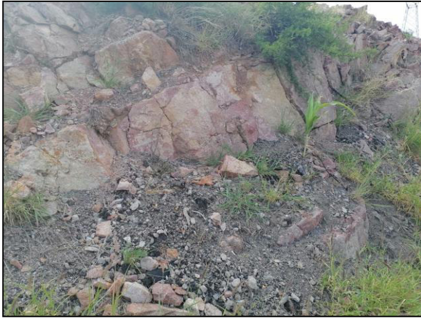
5. Se observa la presencia de material edáfico en el talud de la carretera, así como roca madre visible.
