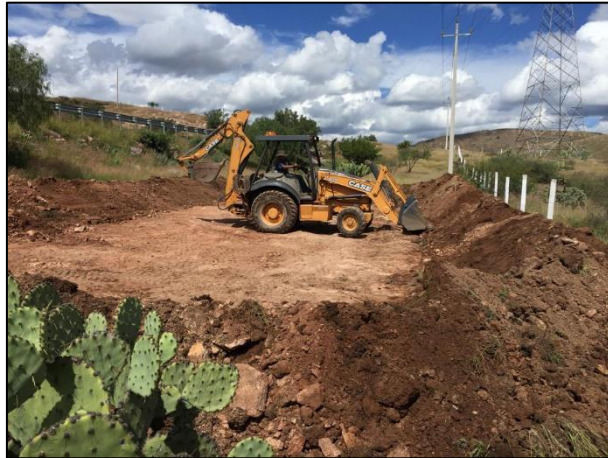
2. Construcción y compactación de bordos.
