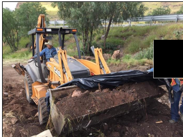
20. Se procedió al acarreo del material edáfico afectado a la Celda Provisional construida.
