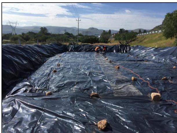
11. Vista de la Celda Provisional cubierta con película de polietileno de alta densidad.
