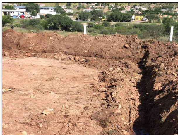
4. Vista de canaletas y bordos de la Celda Provisional.
