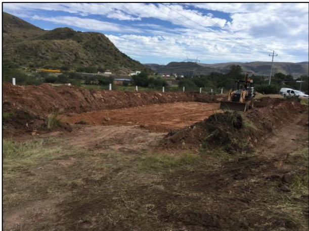
7. Colocación de primera capa de arcilla en la base de la Celda Provisional.
