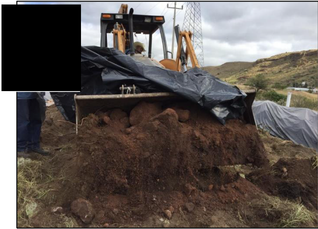
25. Depósito del material edáfico en la Celda Provisional.
