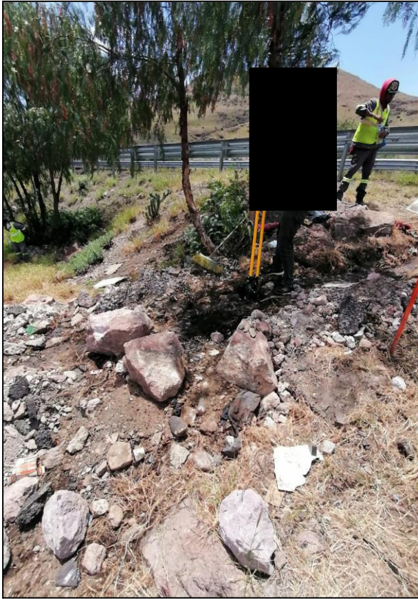
9. Realización de los pozos de sondeos con la finalidad de conocer la infiltración del Diésel derramado, siendo importante mencionar que se observan rocas de distintos tamaños.
