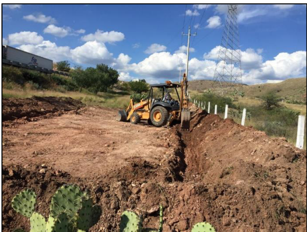
3. Posteriormente, se construyó el cárcamo y las canaletas para la captación de lixiviados.
