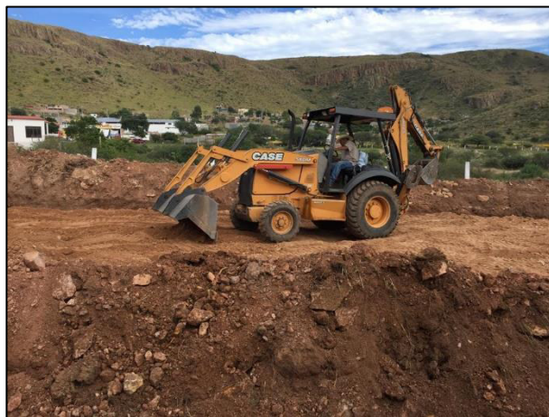
6. Distribución de la capa de arcilla en la base de la Celda, esto con apoyo de retroexcavadora.
