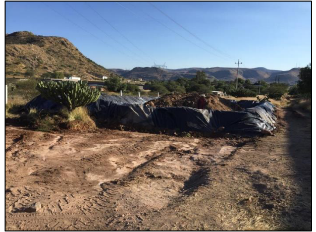
26. Vista de la Celda Provisional donde se colocó todo el material edáfico afectado y extraído.
