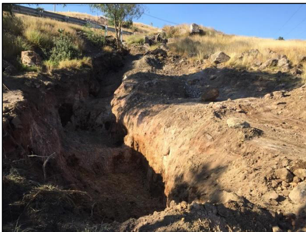
29. Fosa de Excavación sometida a extracción, encontrando base de roca madre en diferentes partes de este.
