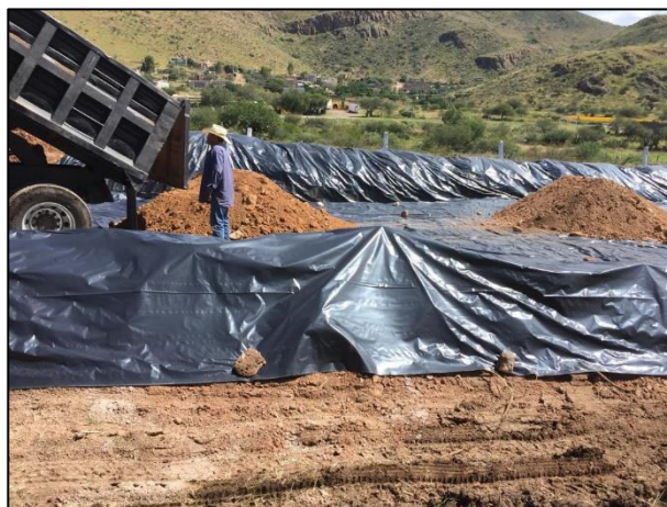
12. Se procedió a colocar la segunda capa de arcilla.
