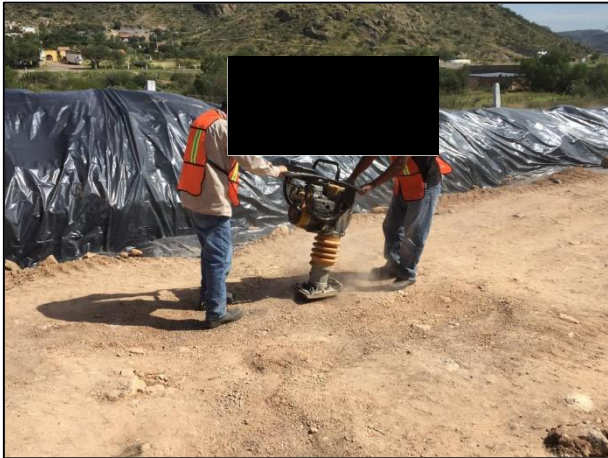
13. Compactación de la capa de arcilla con apoyo de un vibro compactador manual.
