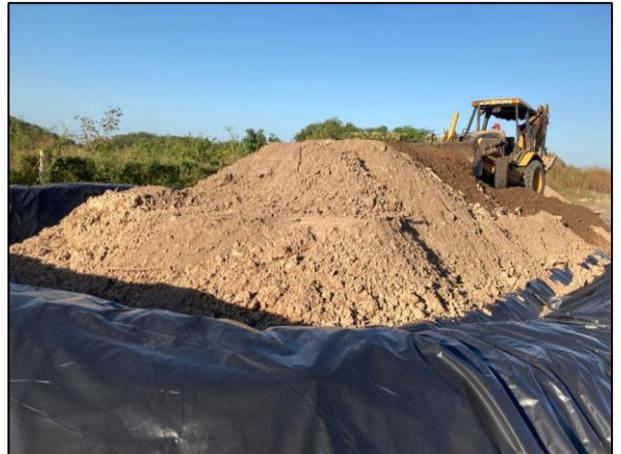
28. Con apoyo de retroexcavadora se distribuyó el material depositado en las Celdas Provisionales.
