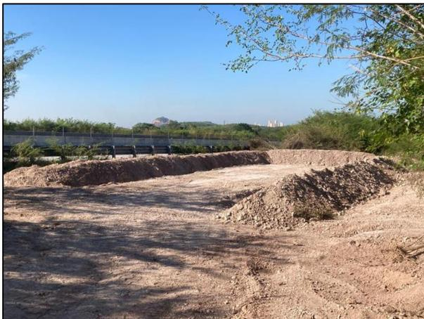
05. Celda Provisional "A" con bordos y canaletas de captación de lixiviados.
