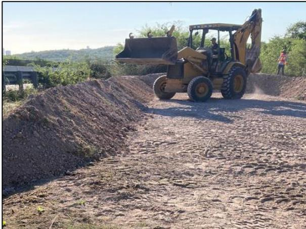
03. Se realizó la construcción de los bordos perimetrales de la Celda Provisional "A" con ayuda de retroexcavadora.
