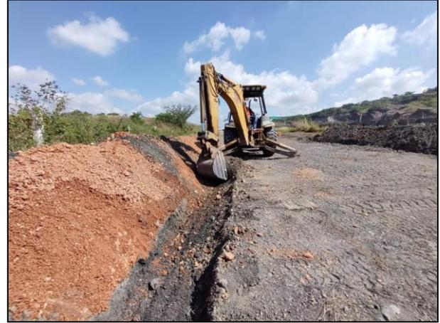
16. Con apoyo de retroexcavadora se llevó a cabo la construcción de las canaletas para la captación de lixiviados.
