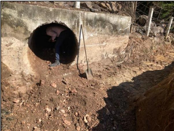
21. Con apoyo de recurso humano se realizó el retiro del material edáfico azolvado afectado presente en el dren pluvial subterráneo que cruza la carretera. Dicho material fue depositado en la Celda Provisional "B".
