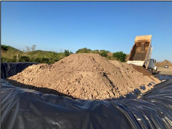
27. El material edáfico afectado fue depositado dentro de la Celda Provisional "B" con apoyo de camión de volteo.
