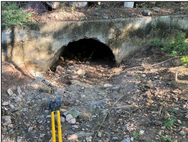
09. Dren pluvial subterráneo con presencia de material azolvado afectado por el derrame de Diésel. (Salida de dren pluvial).
