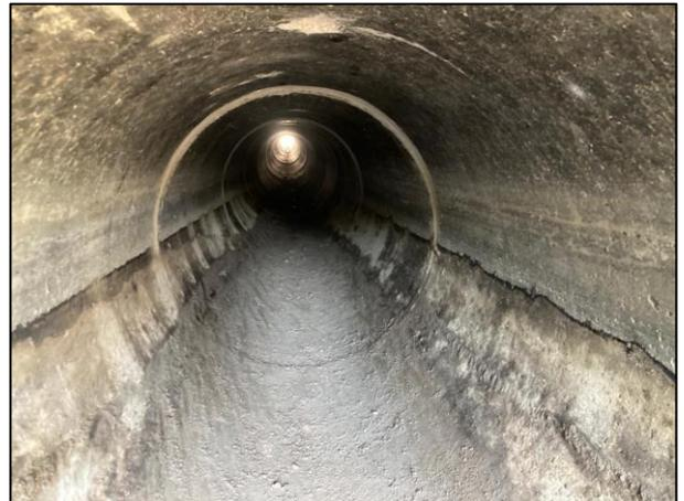
22. Dren pluvial posterior a la extracción del material edáfico azolvado afectado.
