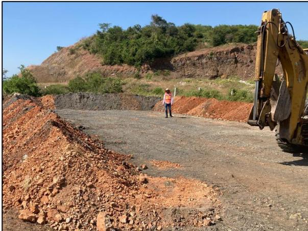
15. Se realizó la construcción de los bordos perimetrales de la Celda Provisional "B" con ayuda de retroexcavadora.
