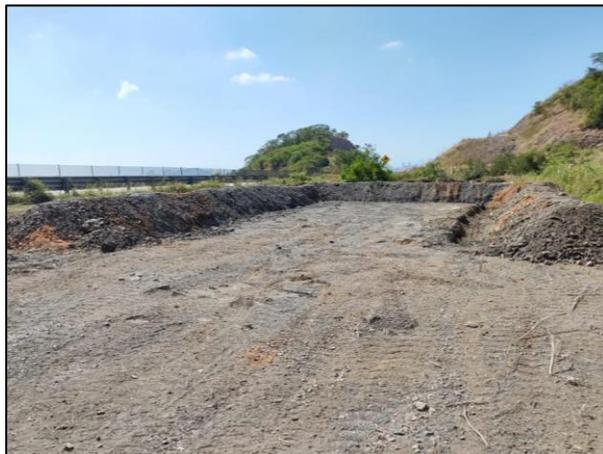
17. Celda Provisional "B" con bordos y canaletas de captación de lixiviados.
