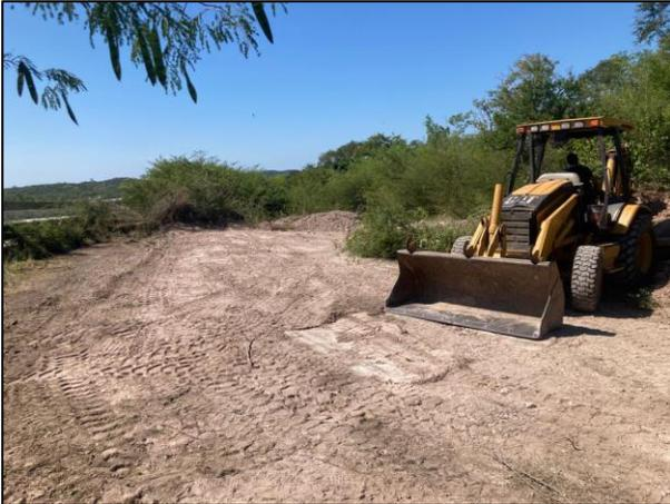
01. Con apoyo de retroexcavadora se realizó el acondicionamiento del sitio para la construcción de la Celda Provisional "A".
