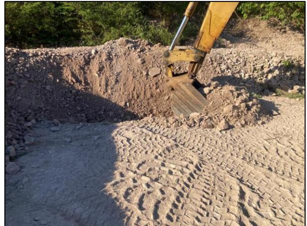
04. Con apoyo de retroexcavadora se llevó a cabo la construcción de las canaletas para la captación de lixiviados en ambas celdas.
