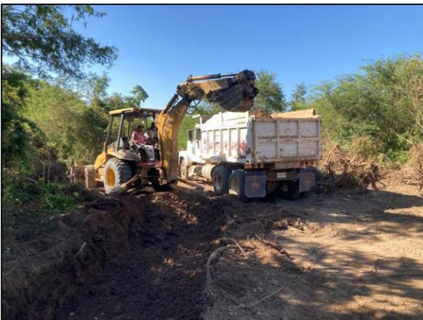
23. El material edáfico extraído fue colocado en camión de volteo para su posterior acarreo hacia la Celda Provisional "B".
