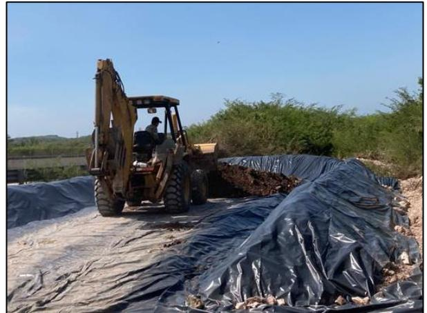
10. El material edáfico afectado fue depositado dentro de la Celda Provisional "A" con apoyo de retroexcavadora.
