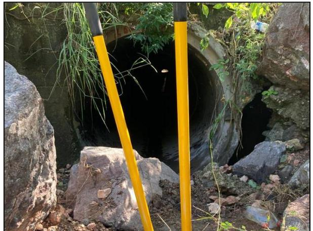
08. Dren pluvial subterráneo de concreto mediante el cual el hidrocarburo se desplazó hasta desembocar nuevamente en suelo natural. (Entrada de dren pluvial).
