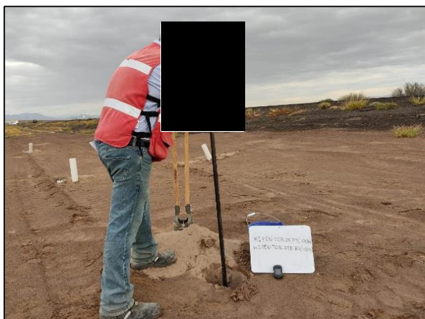
11. Toma de muestra en el material utilizado como relleno de la Fosa de Excavación.
