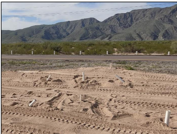
23. Vista general de la Fosa de Excavación rellena en su totalidad. Tubos de muestreo presentes en la misma.
