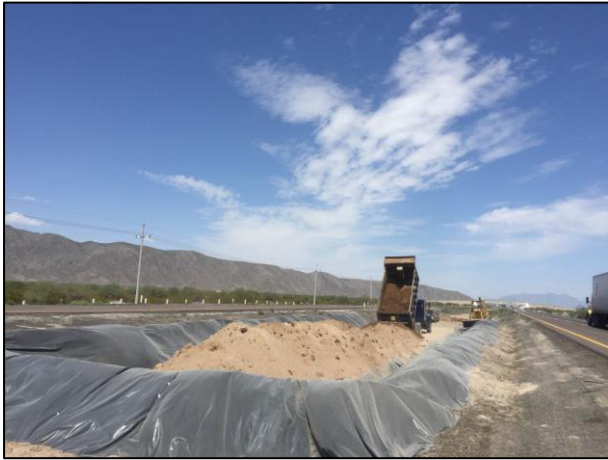
19. Depósito del material edáfico afectado en celda provisional.
