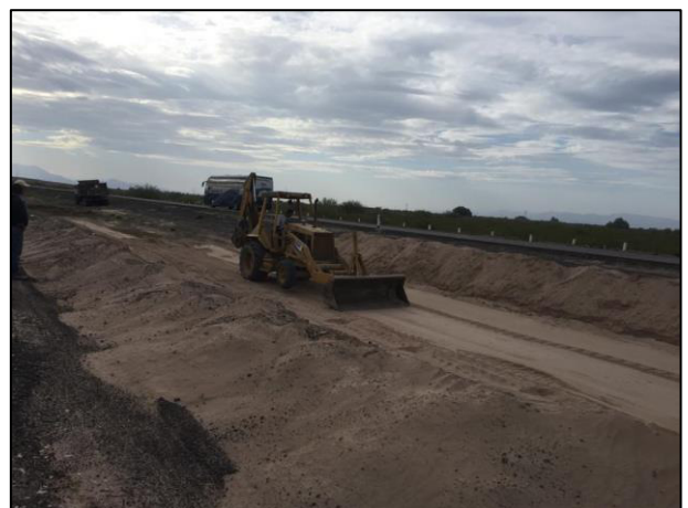
06. Con apoyo de retroexcavadora se distribuyó la capa de arcilla.
