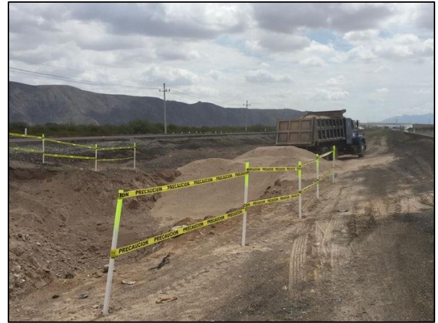
20. Se realizó el relleno de la Fosa de Excavación con suelo libre de contaminantes.
