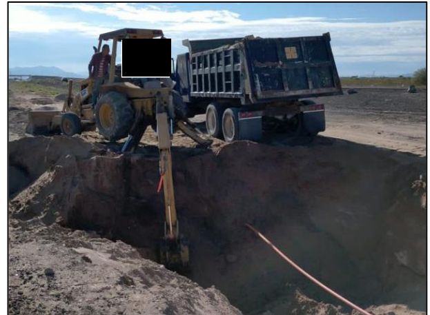
14. Actividades de extracción en el Área Afectada por el hidrocarburo perteneciente al camellón central.
