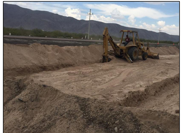
04. Construcción de canaletas de captación de lixiviados.
