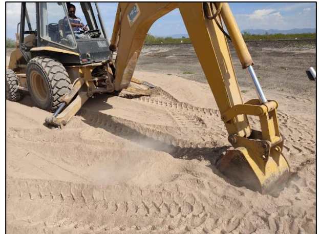
22. Posteriormente, con apoyo de maquinaria pesada se realizó la colocación de tubos de muestreo.
