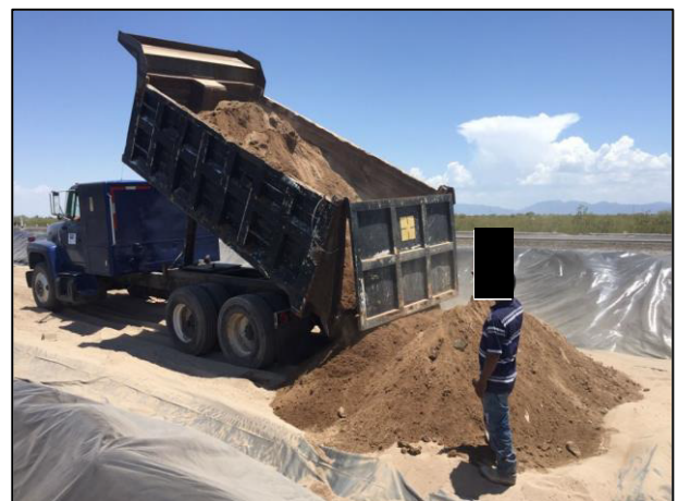
18. Actividades de acarreo y depósito de material edáfico afectado en celda provisional.
