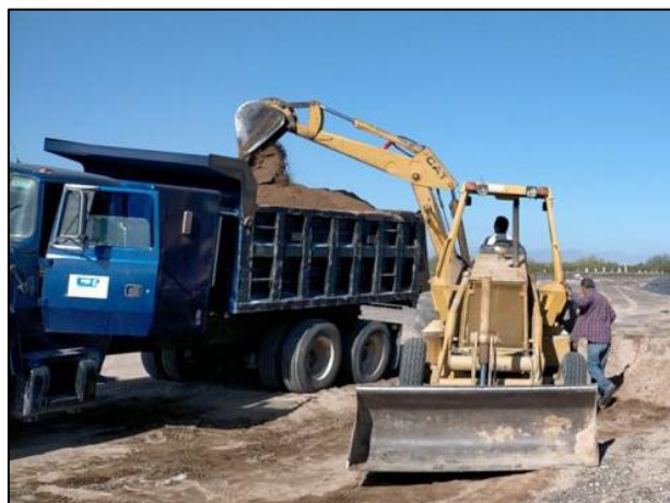
17. Con apoyo de retroexcavadora y camión volteo, el material edáfico extraído, fue acarreado a la celda provisional.
