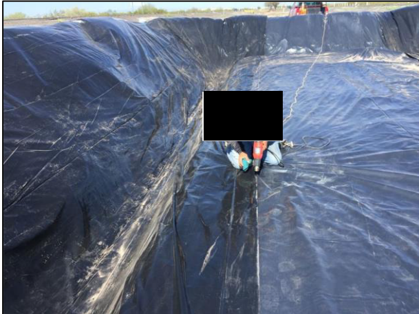
09. Se realizó el termosellado de las uniones de la película de polietileno de alta densidad.
