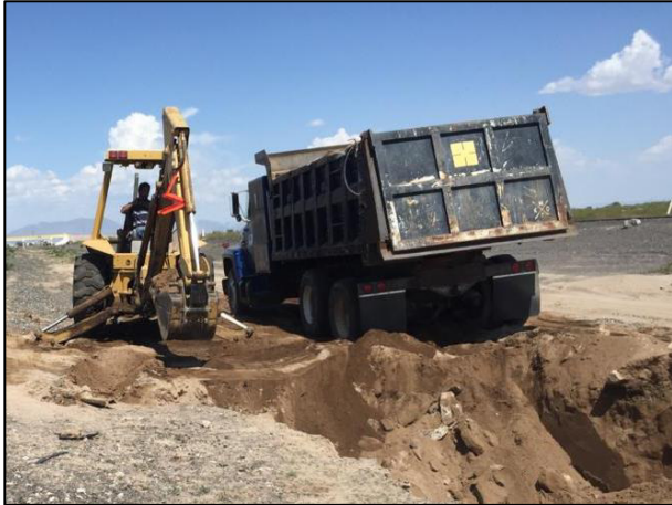
13. Con apoyo de retroexcavadora se realizó la extracción del material edáfico afectado con Diésel.
