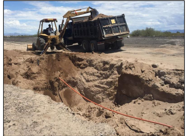
16. Depósito del material edáfico afectado en camión de volteo para su posterior acarreo a celda provisional.
