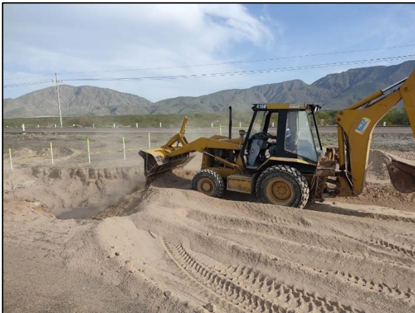
21. La Fosa de Excavación se relleno en su totalidad con material edáfico libre de contaminantes.
