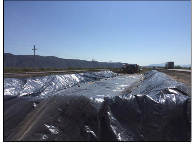
08. La celda provisional se cubrió con una película de polietileno de alta densidad.
