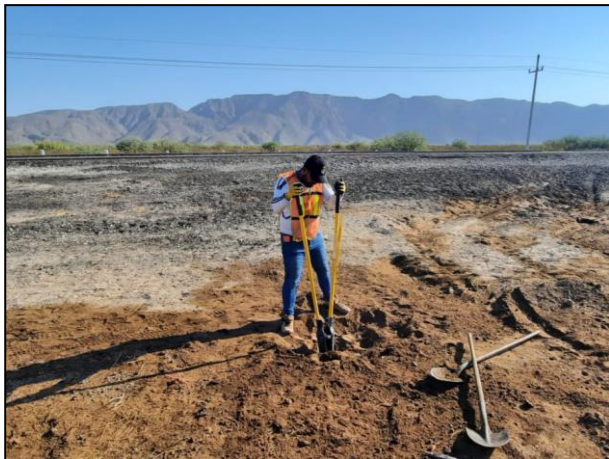
03. Con apoyo de pocera y palas se realizaron sondeos dentro y en las periferias del Área Afectada.
