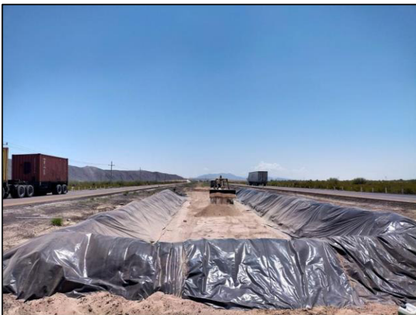
11. Con apoyo de retroexcavadora se distribuyó la segunda capa de arcilla.
