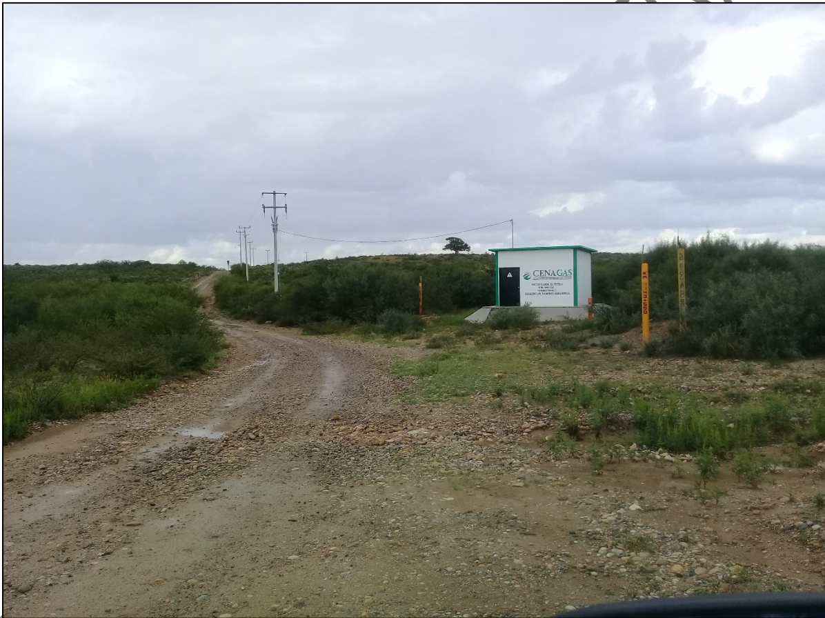
Figura 23 Caseta de Monitoreo y Red de energía de la CFE.
