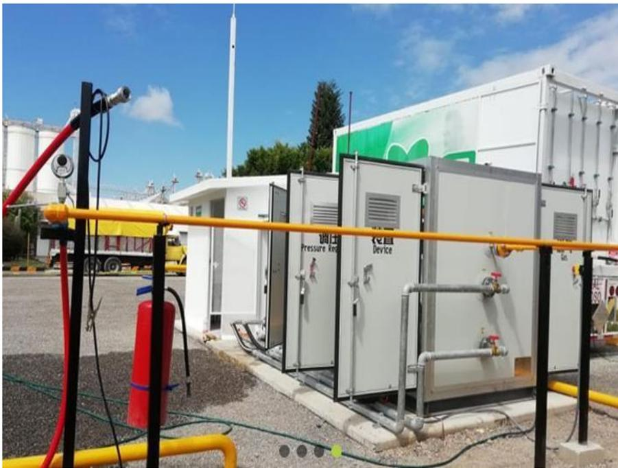
Figure 2. Esquema del Módulo de Regulación de Presión (PRU)
