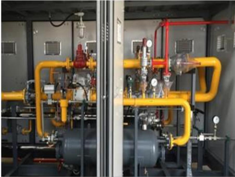
Figure 1. Módulo de Regulación de Presión.
