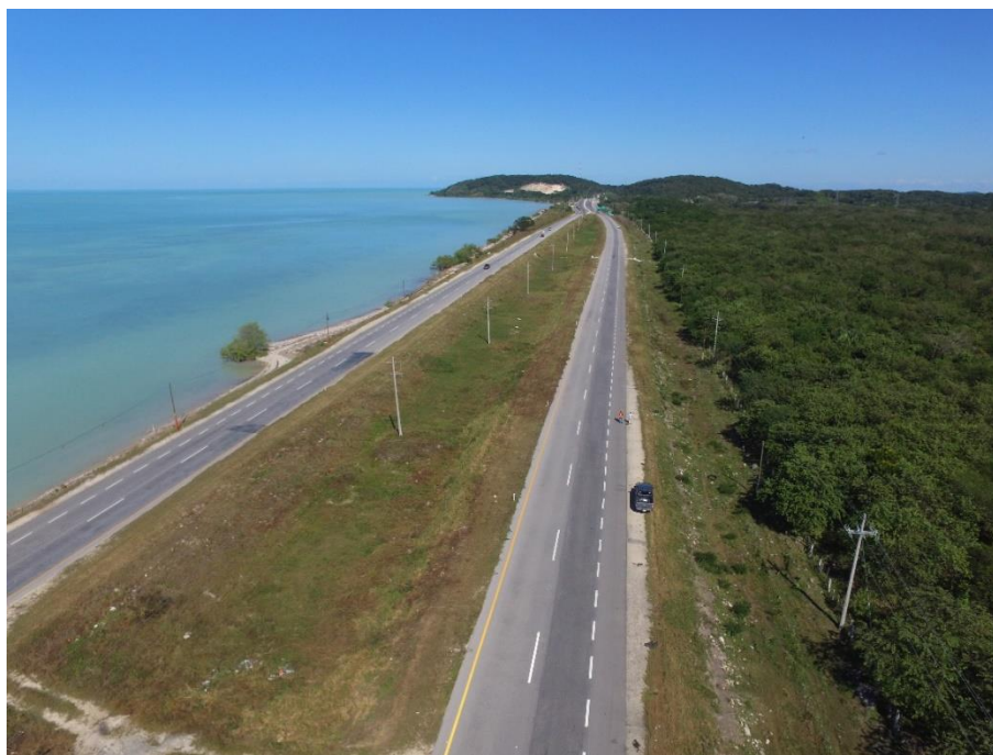
Fotografía 1. Carretera Federal 180 Champotón – Campeche
