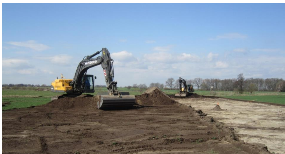
Figura II. 4. Remoción de la capa vegetal
