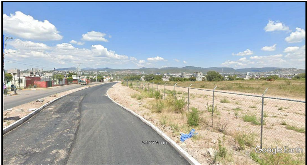
Avenida Plan de San Luis, el predio del proyecto de la La Estación de Servicio se encuentra con terracería cubierta por poca vegetación.
