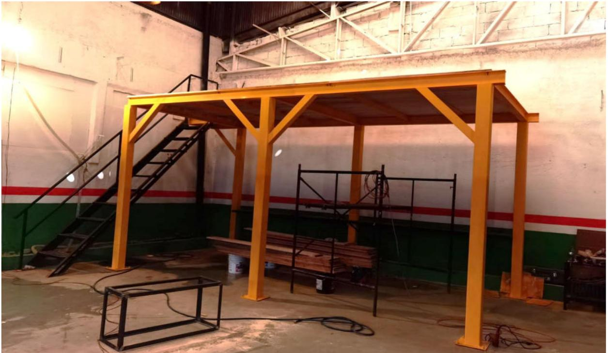
*Foto 6. Al fondo de la bodega se observa ésta estructura metálica que no tiene alguna función estructural, además se tiene madera y andamios que serán retirados.*
