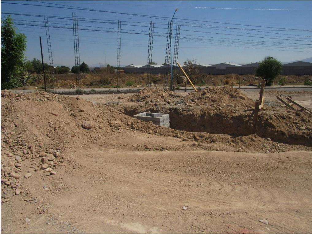
El tepetate producto de las excavaciones es utilizado para cubrir las zanjas.
