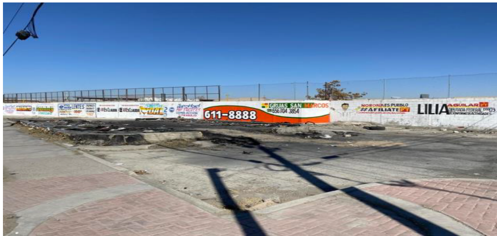
VISTA GENERAL DE LA FACHADA
