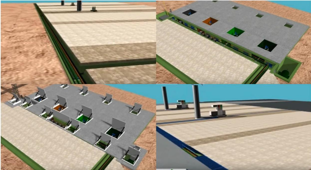
**Fig. 5** *Proceso de terminado en la instalación de los tanques de almacenamiento y sistema de despacho de combustible en la estación (arriba de izquierda a derecha); se colocaron canaletas y tuberías desde los tanques hasta las bombas de despacho. Los tanques están cubiertos con una capa de hormigón para posteriormente poner las cubiertas y sistemas de seguridad para finalmente hacer las conexiones con las bombas de combustible.*
