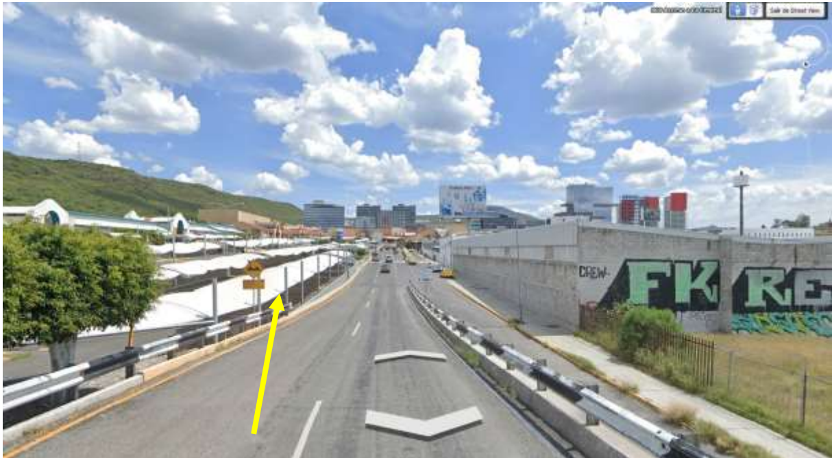
Figura II.9 Vías de Acceso – Vialidad “Acceso a la Central”
