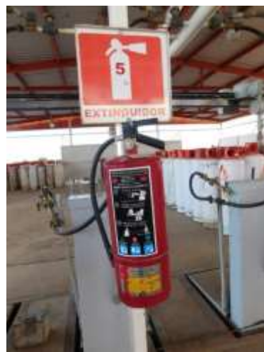
Figura IV.5. Colocación de extintores
