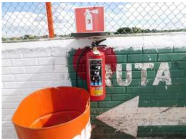
Figura IV.5. Colocación de extintores
