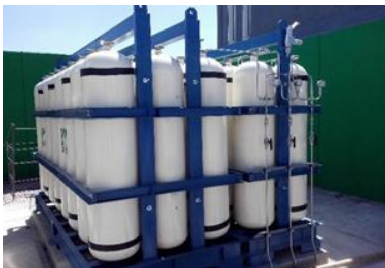
Figura V.2.- Recipientes y/o tanques cilíndricos.
