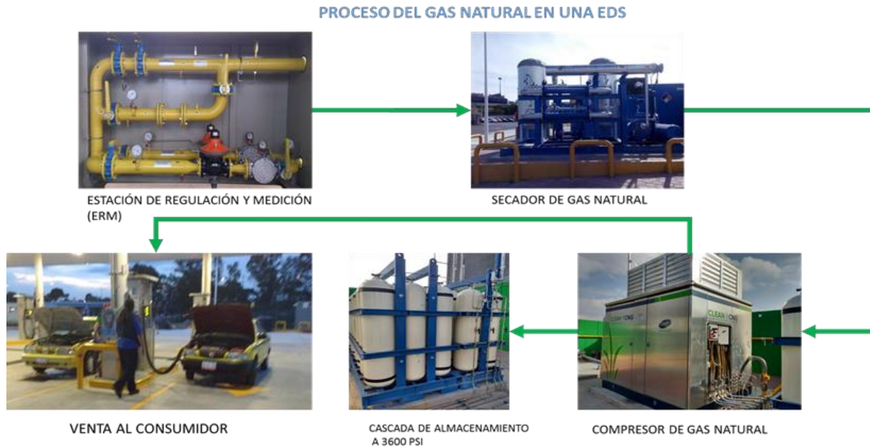
Figura V.1.- Proceso del Gas Natural Comprimido en la Estación de Servicio.
