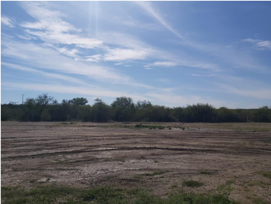
Figura III.29 Vista general del paisaje del cuadro de maniobras de la Localización Pípila-108DEL
