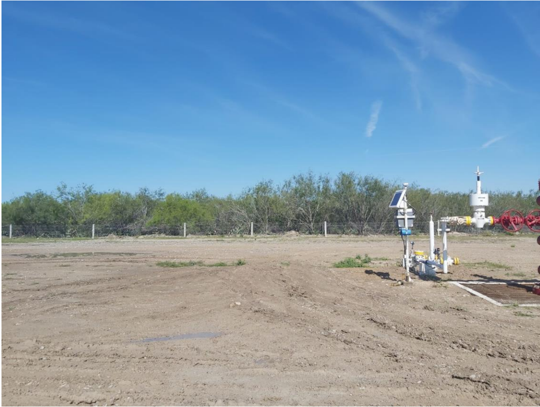
Figura III.26 Vista de suelo expuesto al interior del cuadro de maniobras.
