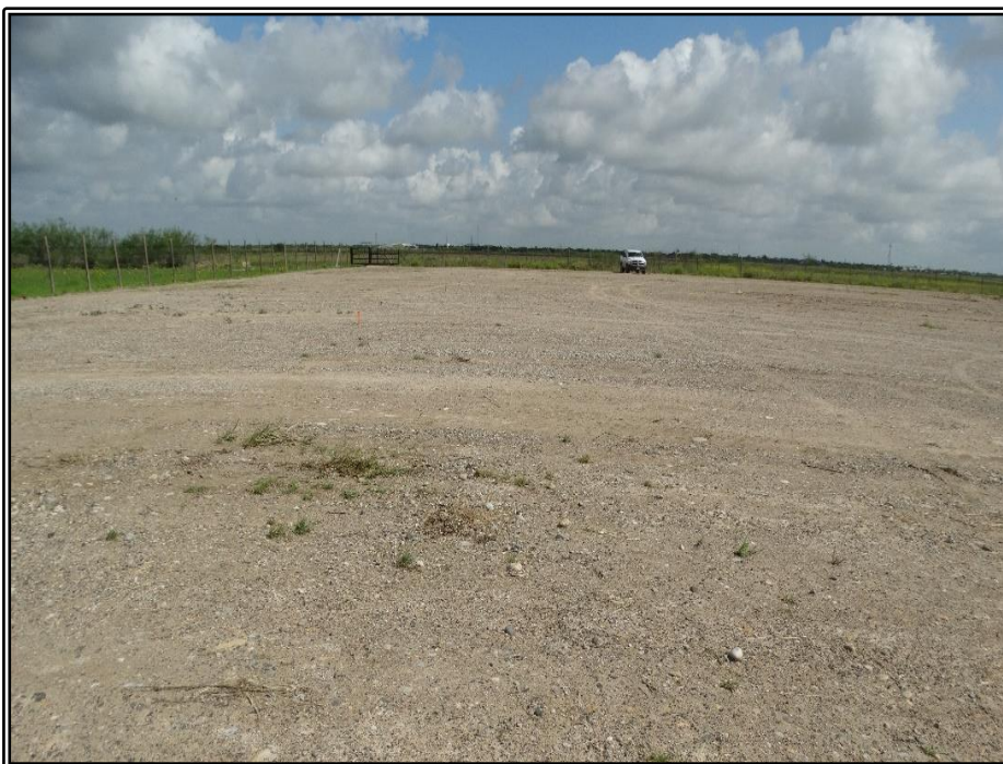
Fotografía I-2.- Plataforma construida para la perforación del pozo Treviño-1EVA.
