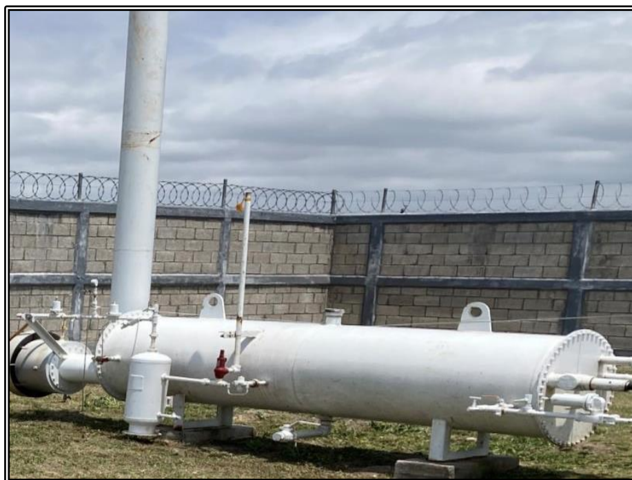
Fotografía III-9.- Calentador tipo CF-0-1EVA.
