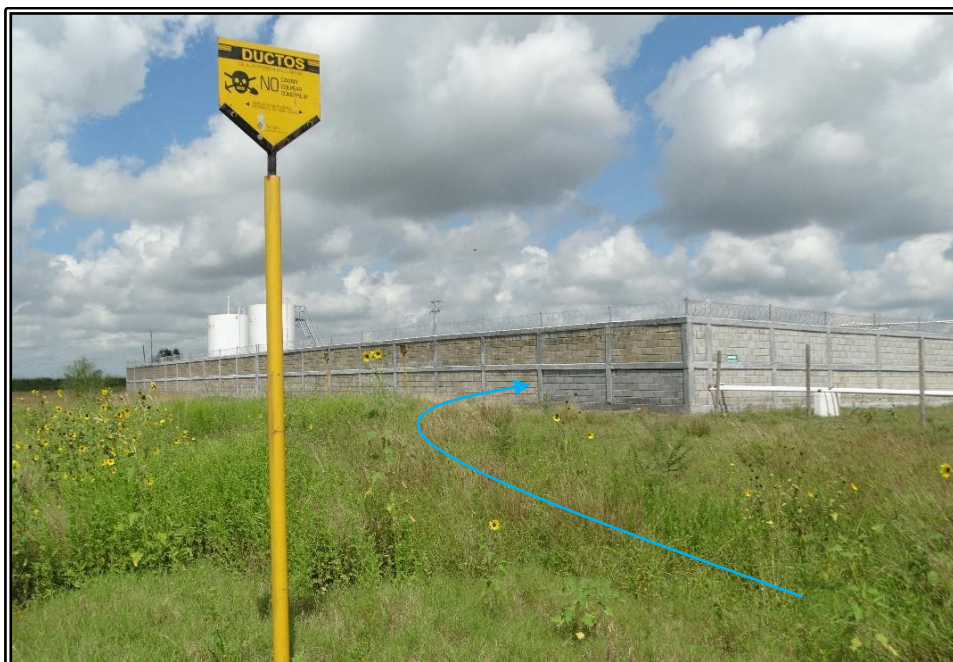
Fotografía III-8.- Llegada a su destino área de separación Treviño BG-02. La longitud total de la LDD es de 400m.
