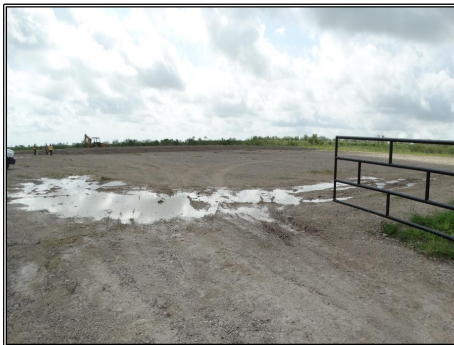
Fotografía III-15.- Acceso a la plataforma, se observa desprovista de vegetación.
