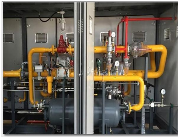
Figura 39 Módulo de Regulación de Presión.
