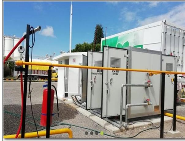
Figura 40 Esquema del Módulo de Regulación de Presión (PRU)
