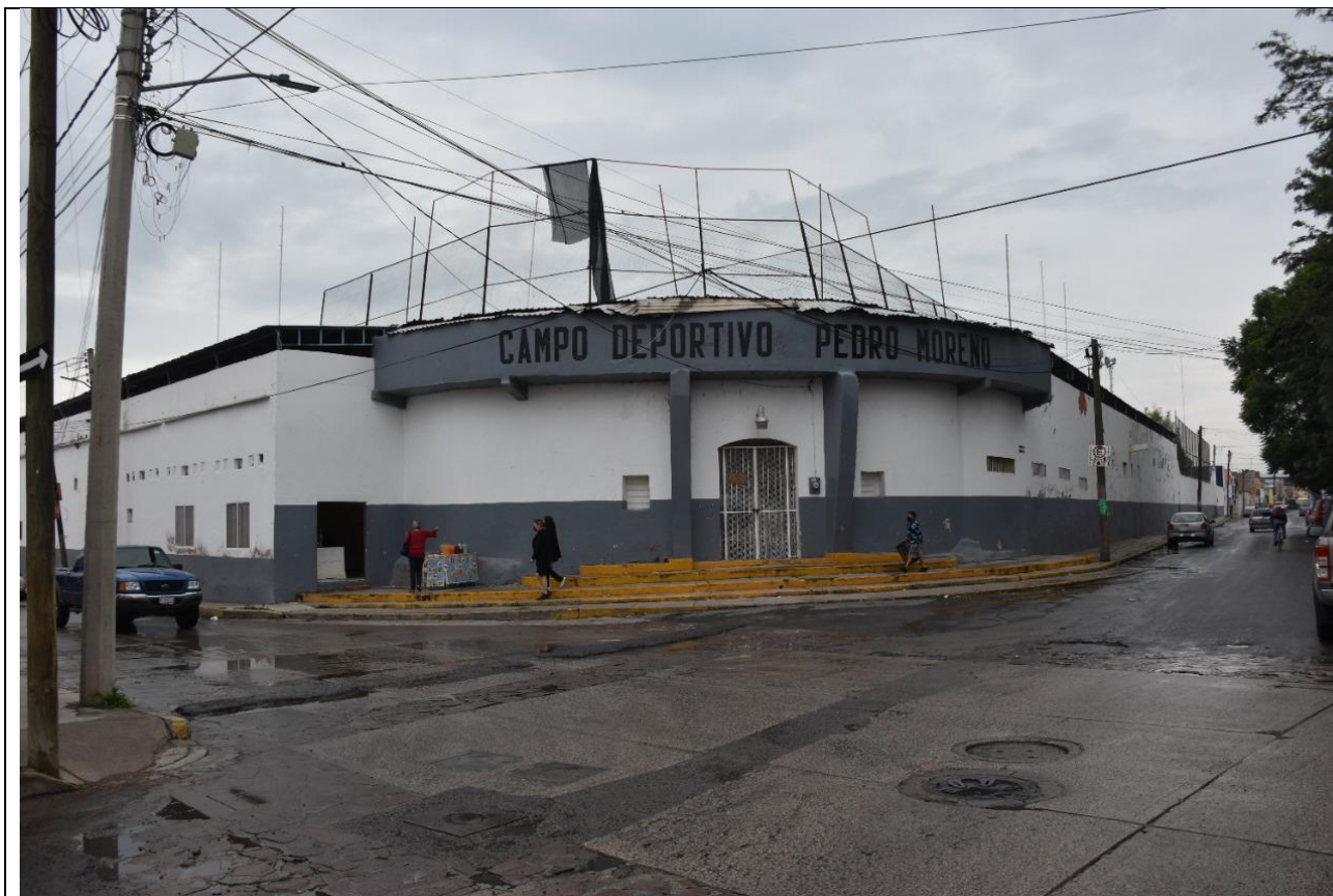
Fotografía No. I.4.- Campo deportivo Pedro Moreno. Los deportivos y estadios representan importantes centros de concentración masiva de personas.
