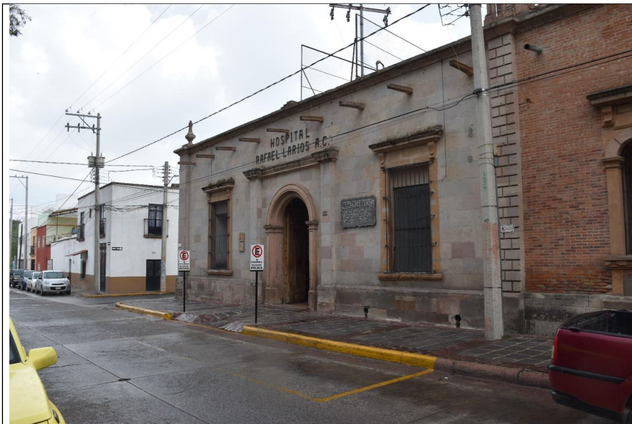
Fotografía No. 1.5.- Hospital Rafael Larios. Los hospitales, además de ser centros de concentración masiva de personas, también representan centros de apoyo externo.
