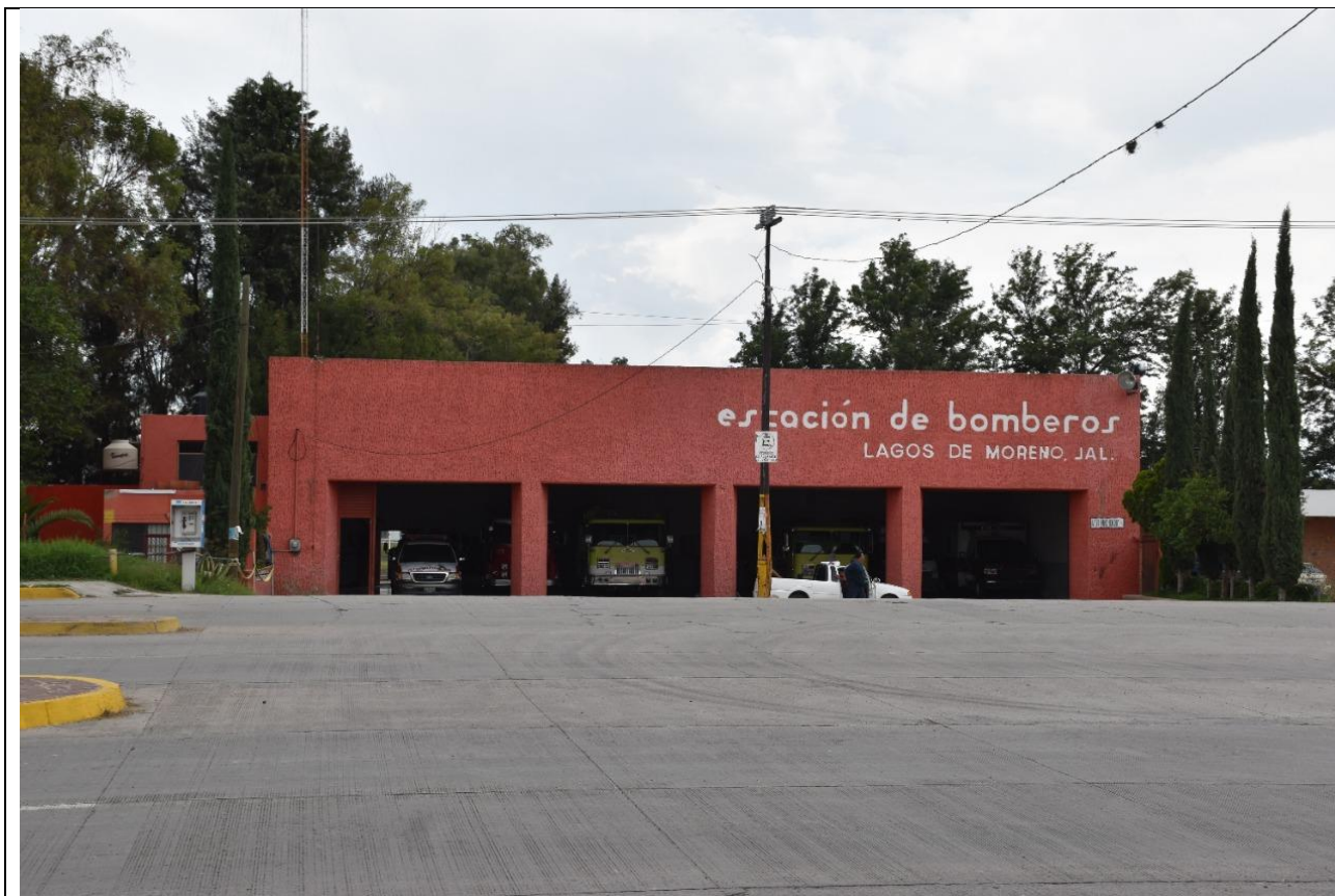
Fotografía No. I.6.- Estación de bomberos de Lagos de Moreno. Estos agrupamientos representan grupos de apoyo externo en caso de emergencia con el gas natural.
