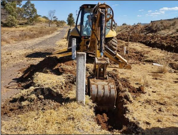
01. Con apoyo de una retroexcavadora se realizó la zanja perimetral para colocar la barrera de contención en el perímetro de la Zona afectada.
