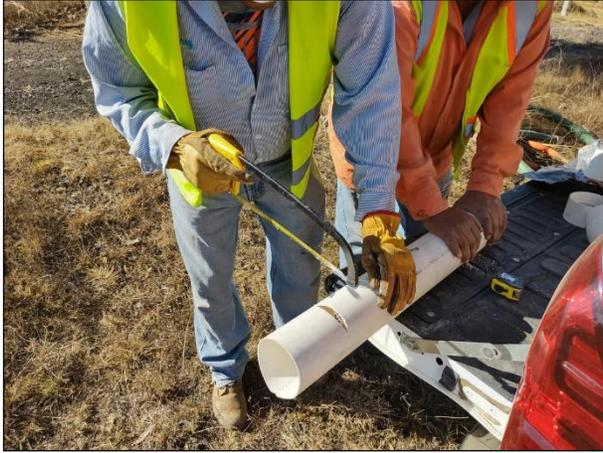
07. Ranuración de los tubos para la instalación de los filtros de carbón activado.
