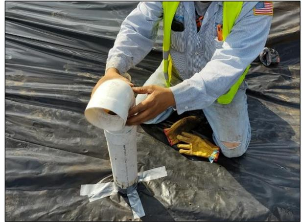
10. Instalación de los filtros de carbón activado.
