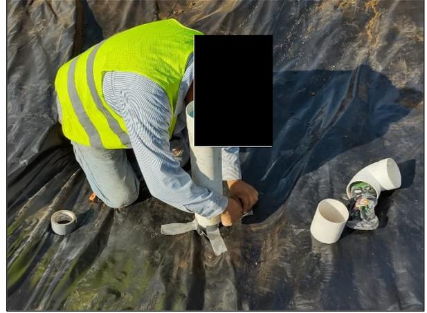
08. Colocación de los tubos para los filtros de carbón activado.
