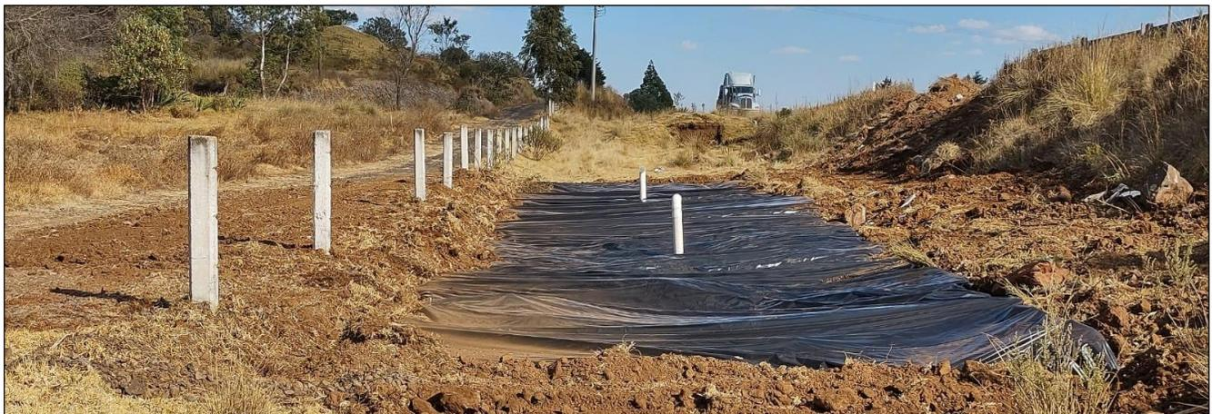
11. Vista de la Zona afectada cubierta con la película de polietileno de alta densidad y los filtros de carbón activado instalados.
