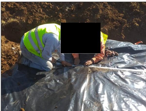
04. Sellado de las uniones de la membrana de polietileno de alta densidad.
