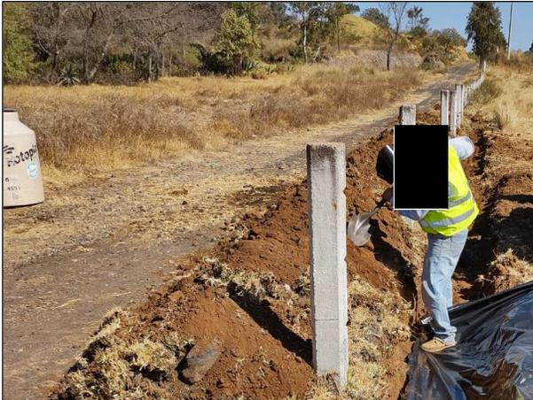
02. Con apoyo de recurso humano se colocó una membrana de polietileno de alta densidad sobre la Zona afectada. .
