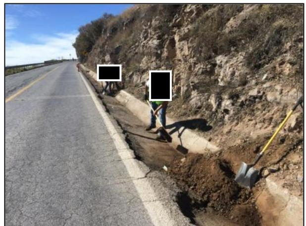
12. Se realizó el retiro del material edáfico azolvado presente en la canaleta de concreto, mismo que fue afectado por el derrame de Diésel Ultra Bajo Azufre.
