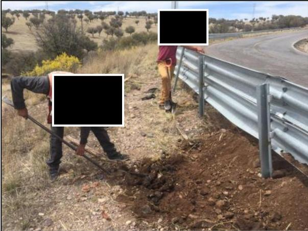
07. Con apoyo de recurso humano se realizó la extracción manual del material edáfico afectado por el derrame del Diésel Ultra Bajo Azufre.
