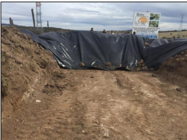
05. Con apoyo de recurso humano se colocó una película de polietileno de alta densidad sobre la base la celda provisional.
