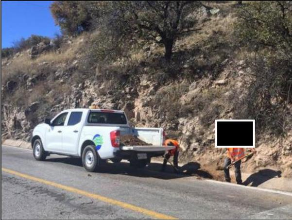
13. El material edáfico azolvado presente en la canaleta de concreto fue retirado para su acarreo hacia celda provisional.
