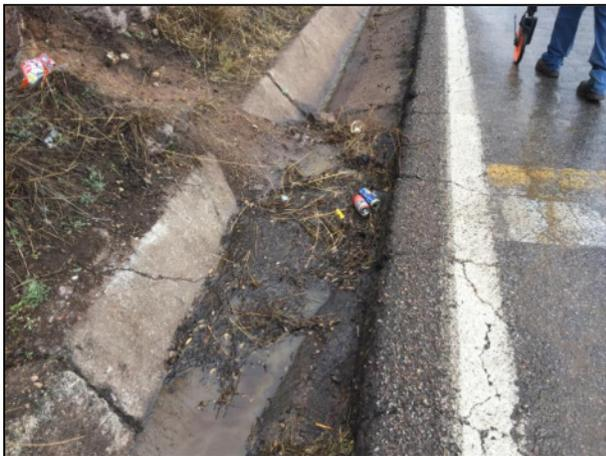
03. Canaleta de concreto con presencia de material azolvado, mismo que fue afectado por el derrame del hidrocarburo.
