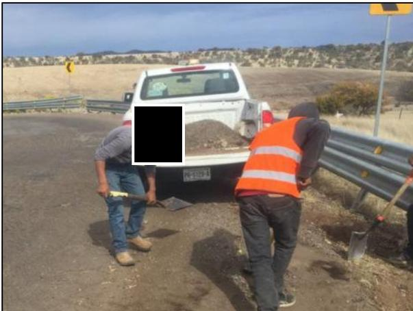
09. El material edáfico afectado extraído fue colocado en vehículo de transporte, para su posterior acarreo hacia la celda provisional.
