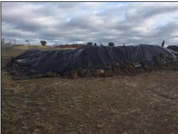
17. La celda fue cubierta con una película de polietileno de alta densidad a fin de evitar la dispersión del material edáfico afectado.
