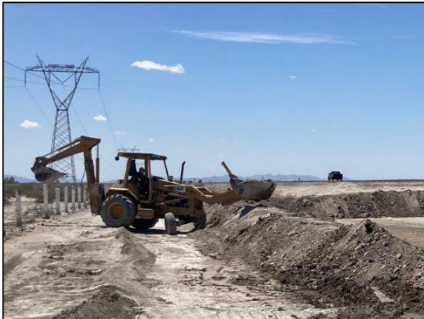
03. Con apoyo de retroexcavadora se construyeron los bordos perimetrales de la celda provisional.
