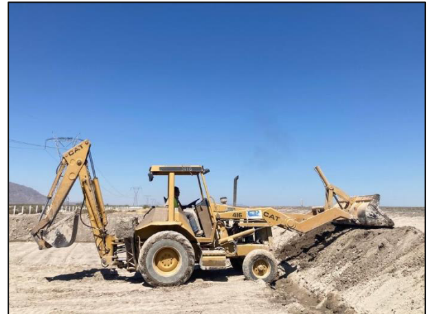
04. Compactación de bordos perimetrales con apoyo de retroexcavadora.
