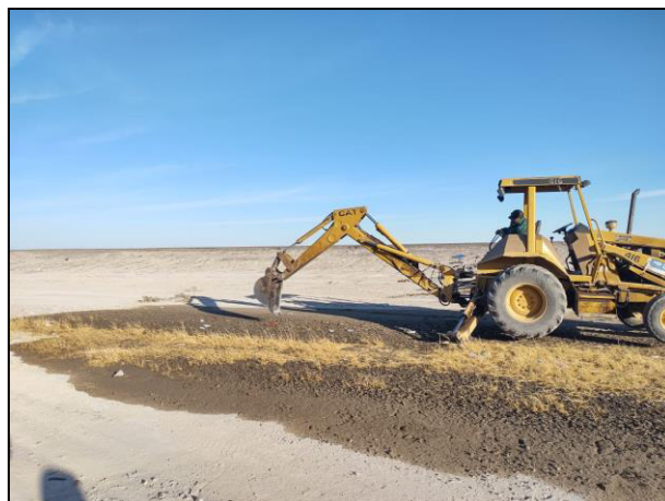
04. Con apoyo de retroexcavadora se realizaron sondeos dentro y en las periferias del sitio afectado debido a la infiltración alta que se determinó en el sitio.
