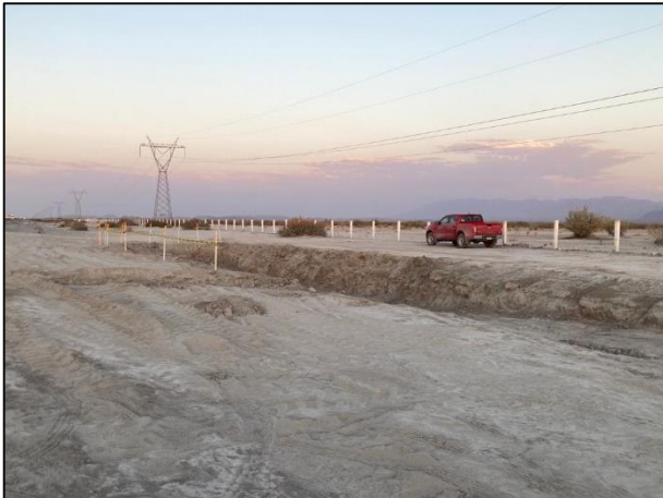
21. Vista general de la fosa de excavación.
