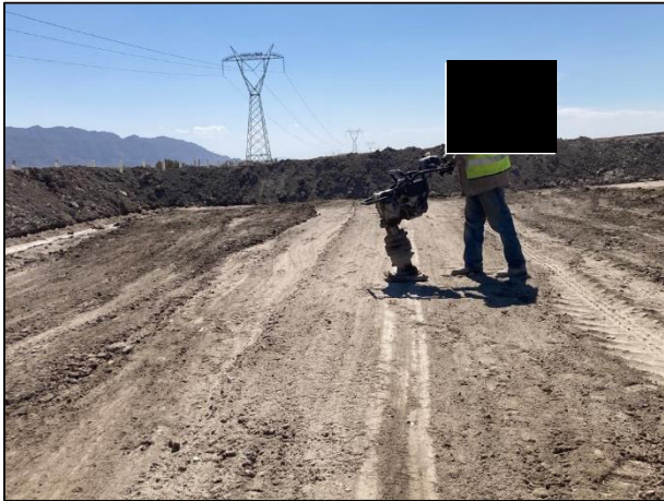
07. Con apoyo de vibro compactador manual se realizó la compactación de la capa de arcilla.
