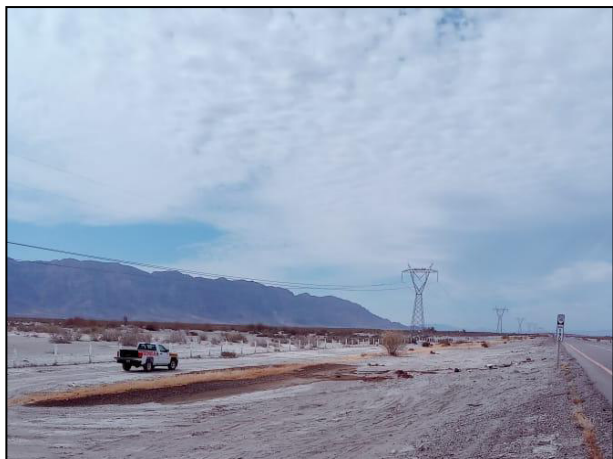
01. Derecho de vía a la altura del Km. 190 de la Carretera Federal No. 40 tramo La Cuchilla – Torreón, municipio de Parras, estado de Coahuila.
