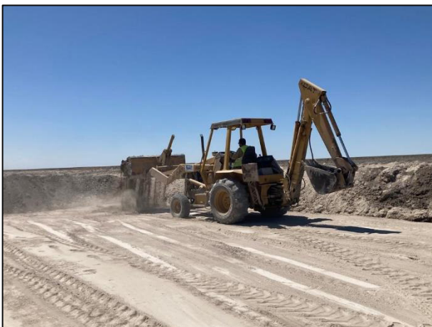
05. Se colocó una capa de arcilla sobre la base de la celda provisional.
