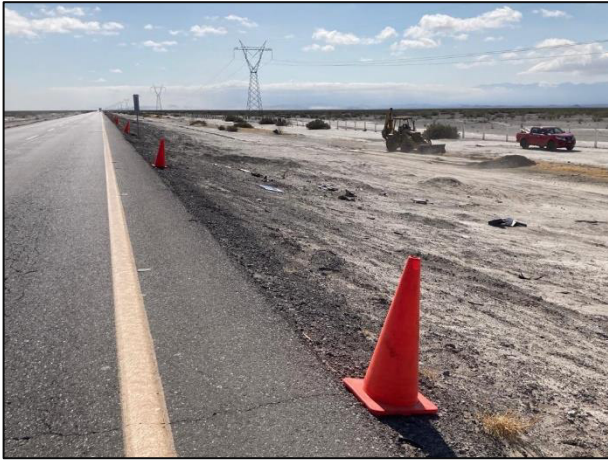
01. Se realizó el acondicionamiento del sitio para la construcción de la celda provisional. Señalización preventiva en el área de trabajo.
