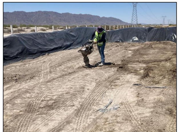
12. Compactación de capa de arcilla.
