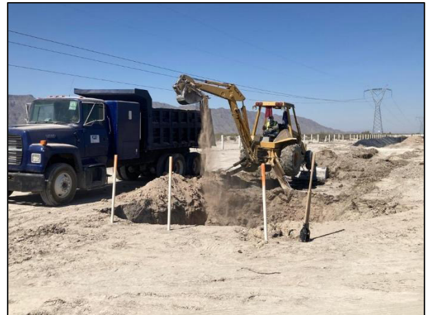
14. Actividades de extracción en el sitio afectado por el hidrocarburo derramado.
