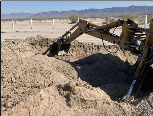
13. Con apoyo de retroexcavadora se realizó la extracción del material edáfico afectado con Diésel Automotriz.
