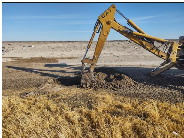
05. Realización de sondeos con apoyo de maquinaria pesada a fin de determinar la infiltración del hidrocarburo.
