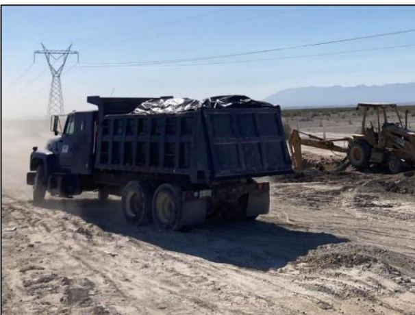
17. El material se mantuvo cubierto con una película de polietileno de alta densidad durante el acarreo y depósito en dicha celda.
