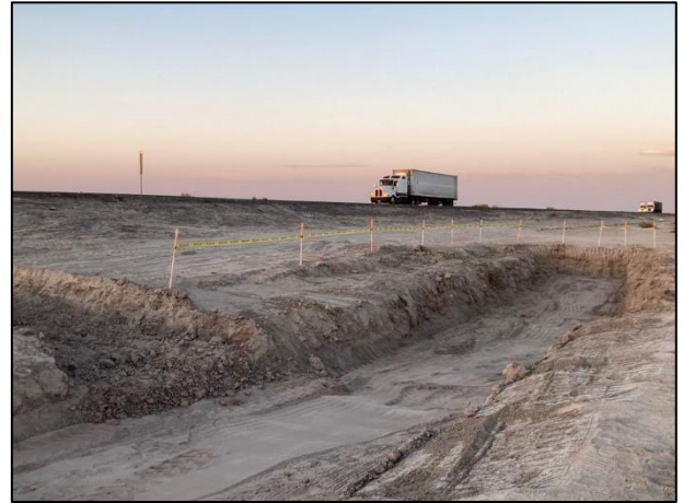
20. Se colocaron tubos y cinta amarilla preventiva en la fosa de excavación.
