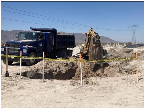
15. Extracción de material edáfico afectado.
