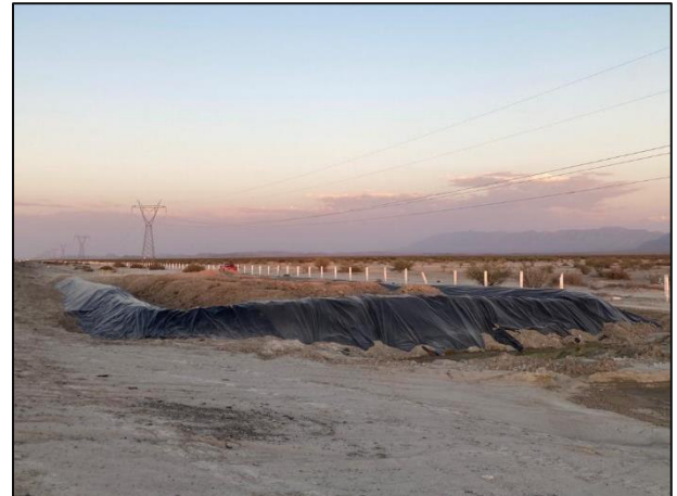
22. Vista final de la celda provisional.
