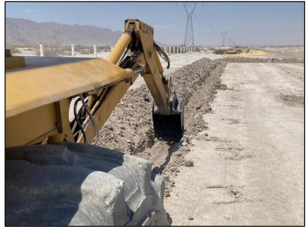
02. Construcción de canaletas de captación de lixiviados.
